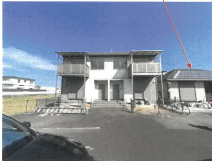
物件 4 南側の状況
