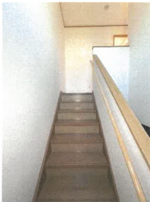
物件 4 西側居宅階段の状況
