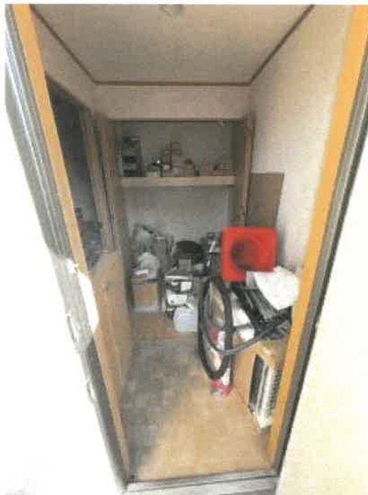
物件 4 西側居宅玄関内の状況
