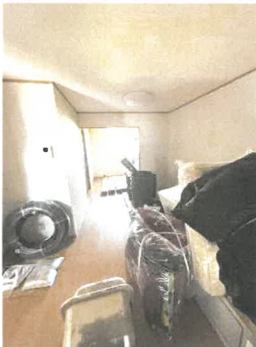
物件4 東側居宅1階洋室北側の状況
