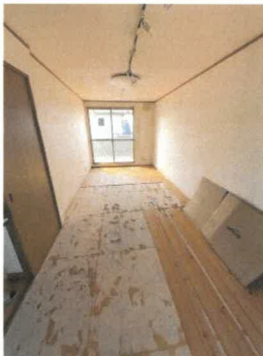
物件 4 西側居宅 2 階西側洋室の状況
