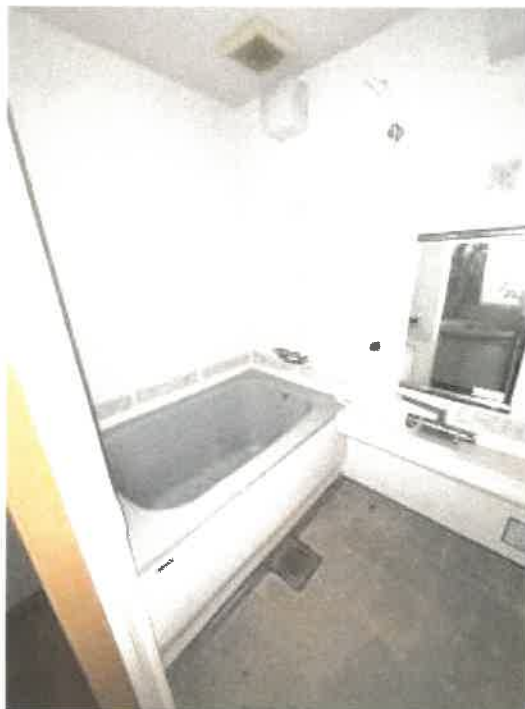
物件4 東側居宅1階浴室の状況
