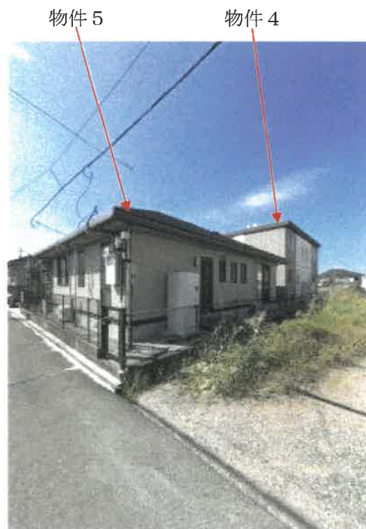
本件物件の北東側の状況
