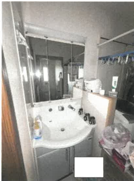
物件 5 洗面所の状況
