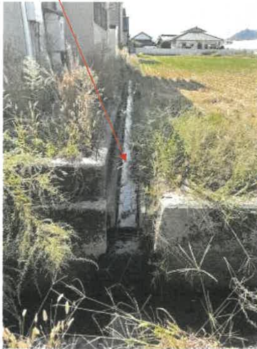
物件 2 用悪水路の状況
