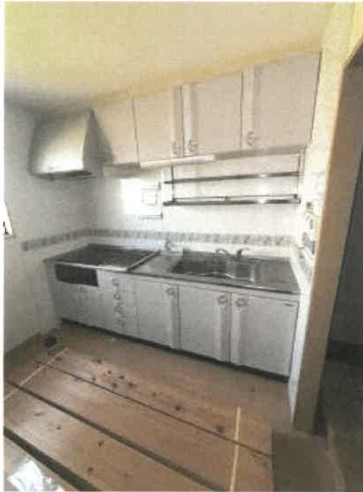
物件4 東側居宅1 階台所の状況
