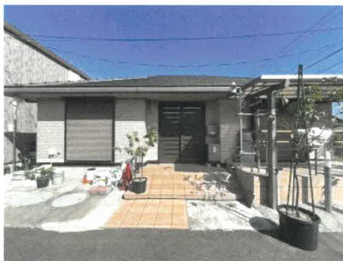
物件5 南側の状況
