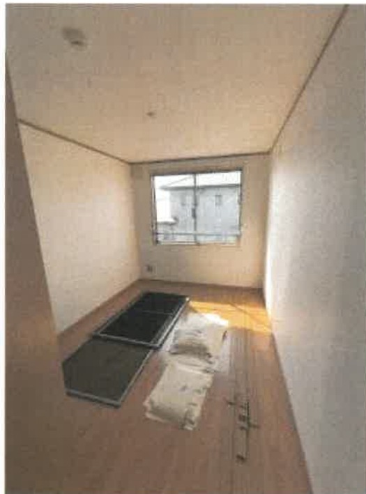
物件 4 西側居宅 2 階南東側洋室の状況
