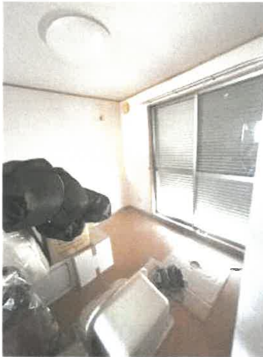
物件4 東側居宅1階洋室南側の状況
