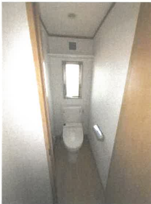
物件4 西側居宅1階トイレの状況
