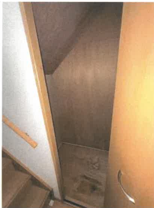
物件 4 西側居宅階段の状況
