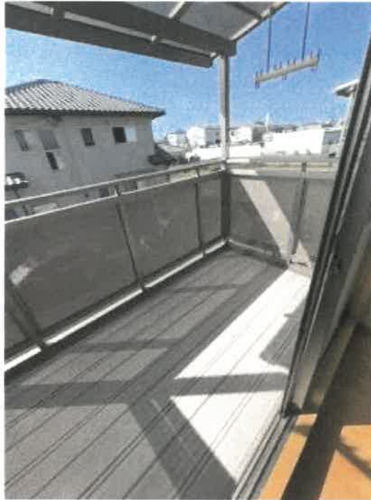
物件 4 東側居宅 2 階ベランダの状況
