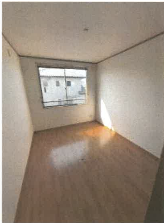
物件 4 東側居宅 2 階南西側洋室の状況
