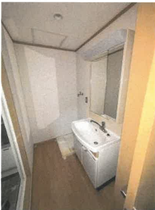
物件 4 西側居宅 1 階洗面所付近の状況
