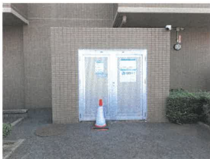
ゴミ置場の状況
