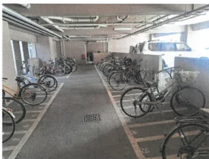
駐輪場の状況
