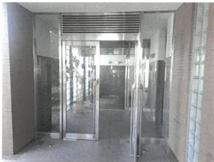
エントランスの状況
