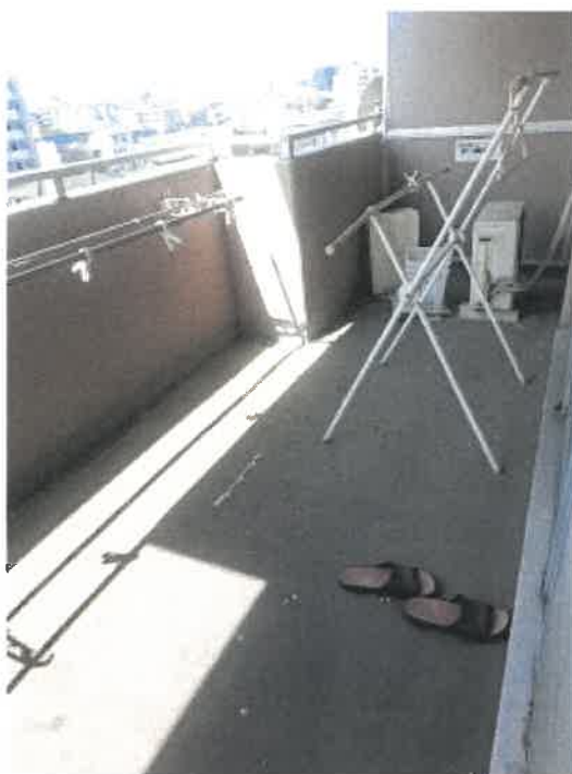
受命物件（603号室）のベランダの状況
