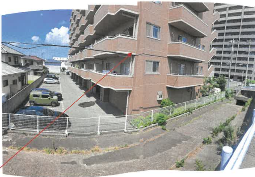
受命物件 (603号室) の存在するマンション南側 (駐車場) の状況 受命物件 (603号室) の存在するマンション
