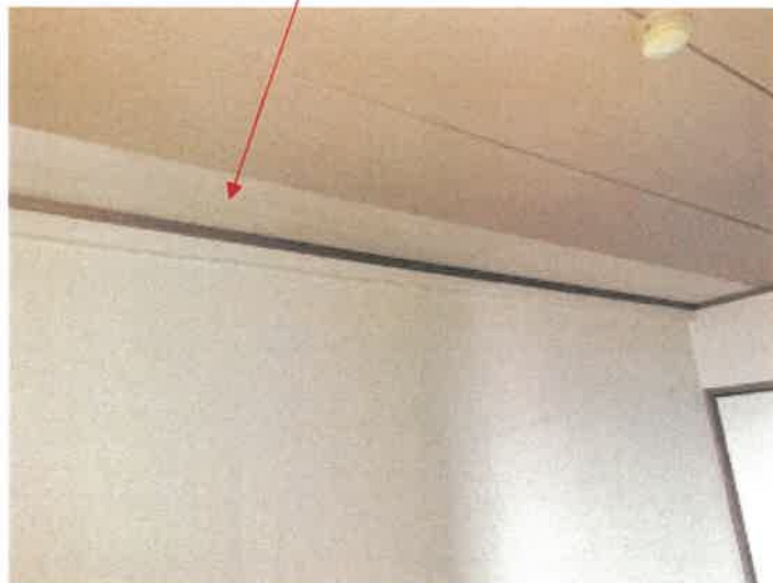
受命物件（603号室）の和室天井の一部張り替えている状況
