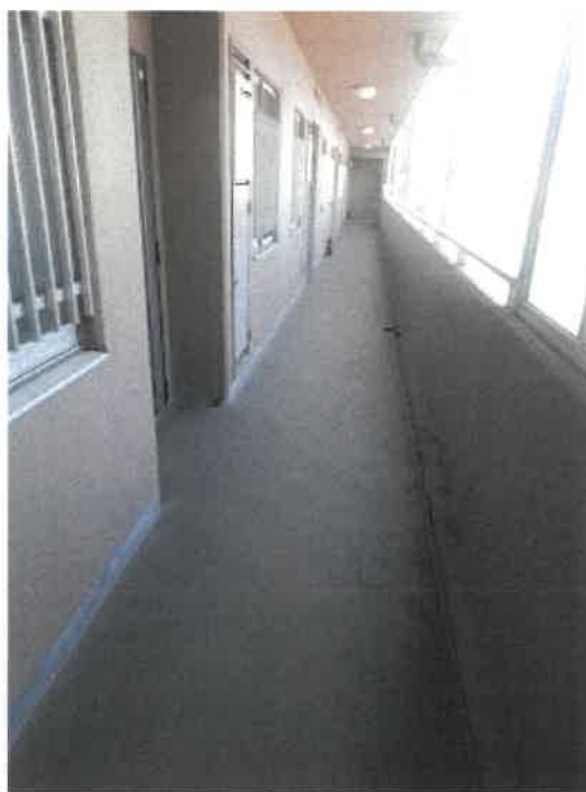
受命物件（603号室）の玄関前外廊下の状況
