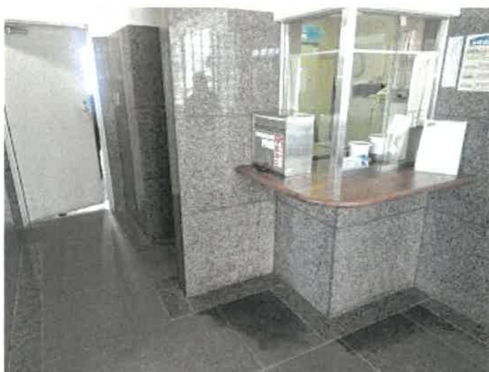
管理人室周りの状況
