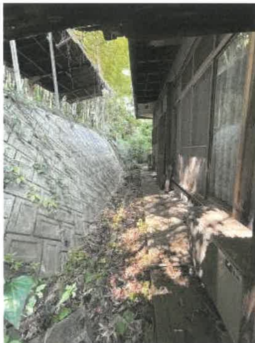
物件1 南側の状況
