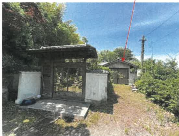
物件1 門扉付近の状況
