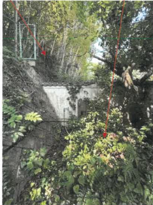
物件 1 南東側法面の状況
