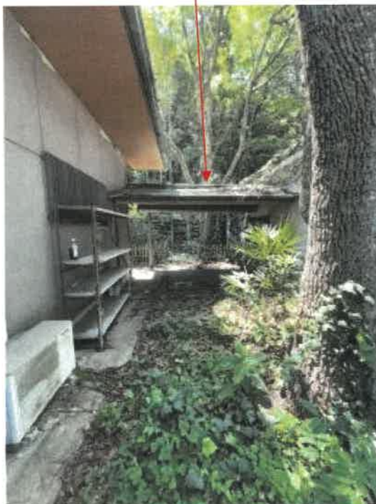
物件 2 主である建物西側の状況
