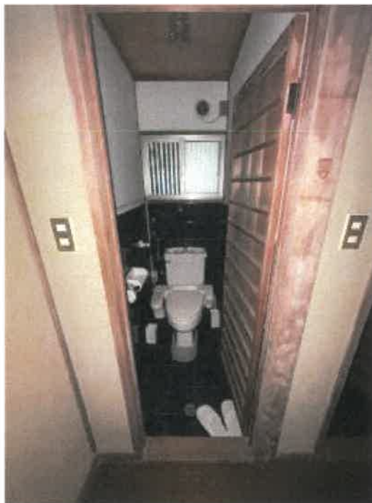
物件2 トイレの状況
