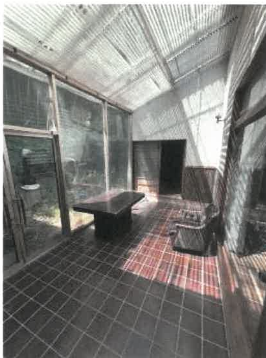
南側テラスの状況
