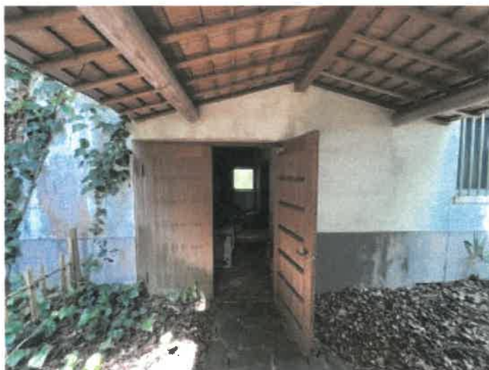
物件2 附属建物符号2（倉庫）入口付近の状況
