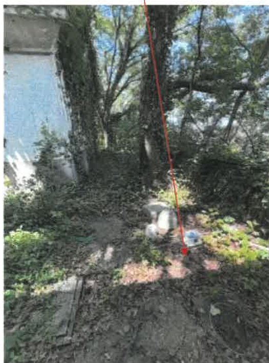
物件 2 附属建物 2 北側の状況
