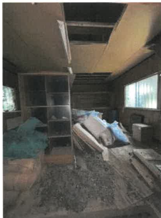
物件2 倉庫内の状況
