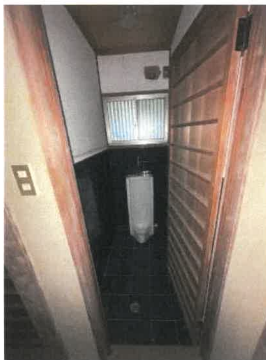
物件2 トイレの状況
