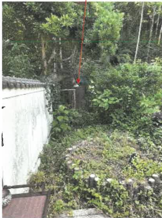
物件1 灯油タンク付近の状況
