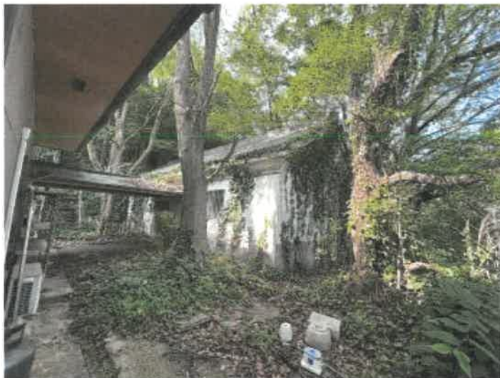
物件2 附属建物符号2（倉庫）の状況
