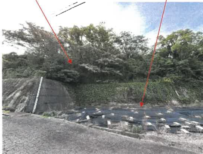
物件 1 北西側の状況
