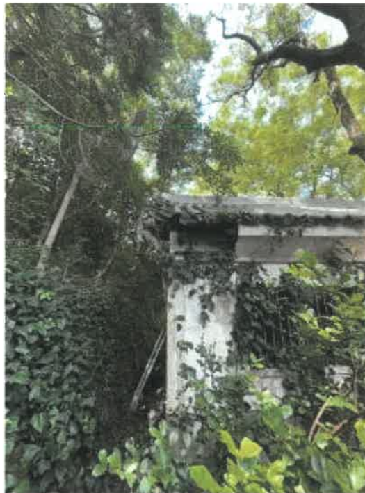
物件 2 附属建物 2 倉庫の南東側の状況
