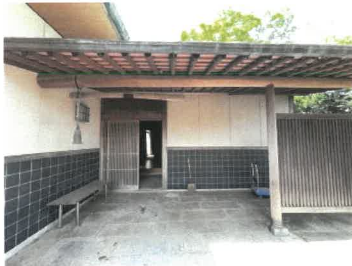
物件2 主である建物玄関付近の状況
