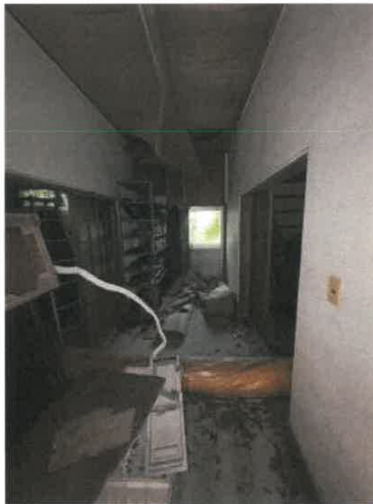
物件2 倉庫内の状況
