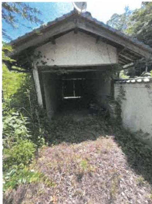
物件2 附属建物符号1（車庫）内の状況
