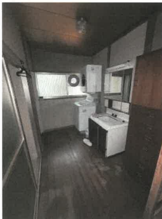
物件2 洗面脱衣所付近の状況
