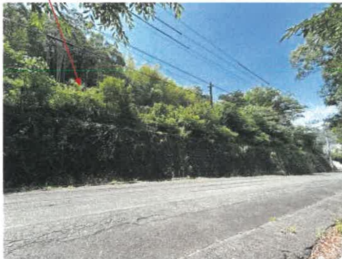
物件 1 北側付近の状況
