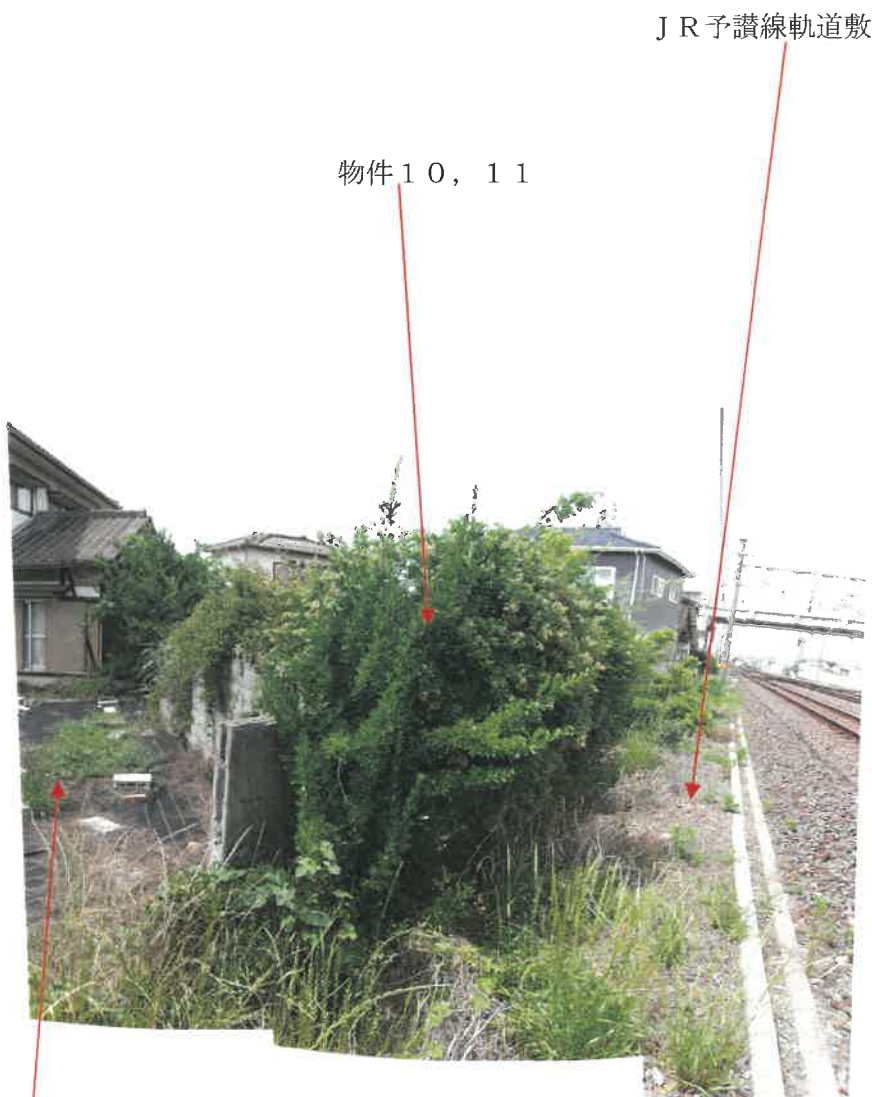
物件 1 0, 1 1 土地南東側及び南西側境界付近の状況
