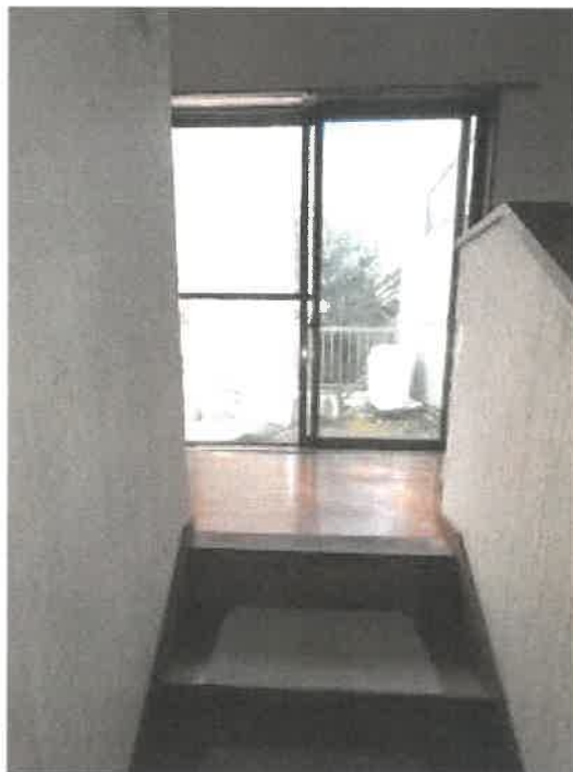
物件2 2階廊下の状況
