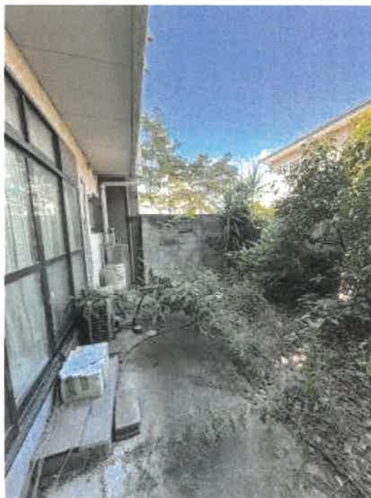
物件 1 北西側の状況
