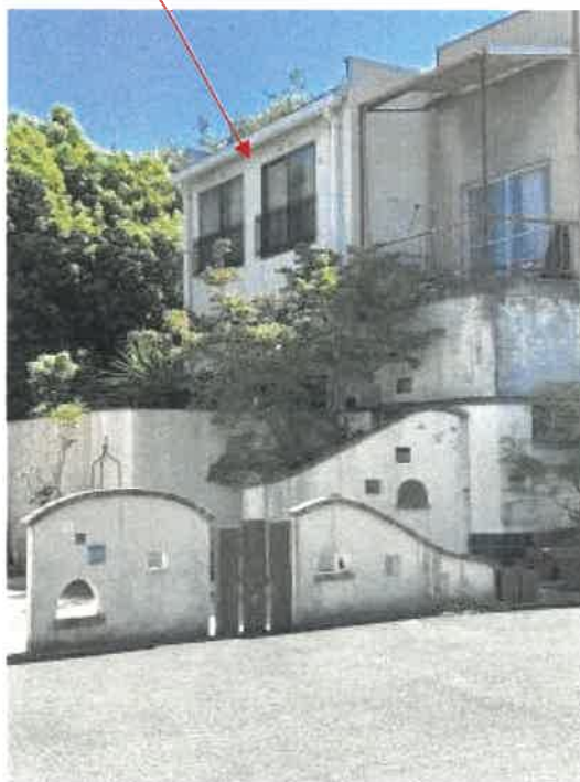
本件物件の北西側の状況
