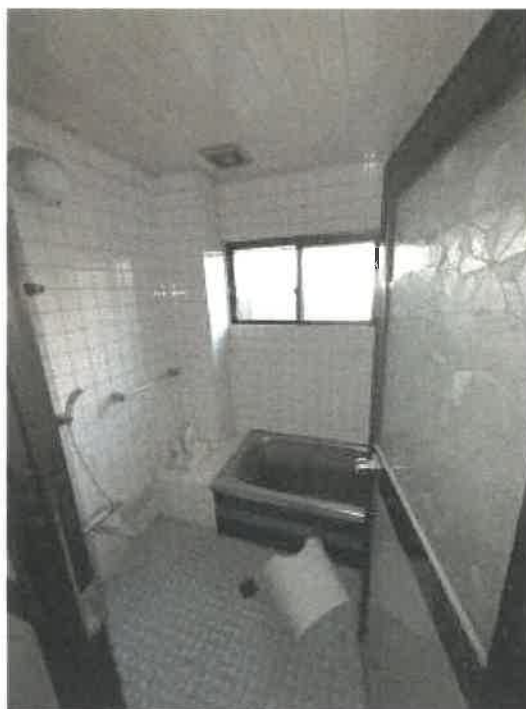
物件2 1階浴室の状況
