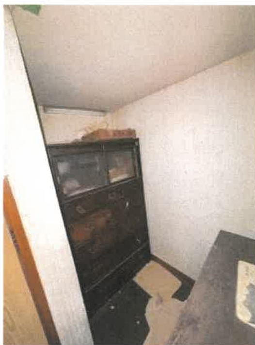
物件2 1階階段下収納の状況
