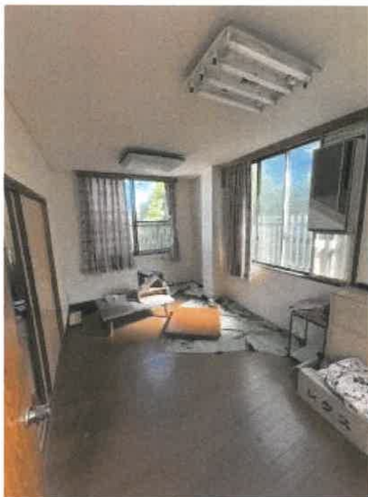
物件2 2階北側洋室の状況
