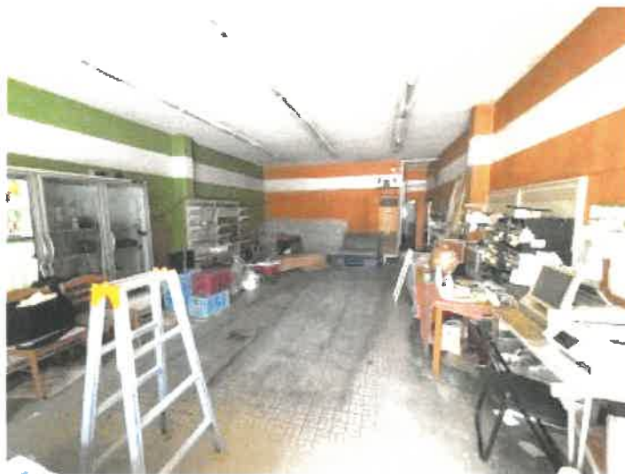
物件2 1階店舗内の状況
