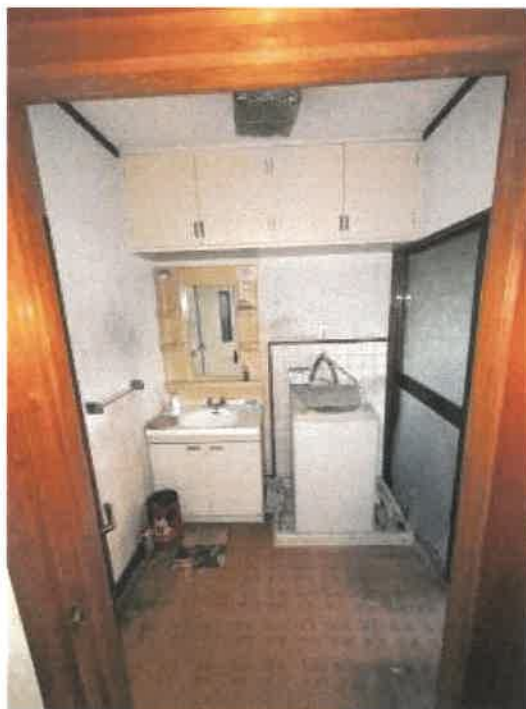
物件2 1階洗面所・脱衣所の状況
