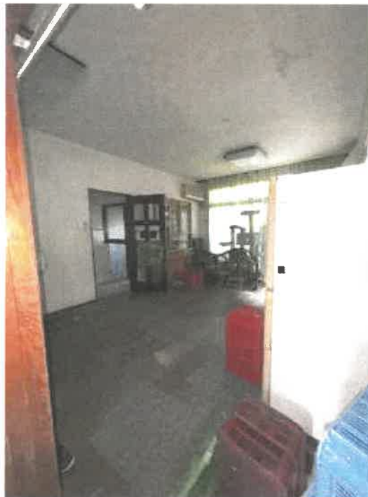
物件2 1階リビングダイニングの状況
