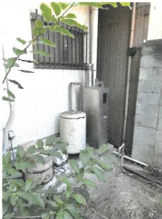
物件1 北西側の状況
