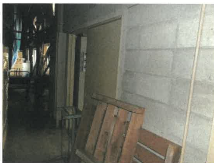
物件14建物の1階東側ゾーンの工場内の機械室出入口の状況
