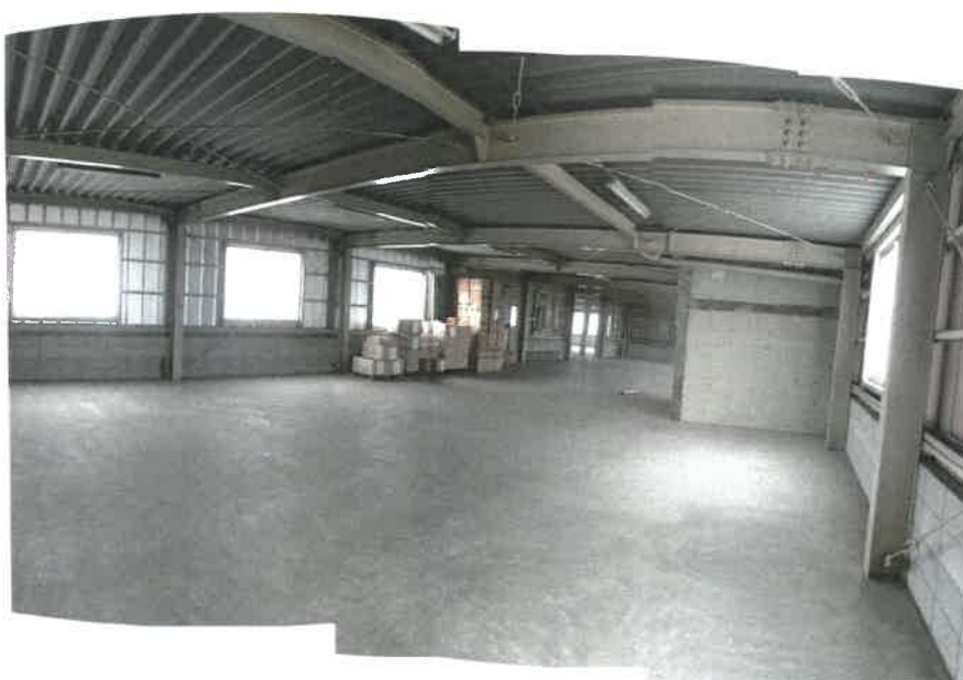
物件14建物の東側ゾーン南側3階倉庫の状況
