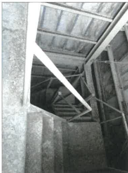
物件 1 4 建物の西側ゾーン北側屋上リフト機械室（鳩小屋状態で建物の一部ではない）から 3 階への階段の状況
