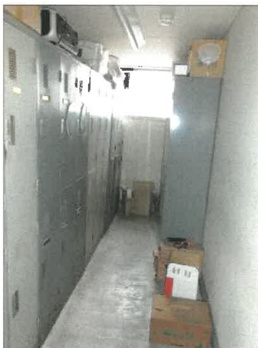
物件 1 4 建物の 1 階中央北の休憩室（事務室）の西側ロッカーの状況
