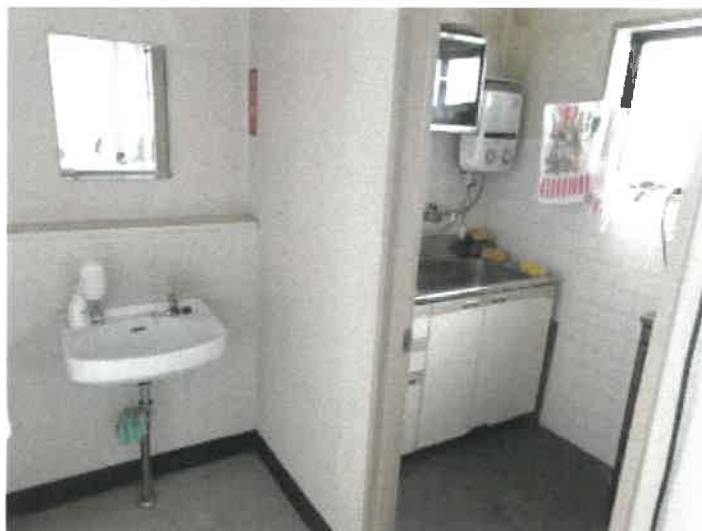
物件14建物の2階中央付近の事務室西側の給湯室の状況
