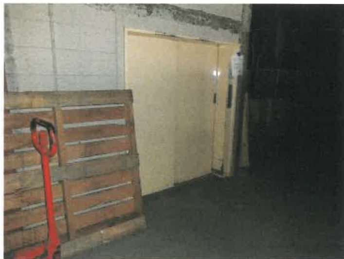
物件14建物の1階東側ゾーンの工場内のリフトの状況
