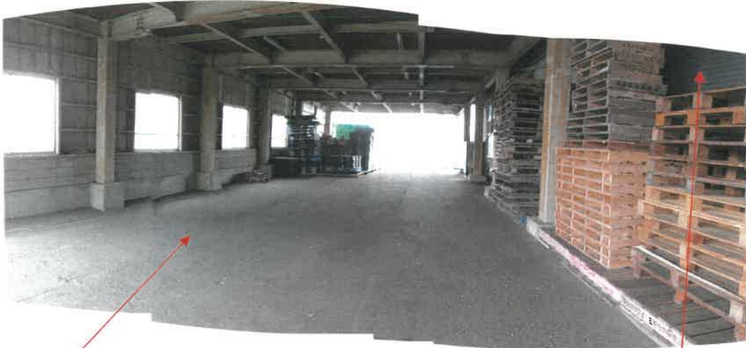
物件 1 4 建物の 1 階北側ピロティー部分の状況
