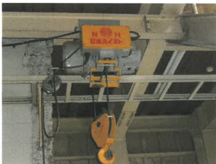
物件 1 4 建物の 1 階西側ゾーンの工場内の北側のリフト前の天井走行用クレーンの状況
