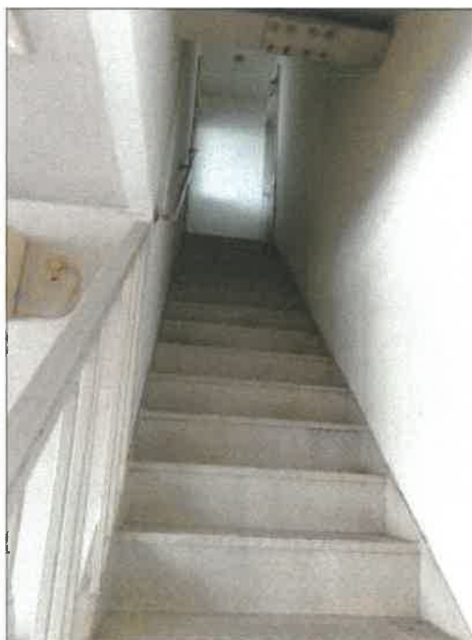
物件 1 4 建物の中央の 2 階から 1 階への階段（事務室南側）の状況
