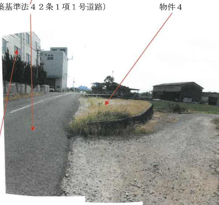
物件 4 土地南側及び北東側境界付近の状況
