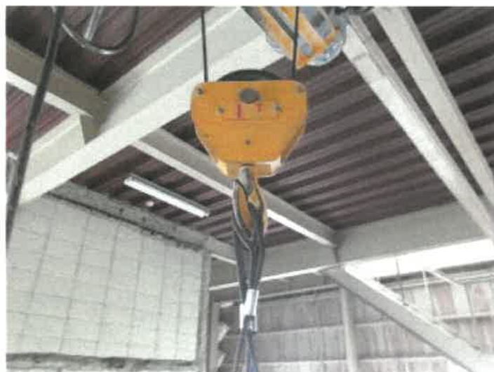
物件14建物の2階西側ゾーン工場内の天井走行用クレーンの状況
