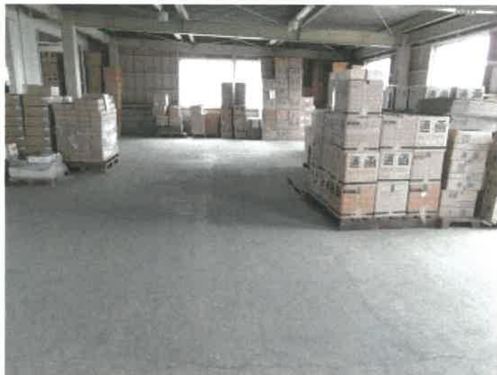
物件14建物の東側ゾーン北側3階倉庫の状況
