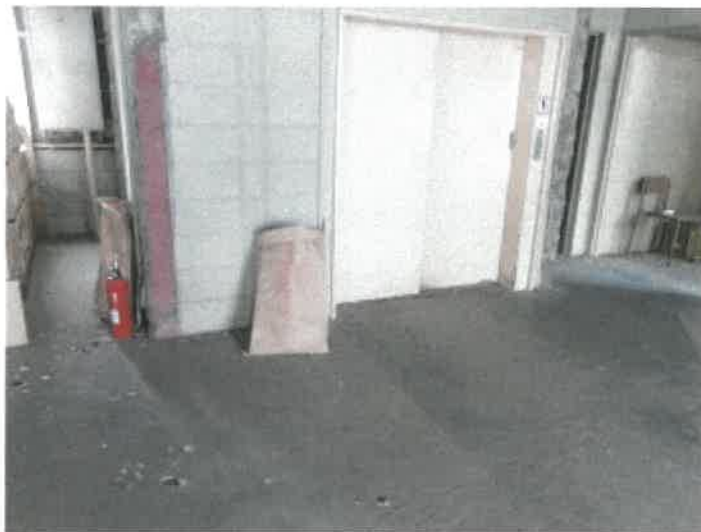
物件 1 4 建物の 3 階西側ゾーン倉庫内の北側のリフトの状況
