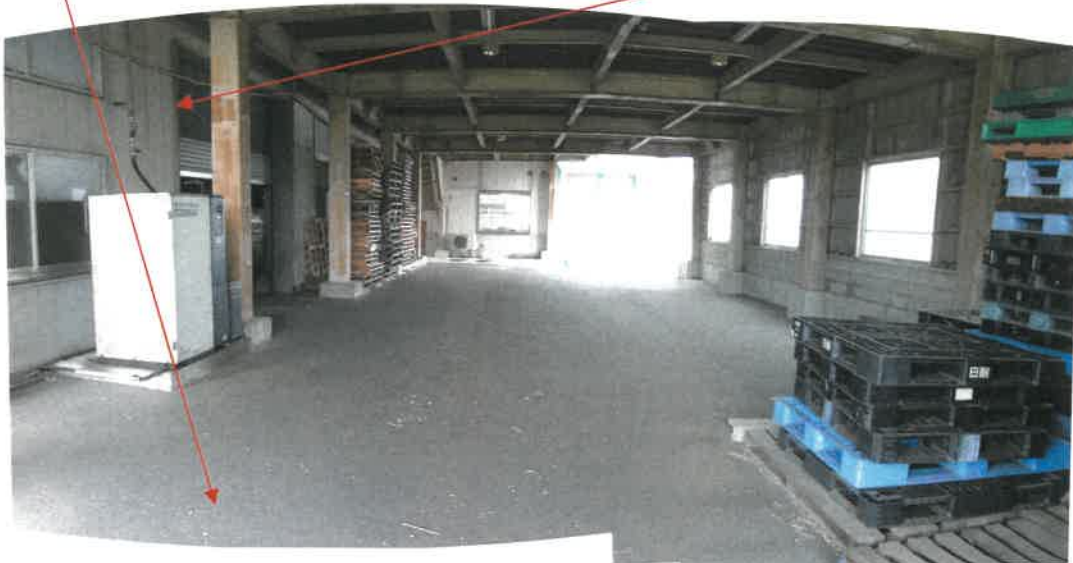
物件 1 4 建物の 1 階北側ピロティー部分の状況
