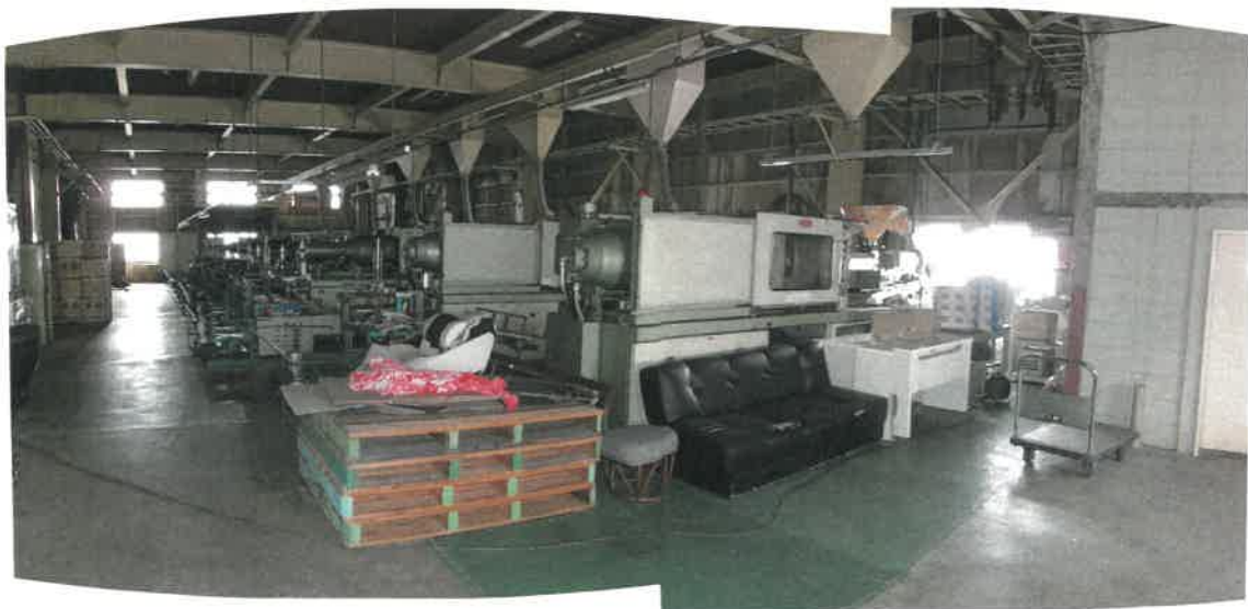
物件 1 4 建物の 1 階西側ゾーンの工場内の機械器具類の状況 (「工場抵当法第 2 条に該当する機械器具類等目録」記載の番号 1 ～ 8)
