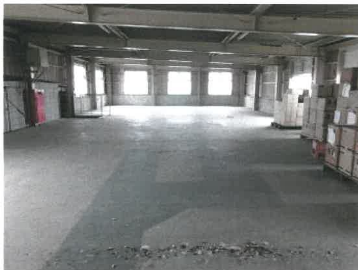
物件14建物の3階西側ゾーン倉庫内の状況
