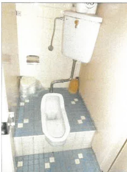
物件1 4 建物の1 階中央北の休憩室（事務室）の西方のトイレの状況
