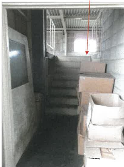
物件 1 4 建物の東側ゾーン 3 階から西側ゾーン 3 階への階段の状況
