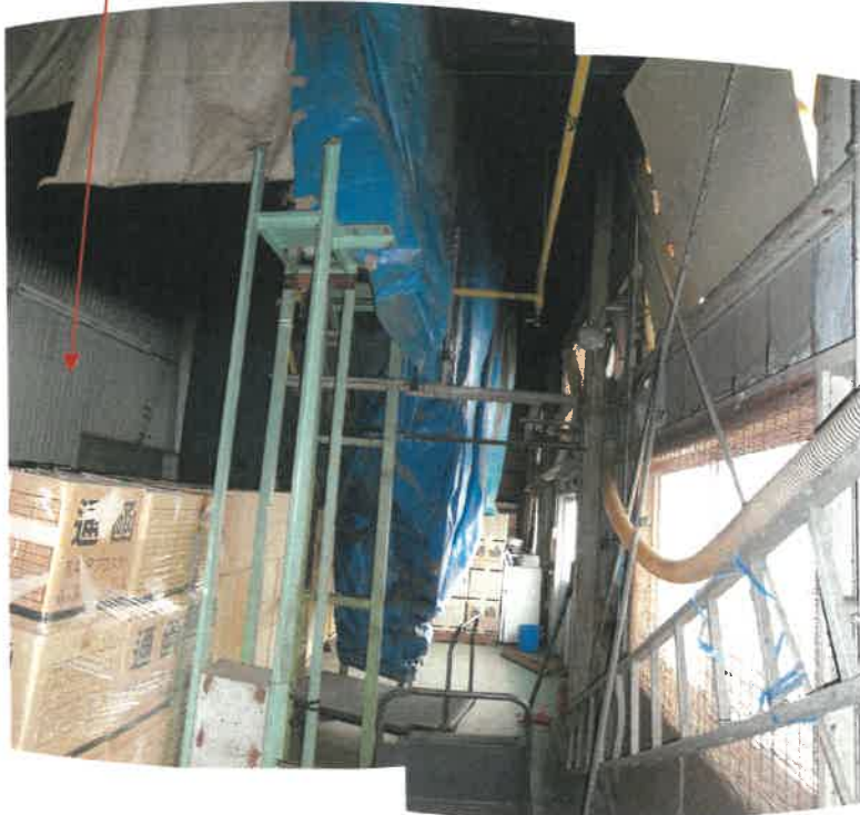
物件14建物の1階東側ゾーンの工場内のリフト及び機械室南側の状況
