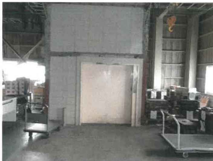
物件 1 4 建物の 1 階西側ゾーンの工場内の北側のリフトの状況
