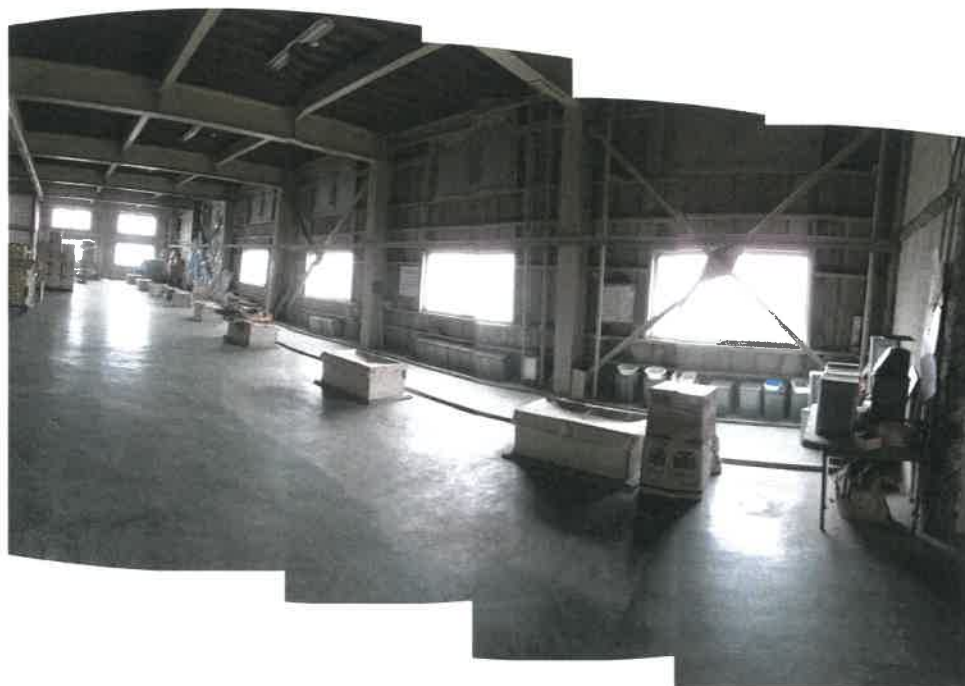
物件 1 4 建物の 2 階西側ゾーン工場内の状況
