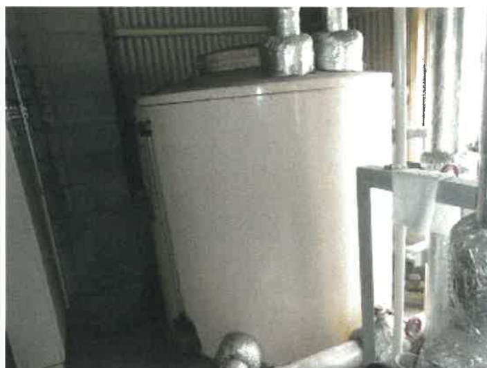
物件14建物の1階東側ゾーンの工場内の機械室内の状況
