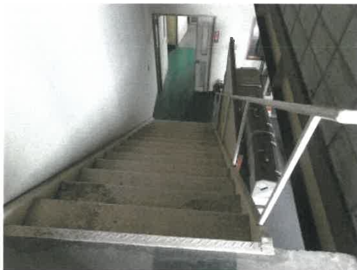
物件 1 4 建物の東側ゾーン西端の 3 階から 2 階への階段の状況
