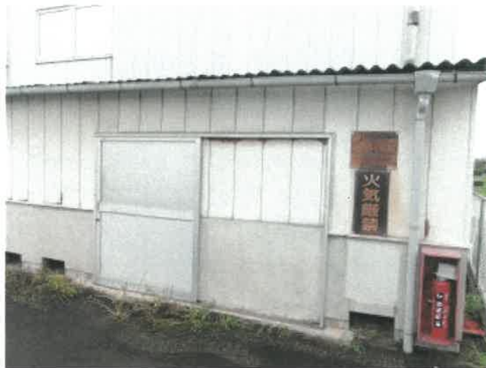
物件 1 4 建物の南西側の P L ガス容器置場
