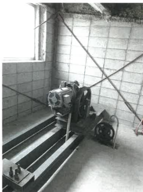
物件 1 4 建物の西側ゾーン北側屋上リフト機械室（鳩小屋状態で建物の一部ではない）の状況
