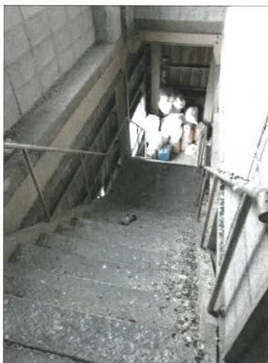
物件 1 4 建物の 3 階西側ゾーン北側 3 階から 2 階への階段の状況
