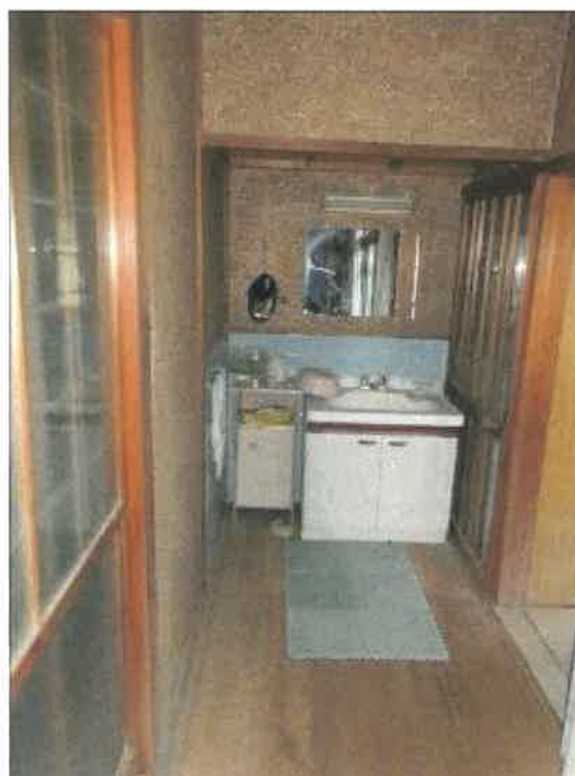
物件 1 5 建物の 1 階北ゾーンと南ゾーンの間の廊下西端の手洗の状況
