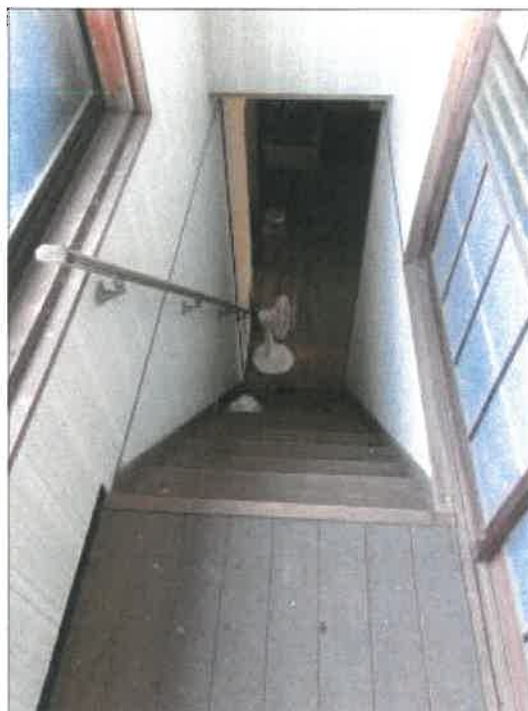
物件 1 5 建物の階段の状況
