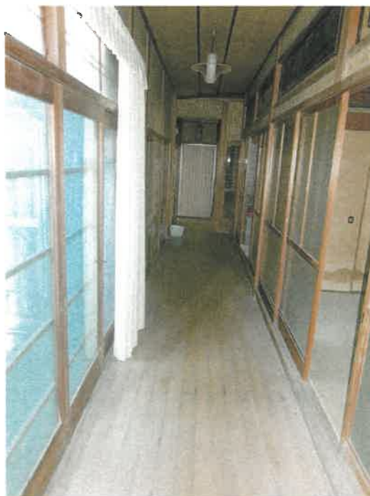
物件15建物の1階北ゾーンと南ゾーンの間の廊下の状況
