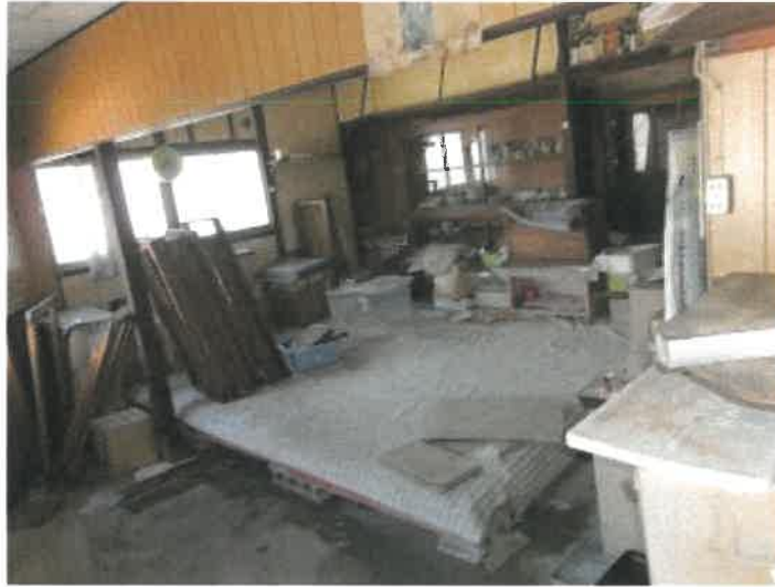
物件 1 5 建物の 1 階東側倉庫の状況
