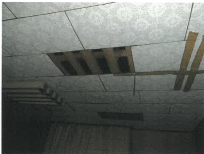
物件 1 5 建物の 1 階北側ゾーン西端の物置の天井の雨漏りによる損傷の状況
