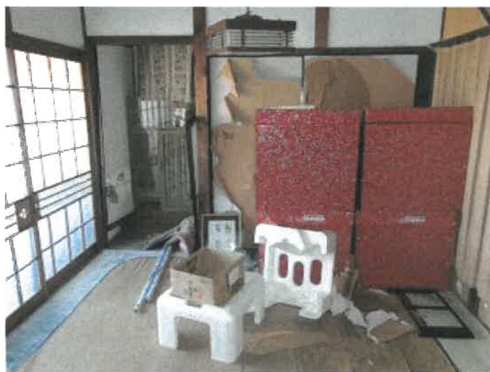
物件 1 5 建物の 2 階西側和室の状況
