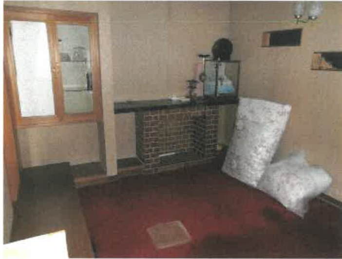
物件 1 5 建物の 1 階玄関東側洋室の状況
