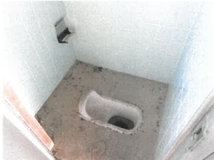
物件 1 6 建物南西角付近トイレの状況
