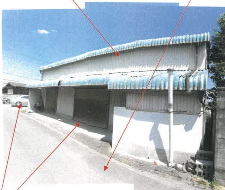
物件 1 3 土地南側及び西側境界付近の状況
