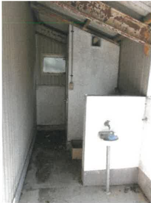
物件 1 6 建物南西角付近トイレ周辺の状況
