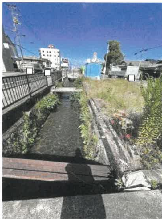
物件1 南側の状況
