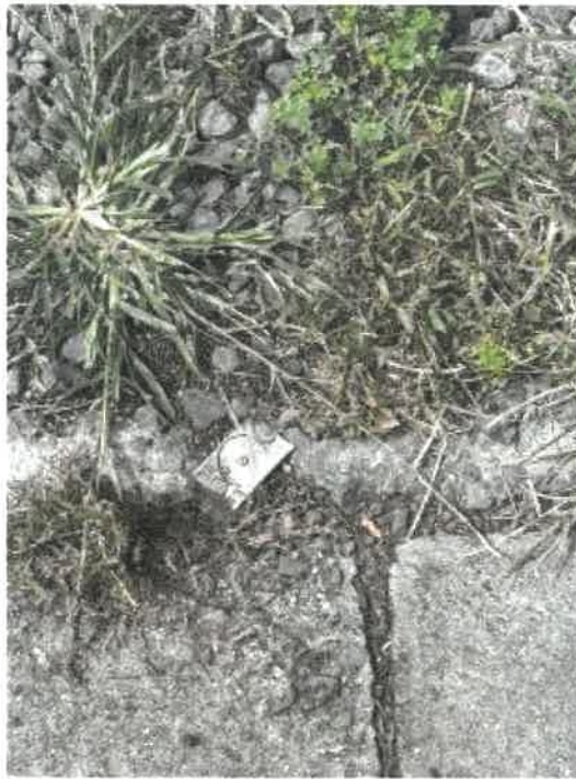
物件 1 北側付近の境界標の状況
