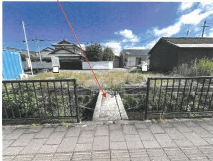
物件1 南西側の状況
