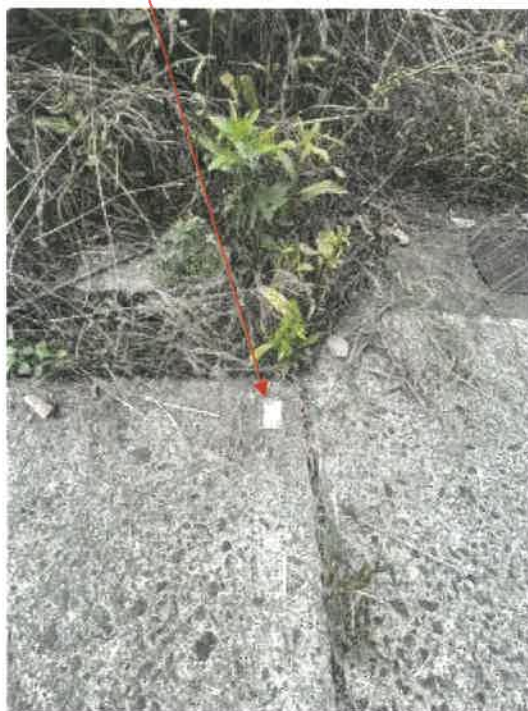
物件 2 南東側境界付近の状況
