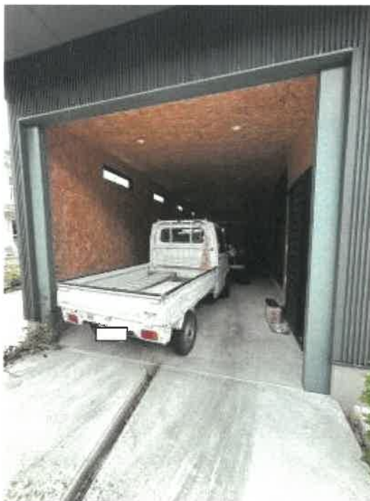
物件2 車庫の状況
