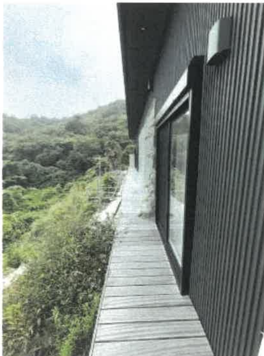
物件2 東側ウッドデッキの状況
