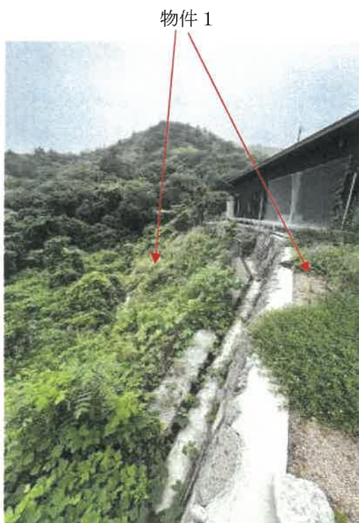
物件 1 北東側の状況
