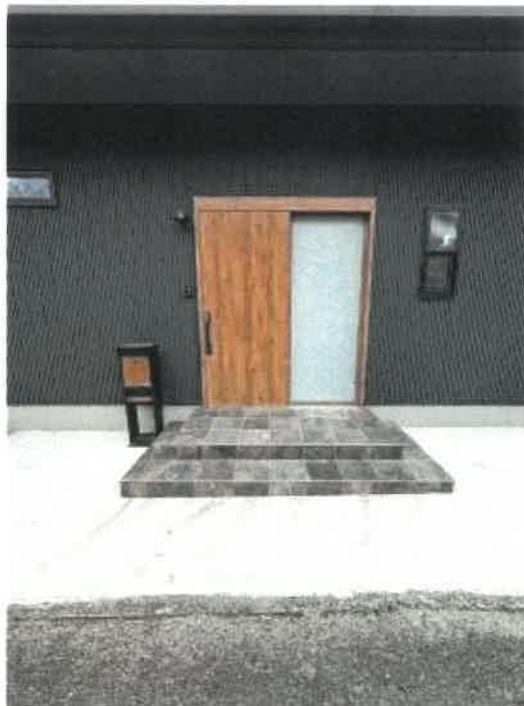
物件2 玄関付近の状況
