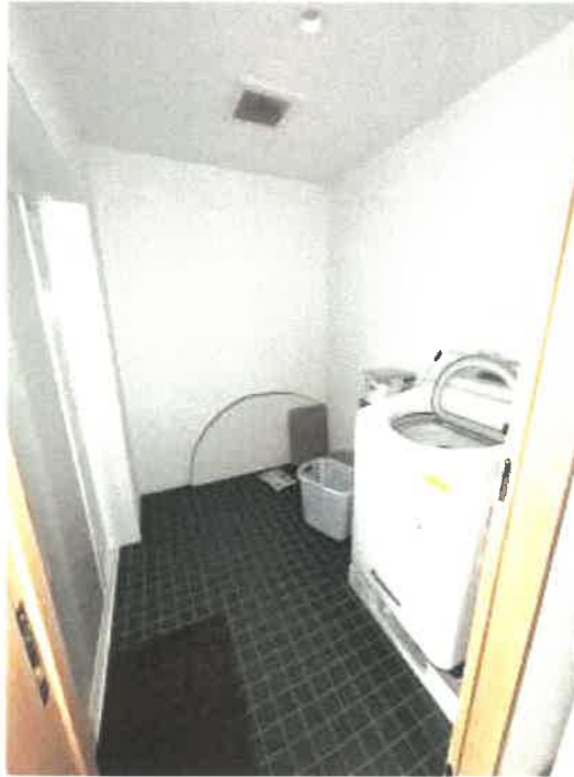
物件 2 脱衣所の状況
