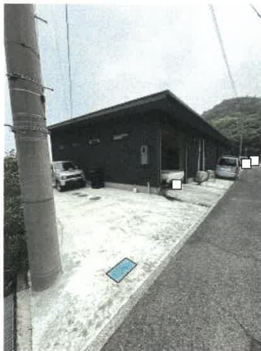
本件物件の北西側の状況
