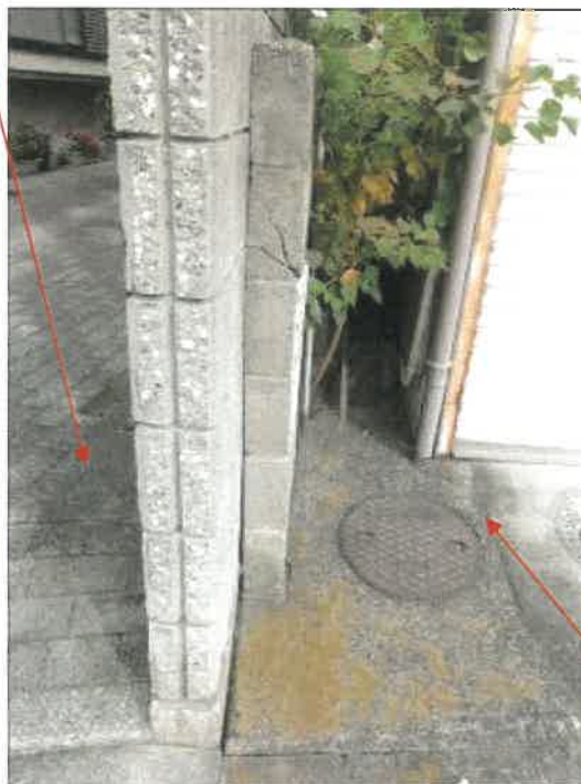
物件 1 土地北側境界付近の状況
