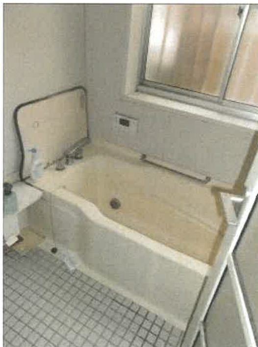
物件2建物の1階浴室の状況
