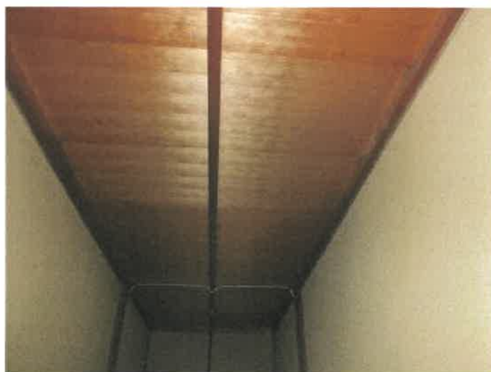
物件2建物の2階東側東西縁側の状況
