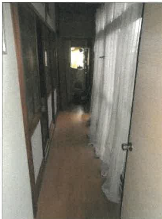
物件2建物の1階南側東西縁側の状況
