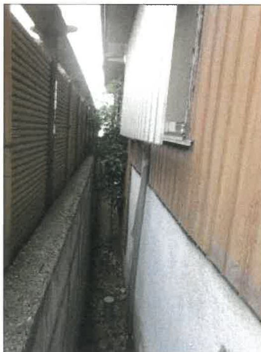
物件 2 建物北側の状況
