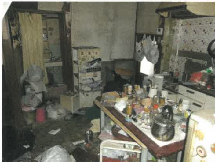
物件2建物の1階DKの状況
