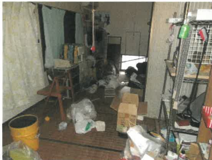
物件 2 建物の 2 階西側南洋室の状況
