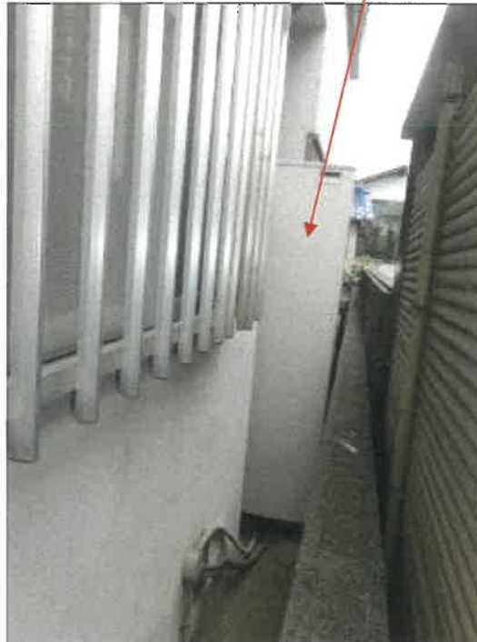
物件 2 建物北側の状況
