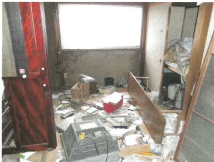
物件2建物の2階東端和室の状況
