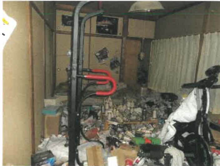
物件 2 建物の 2 階西側北和室の状況
