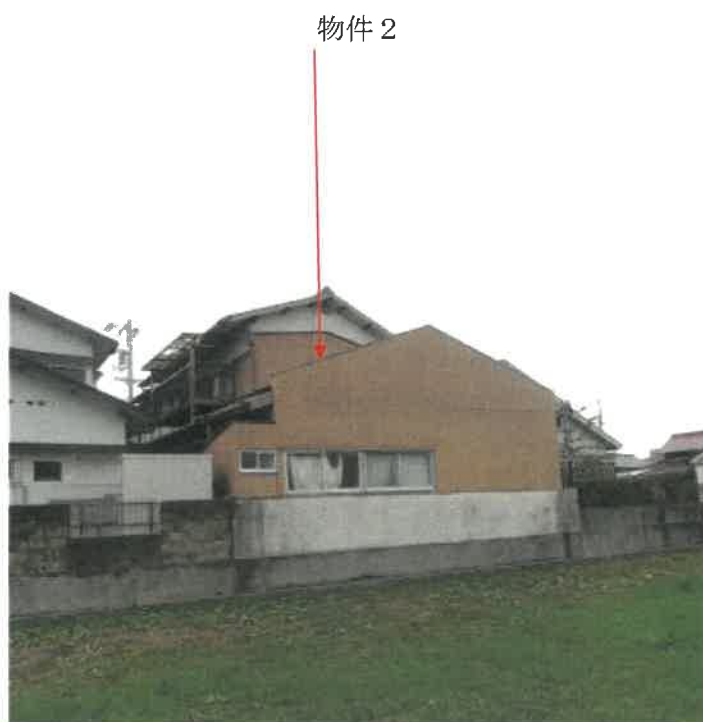
物件 2 建物東面の状況
