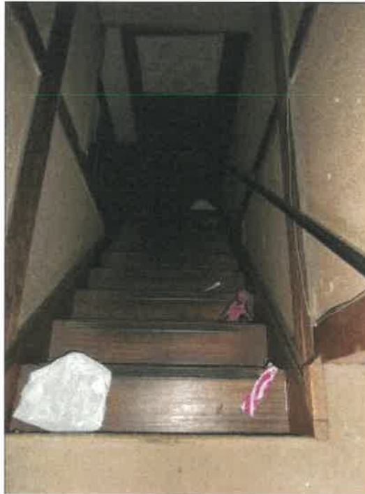
物件 2 建物の階段の状況
