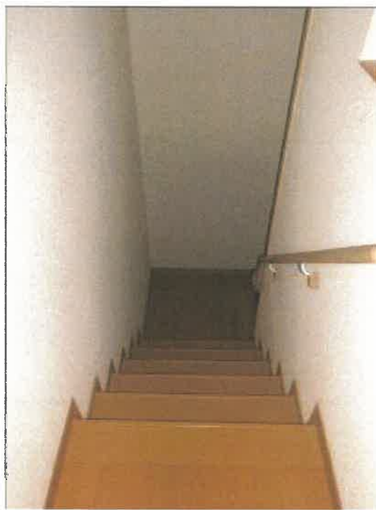
物件 2 建物の中 2 階から 1 階への階段の状況
