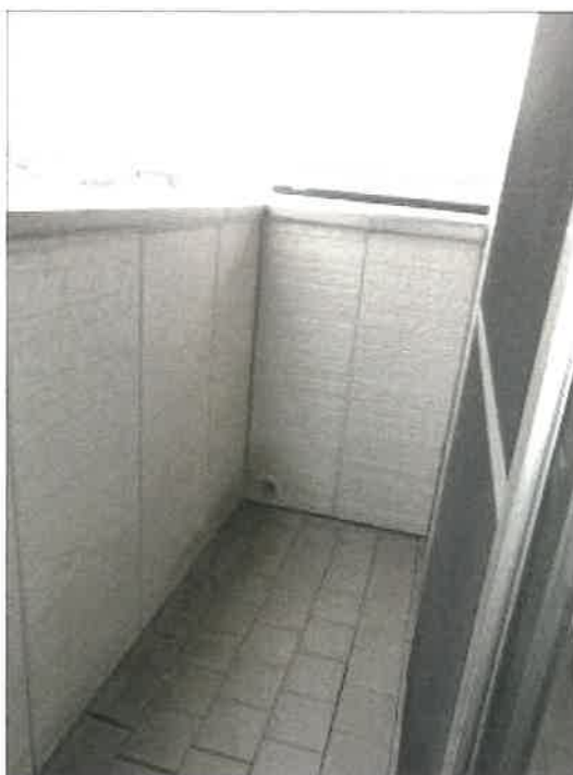
物件 2 建物の 2 階ルーフバルコニーの状況
