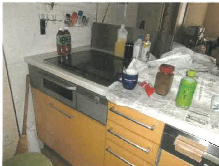
物件2建物の1階キッチンのIHクッキングヒーター設置の状況
