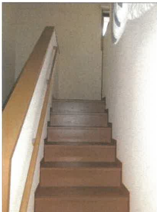
物件 2 建物の中 2 階から 2 階への階段の状況
