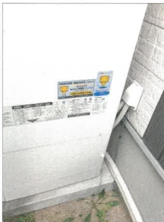
物件 2 建物の北側のエコキュートのリース標の状況
