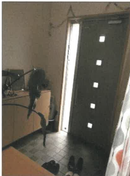
物件2建物の1階玄関周りの状況
