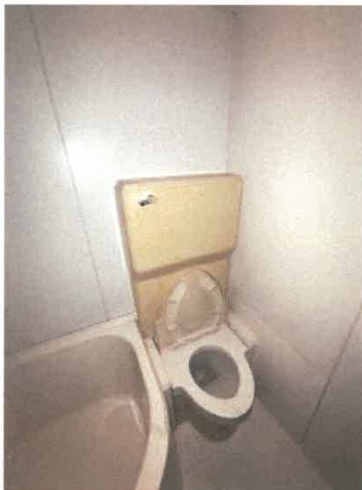
ユニットバスの状況
