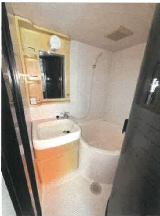
ユニットバスの状況
