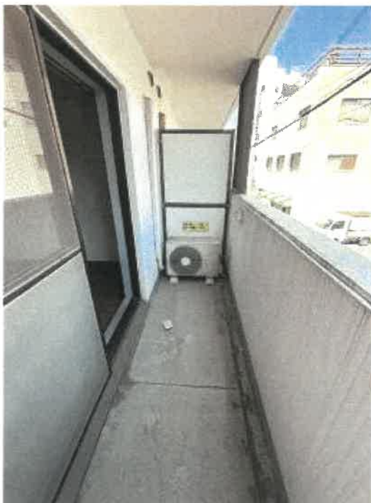
バルコニーの状況
