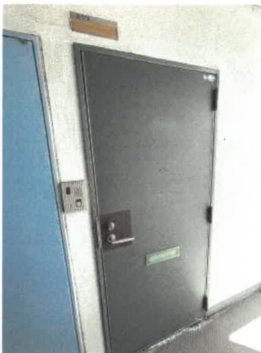
203号室入口ドアの状況
