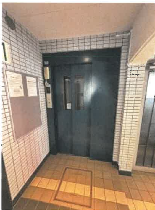
エレベータ前の状況
