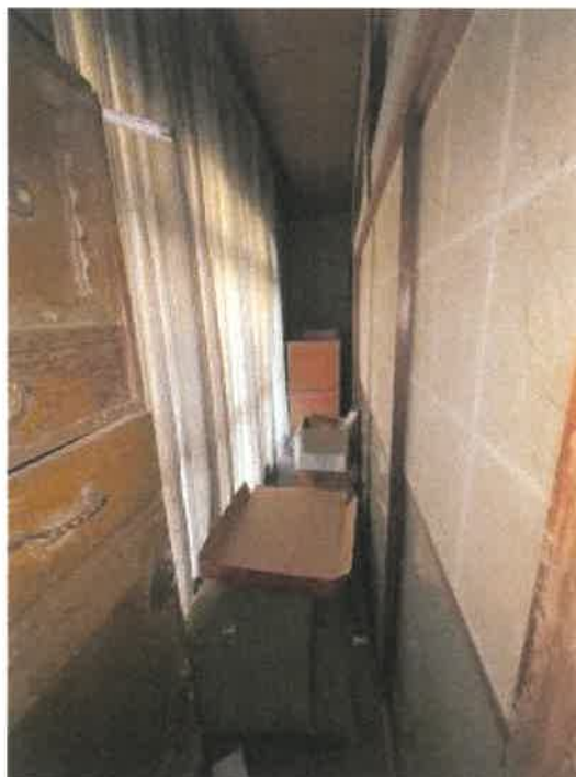
物件3 1階南西側縁側の状況
