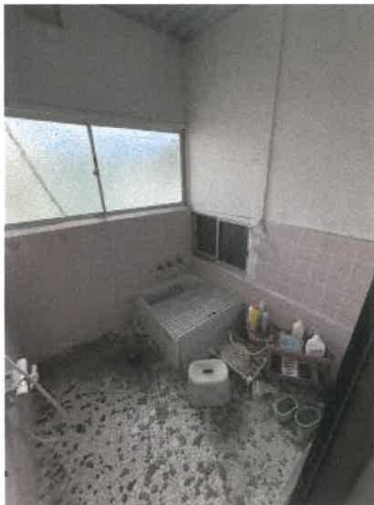
物件3 1階浴室の状況
