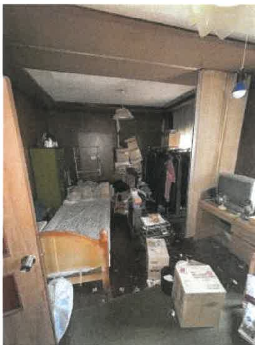
物件3 1階中央洋室の状況
