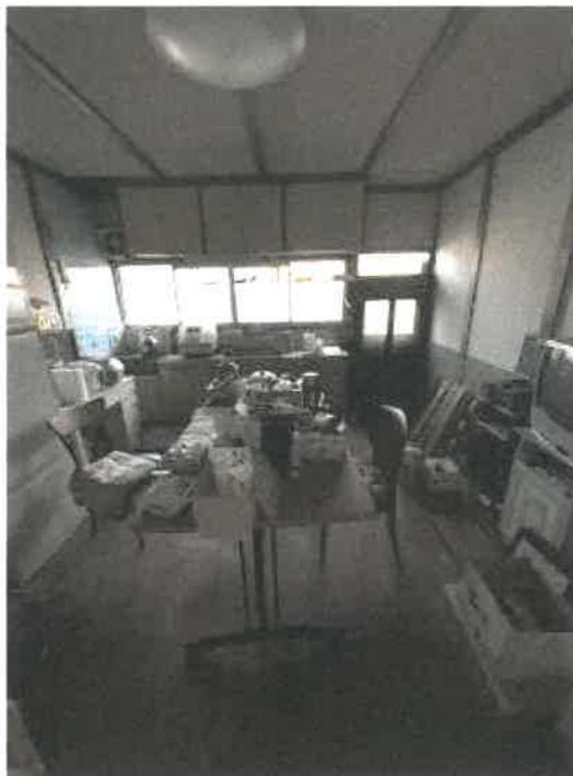
物件3 1階台所・食堂の状況
