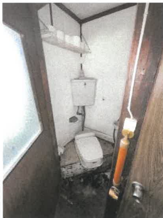
物件3 作業場西側のトイレの状況
