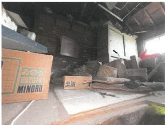
物件3 作業場の屋根裏の状況
