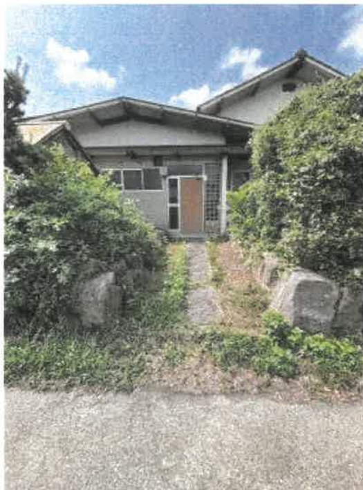
物件 2 北側入口付近の状況
