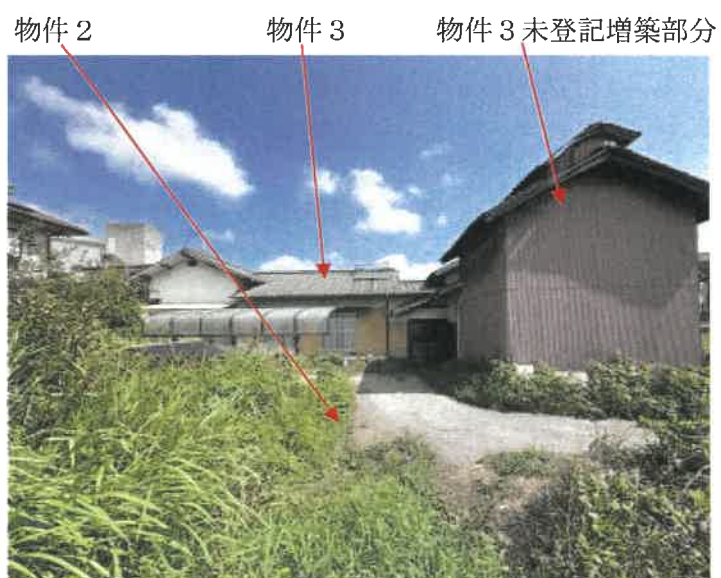
本件物件南側の状況
