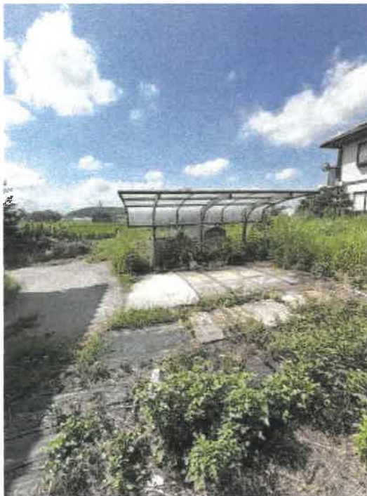
物件2 南西側カーポートの状況
