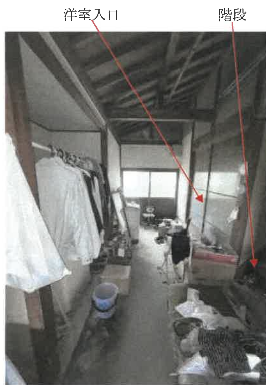
物件3 作業場北側の状況
