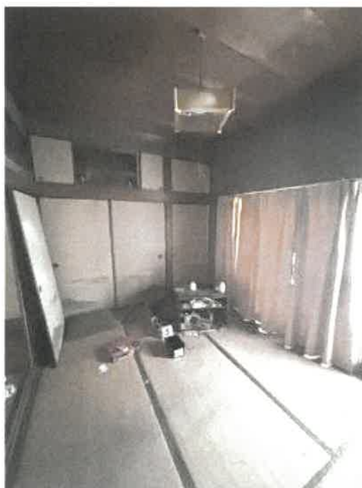
物件3 1階北西側和室の状況
