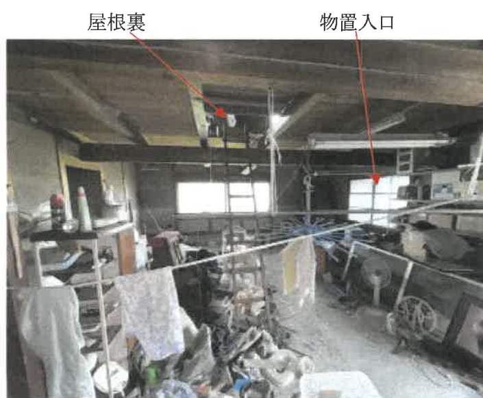
物件3 作業場の状況
