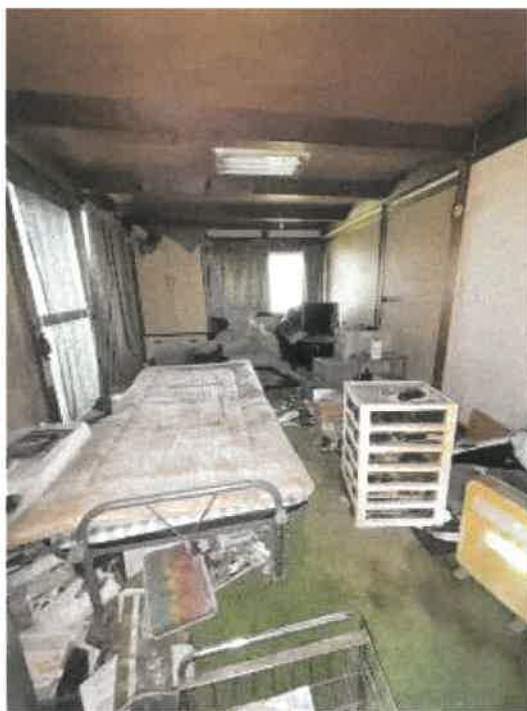
物件3 北東側1階洋室の状況
