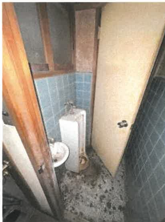
物件3 1階男性用トイレの状況
