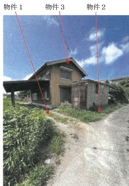
本件物件北東側の状況
