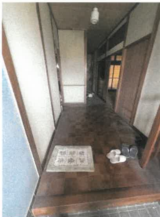
物件3 玄関内の状況
