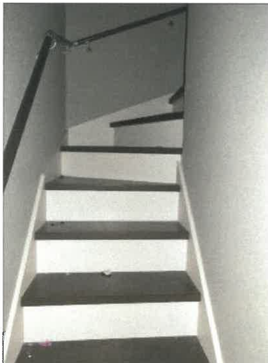
物件2建物の2階から3階への階段の状況
