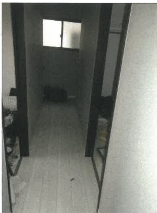
物件2建物の2階ホールの状況
