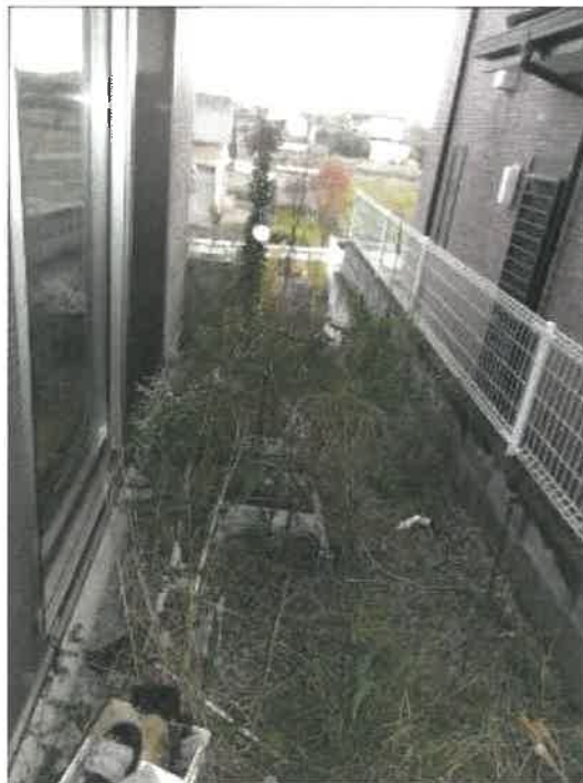
物件2建物の南側の状況
