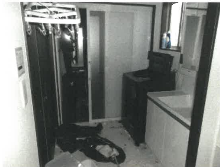
物件 2 建物の 1 階洗面脱衣所の状況
