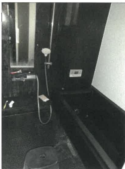
物件 2 建物の 1 階浴室の状況
