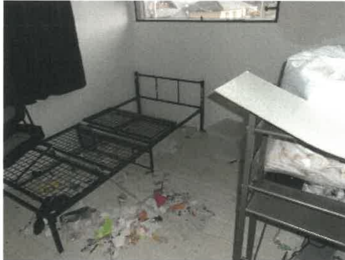
物件 2 建物の 2 階北東角洋室の状況
