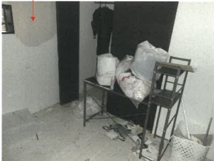
物件 2 建物の 2 階北東角洋室の状況
