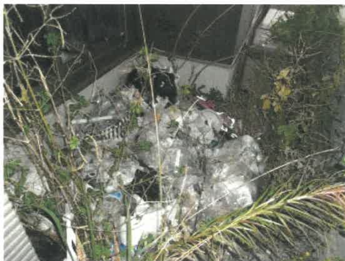
物件2建物の東側の状況
