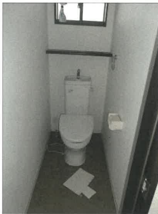
物件 2 建物の 2 階トイレの状況
