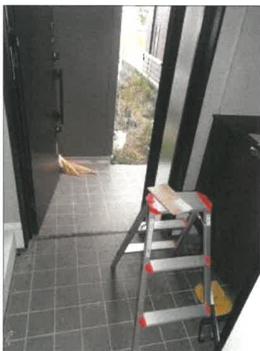
物件 2 建物の 1 階玄関周りの状況
