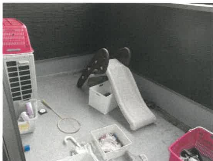
物件 2 建物の 2 階バルコニーの状況
