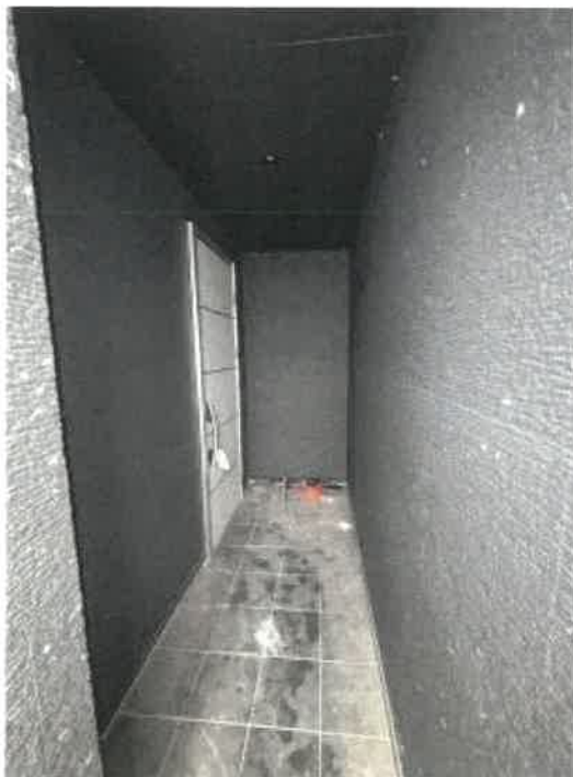
物件4 玄関付近の状況
