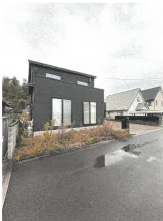
物件 3、5 北西側の状況
