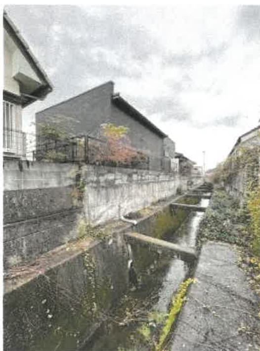
物件 4 南東側の状況
