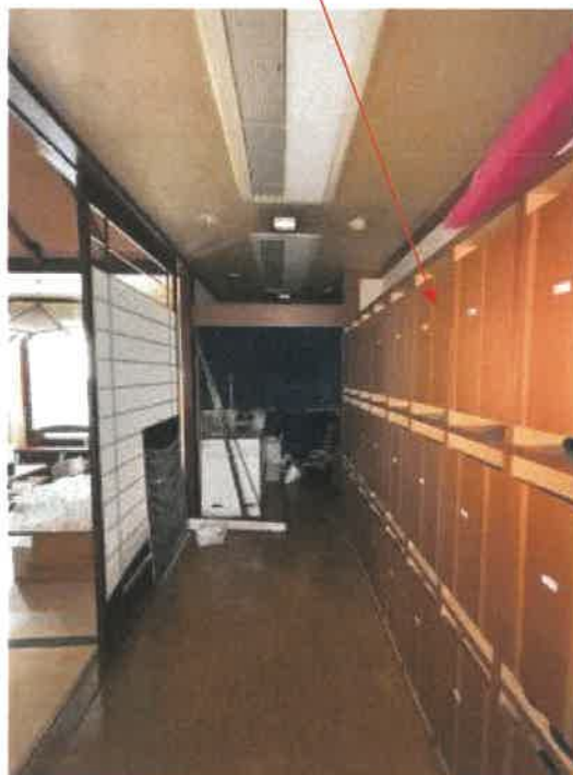
物件3 廊下の状況
