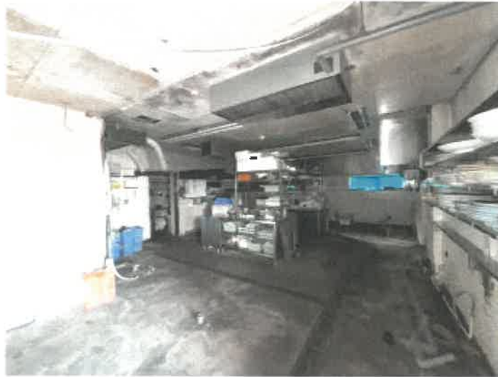
物件3 厨房の状況
