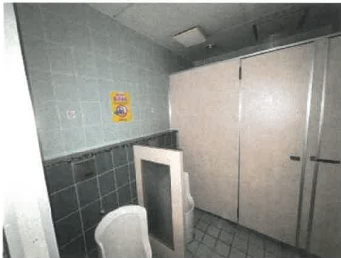
物件3 男子トイレの状況
