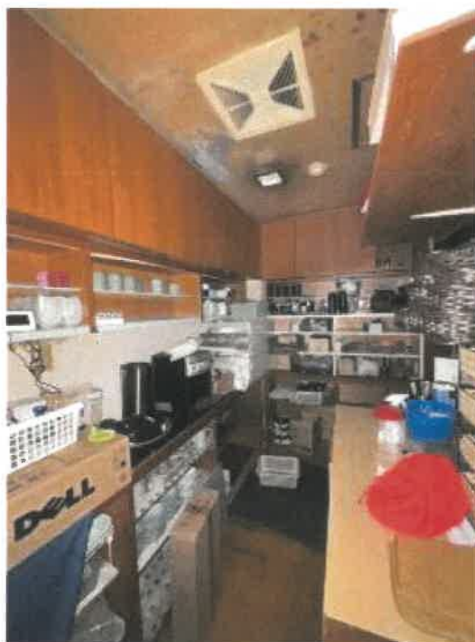
物件3 西側倉庫内の状況
