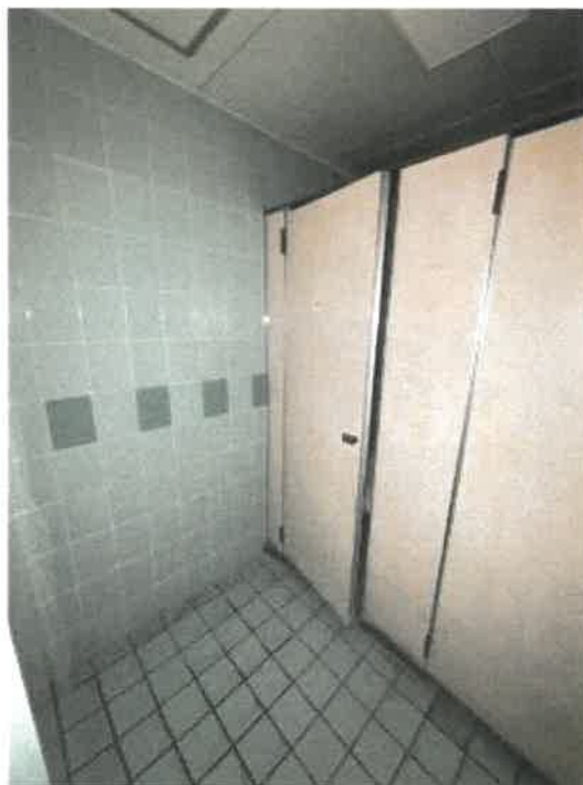
物件3 女子トイレの状況
