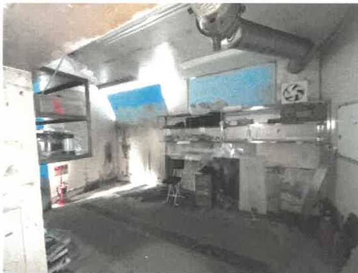
物件3 北側倉庫（未登記増築部分）の状況
