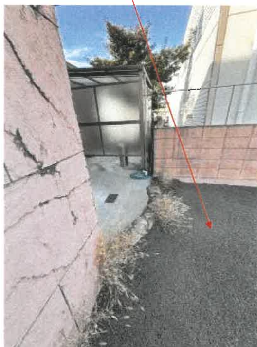
物件1 北東側、物件2 南東側の状況
