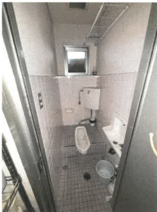
物件3 休憩室横トイレの状況
