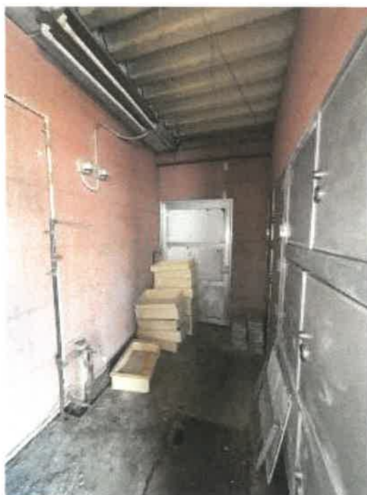
物件3 西側物置（未登記増築部分）の状況
