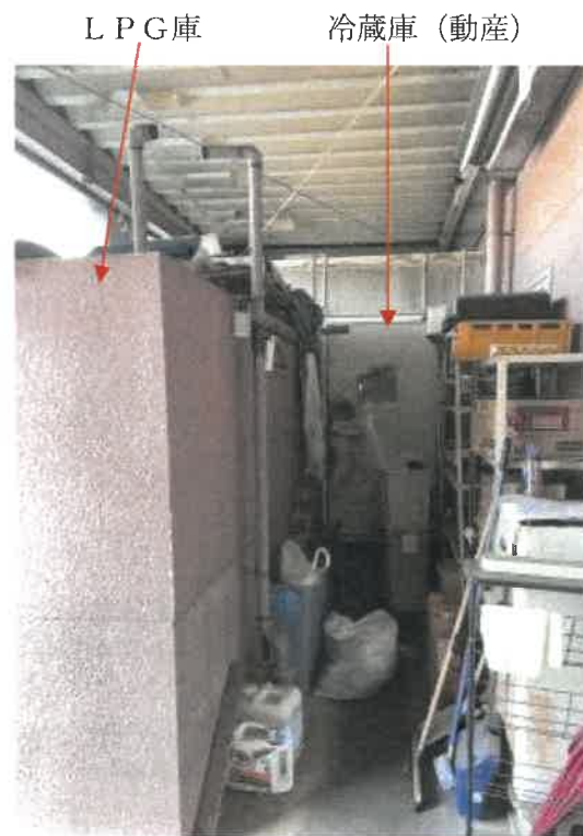
物件3 東側物置（未登記増築部分）の状況
