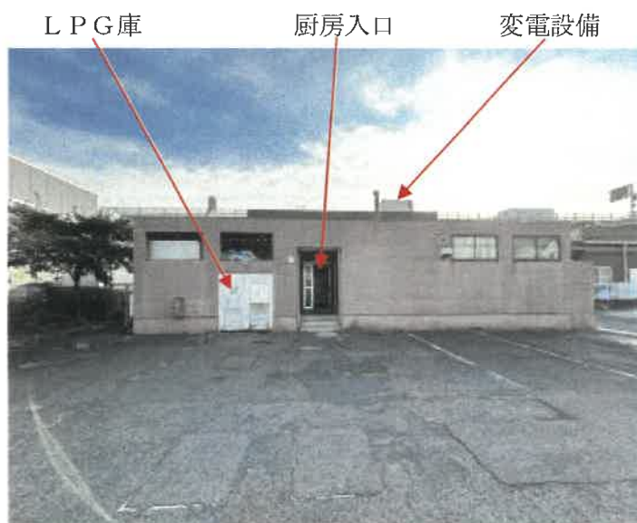
本件物件北側の状況
