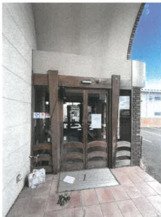
物件3 風除室南側入口の状況
