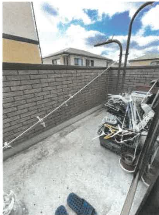
物件2 2階バルコニーの状況
