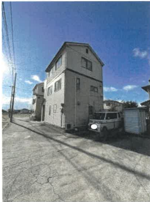
本件物件北側の状況
