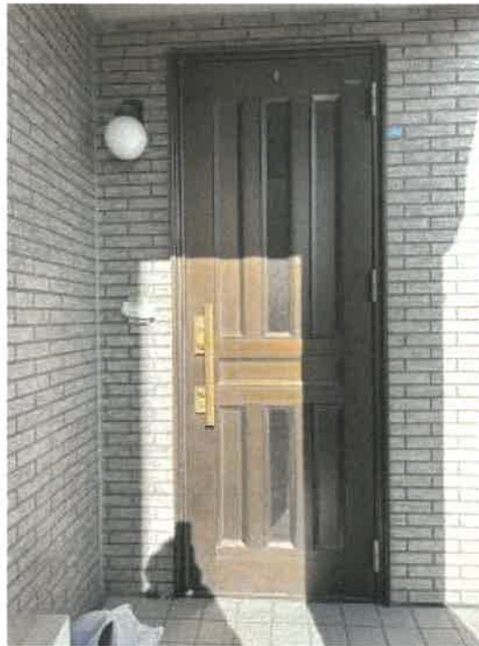
物件2 玄関ドアの状況
