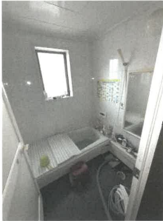
物件2 1階浴室の状況
