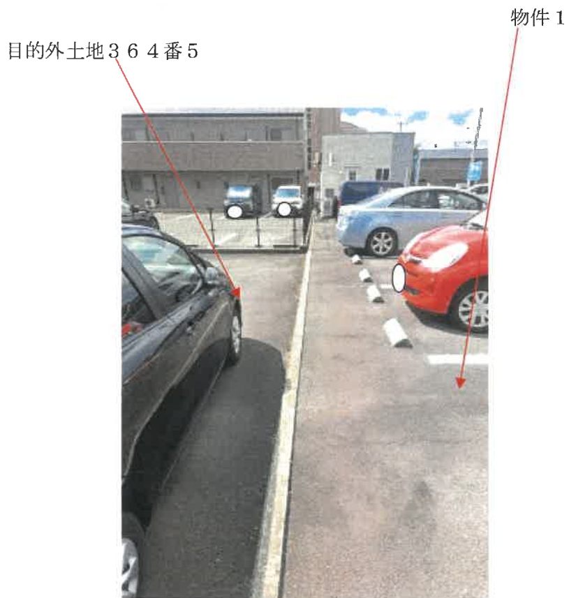
物件1 土地ほぼ東側境界付近の状況
