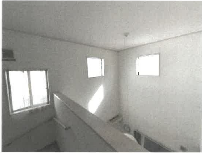
物件2 吹抜けの状況
