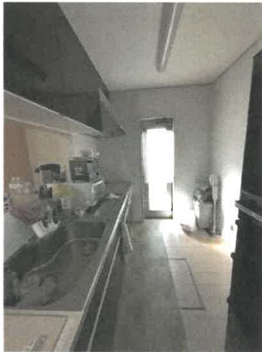
物件2 1階台所の状況
