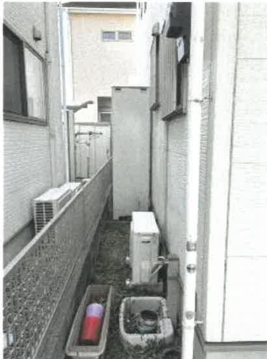
物件1 東側の状況
