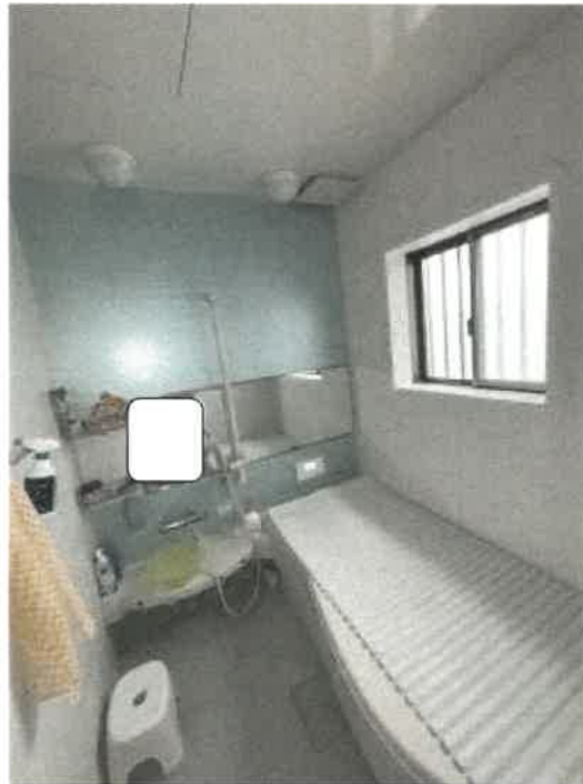
物件2 1階浴室の状況
