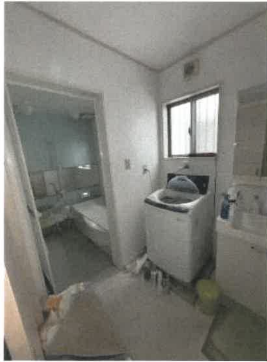
物件2 1階洗面脱衣所の状況
