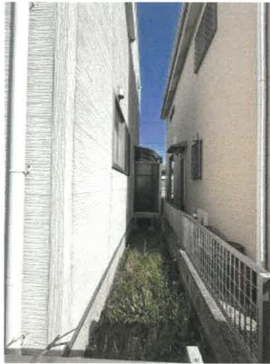
物件1 南側の状況
