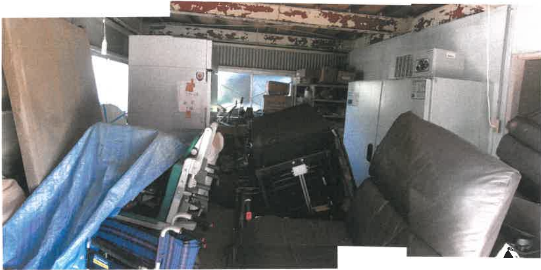
物件16建物の北側部分の状況
