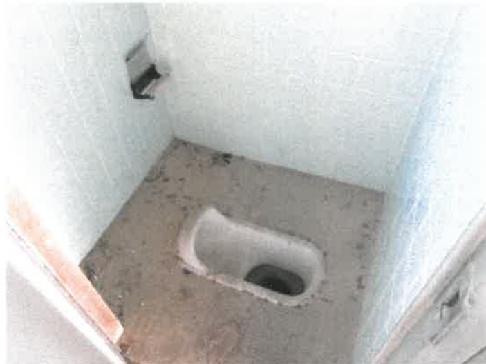
物件16建物南西角付近トイレの状況
