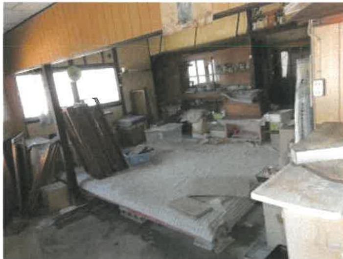
物件 1 5 建物の 1 階東側倉庫の状況
