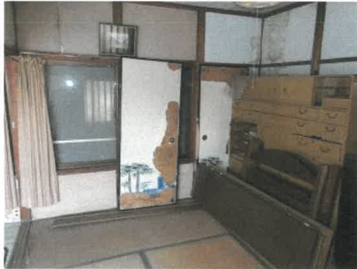
物件15建物の2階東側和室の状況
