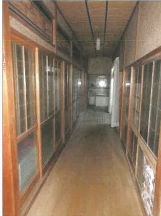
物件15建物の1階北ゾーンと南ゾーンの中の廊下の状況
