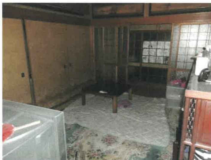
物件15建物の1階玄関東前の和室の状況
