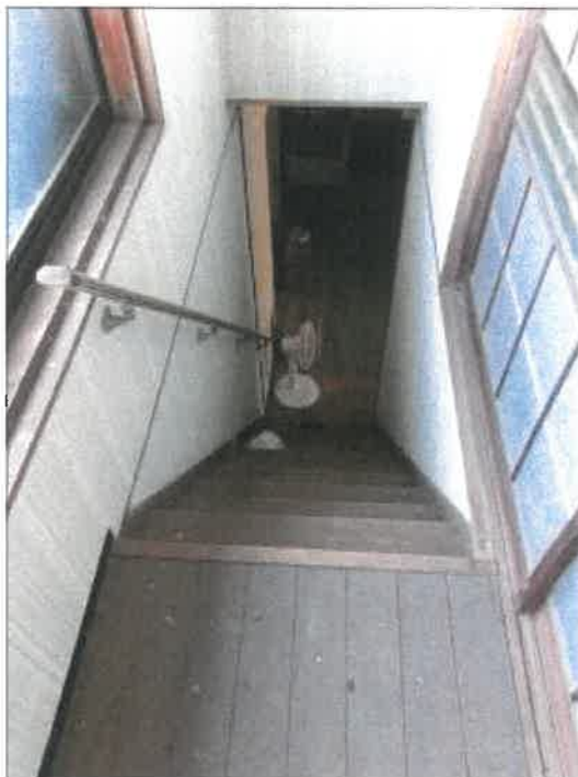
物件15建物の階段の状況
