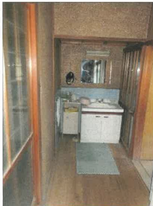
物件15建物の1階北ゾーンと南ゾーンの中の廊下西端の手洗の状況
