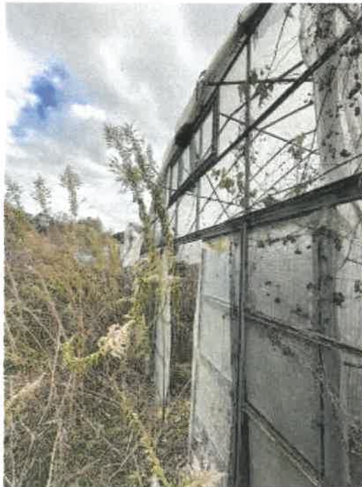
物件 5 ハウス北西側の状況
