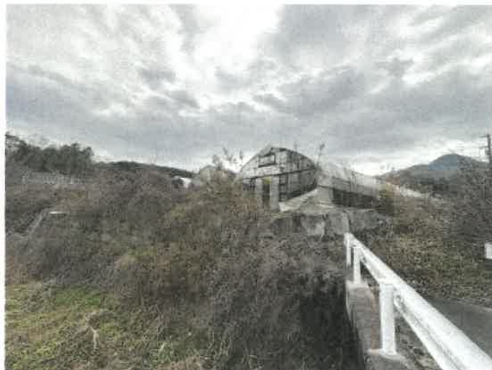
物件 5 北西側の状況
