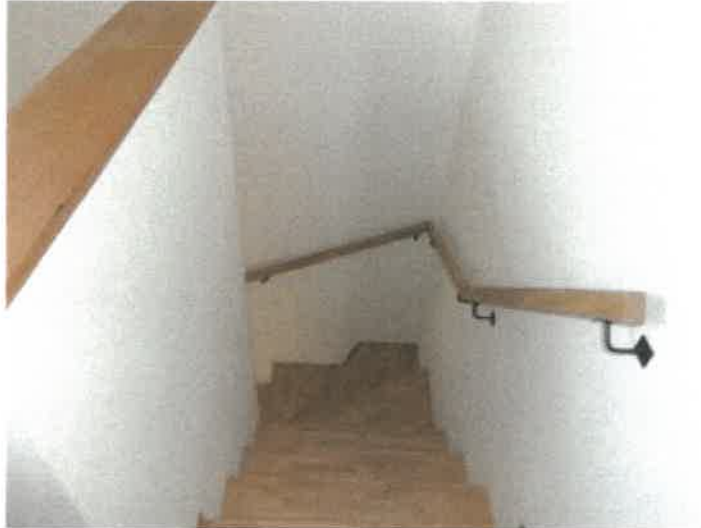
物件2建物の階段の状況
