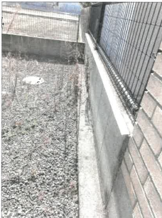
物件 1 土地南西側隣地の北東側ブロック塀の水切金の設置状況
