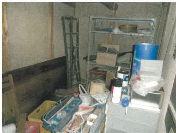
物件5附属建物符号5の中の物置部分の状況
