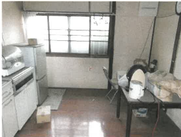
物件5主である建物のDKの状況
