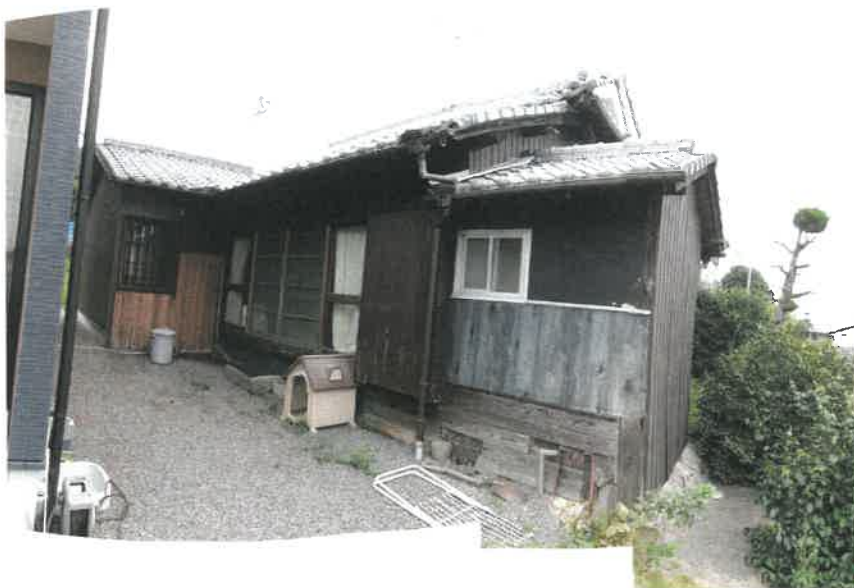
物件5主である建物北西側の状況
