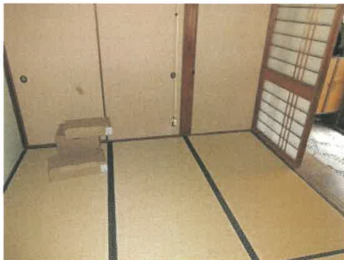
物件5主である建物の玄関前和室2間の状況
