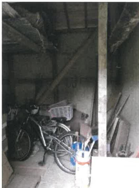
物件5附属建物符号5の東側物置部分の状況
