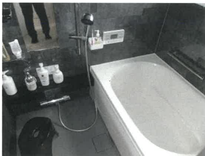
物件6建物東側エリアの浴室の状況
