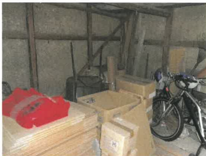
物件5附属建物符号5の東側物置部分の状況
