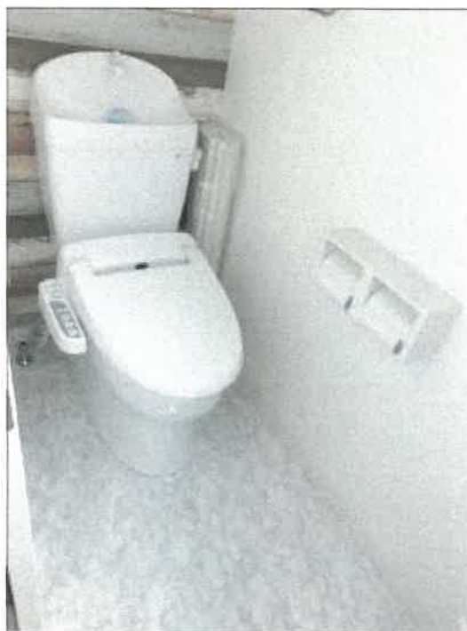
物件6建物東側エリアのトイレの状況
