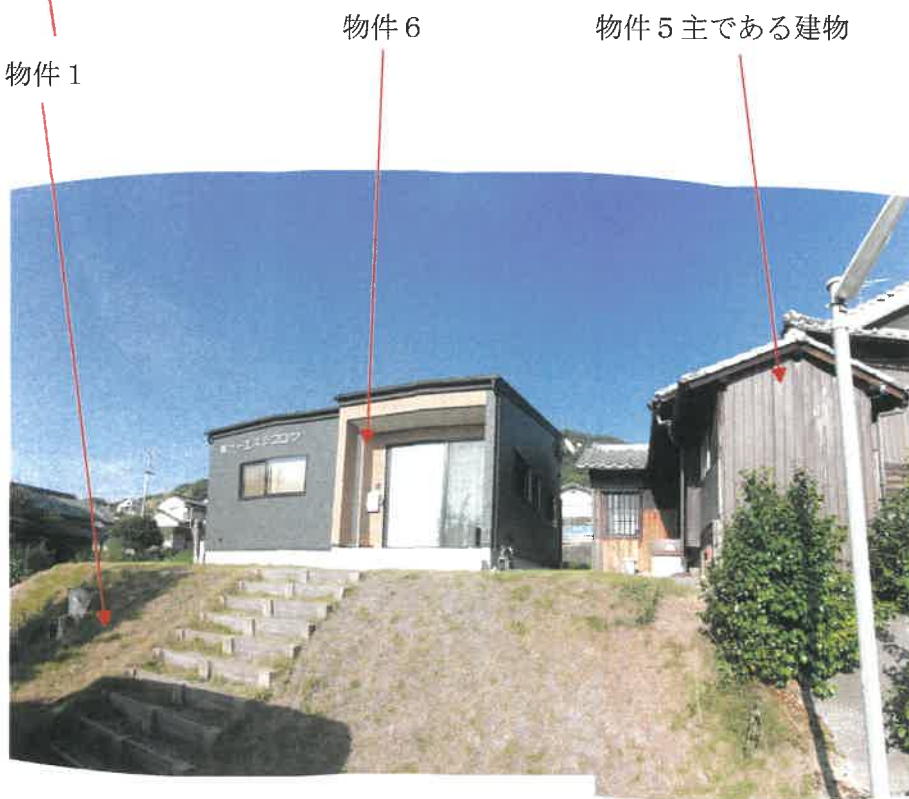
物件5主である建物及び物件6西側の状況
