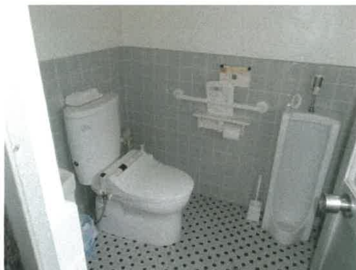
物件5主である建物のトイレの状況
