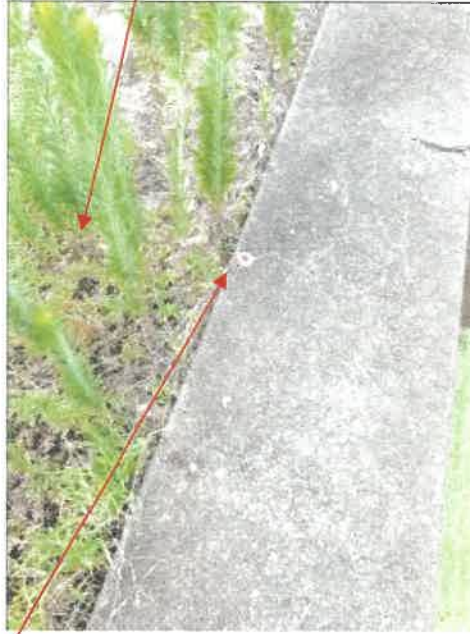
物件 4 土地東側境界付近の状況
