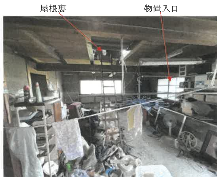
物件3 作業場の状況
