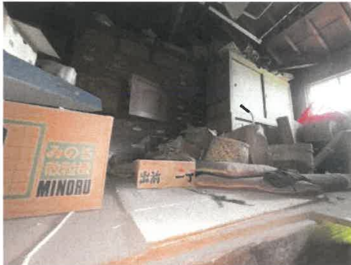
物件3 作業場の屋根裏の状況
