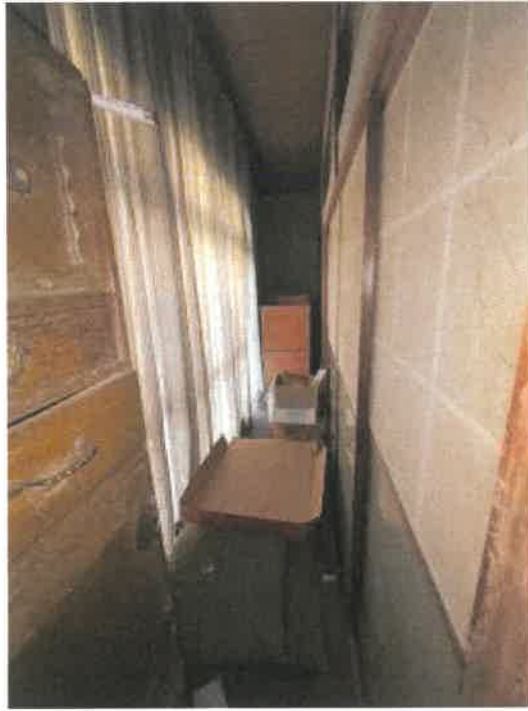
物件3 1階南西側縁側の状況
