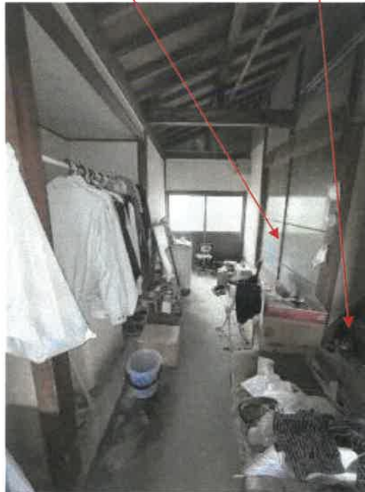
物件3 作業場北側の状況
