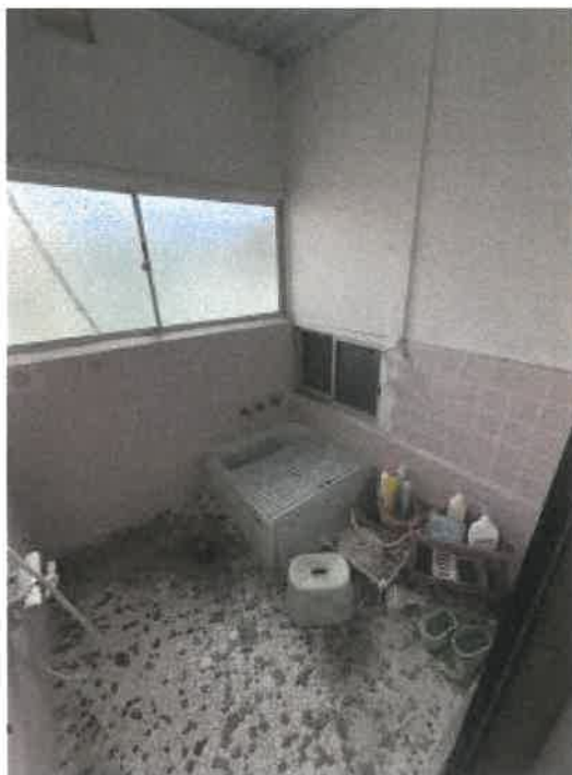
物件3 1階浴室の状況
