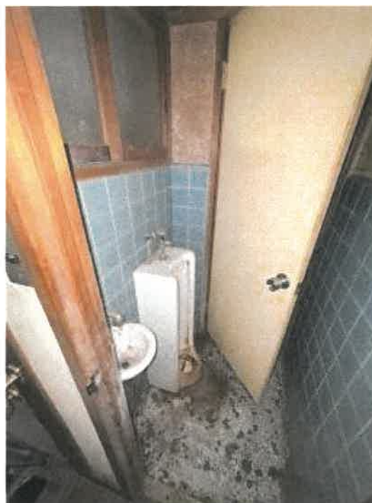
物件3 1階男性用トイレの状況
