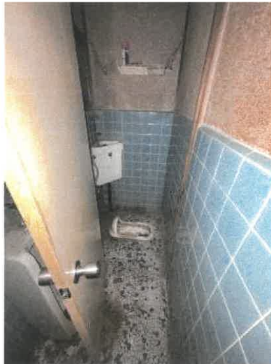
物件3 1階トイレの状況
