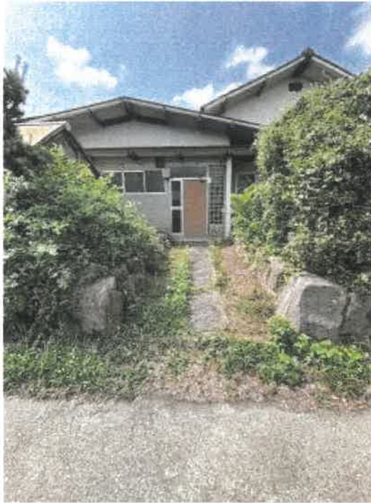
物件2 北側入口付近の状況
