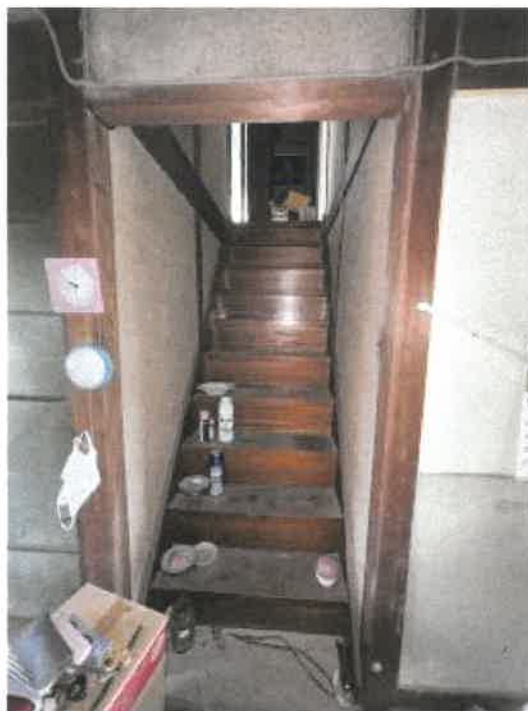
物件3 階段の状況
