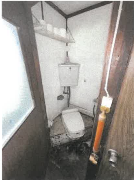
物件3 作業場西側のトイレの状況
