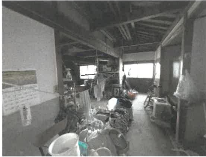
物件3 作業場南西側の状況
