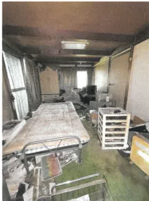
物件3 北東側1階洋室の状況
