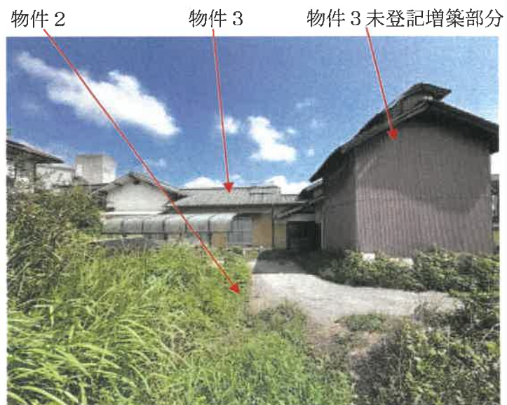
本件物件南側の状況
