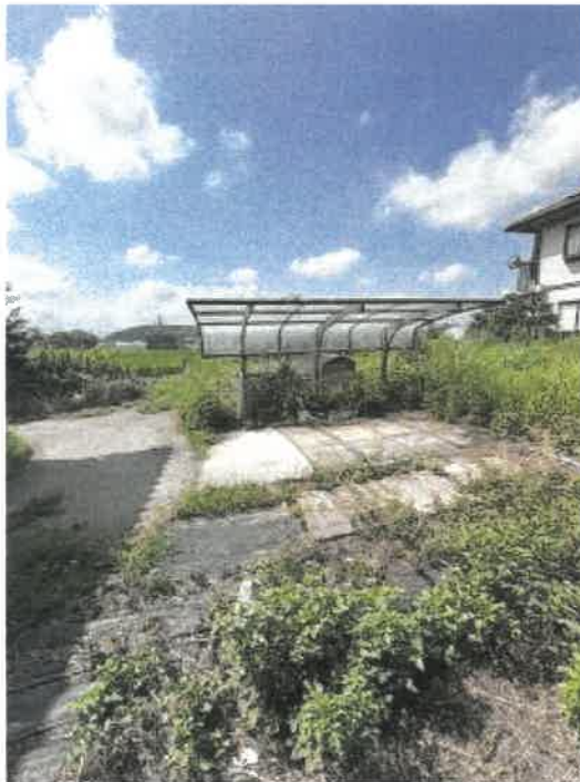
物件2 南西側カーポートの状況
