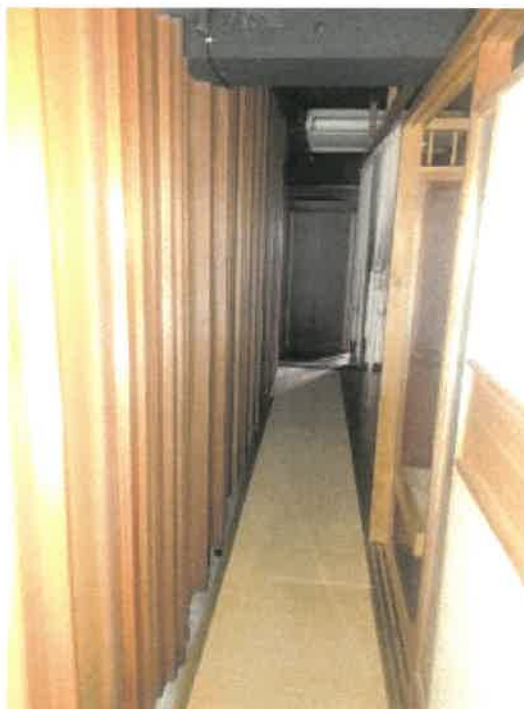
物件4 建物の1階店舗部分の南側通路の状況
