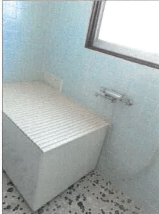
物件4建物の5階501号室の浴室の状況
