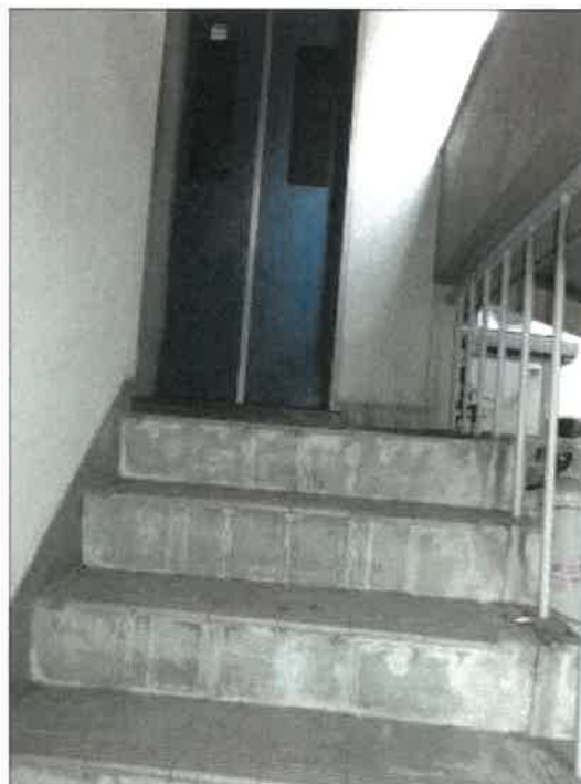
物件4建物の1階エレベーター昇降口付近の状況
