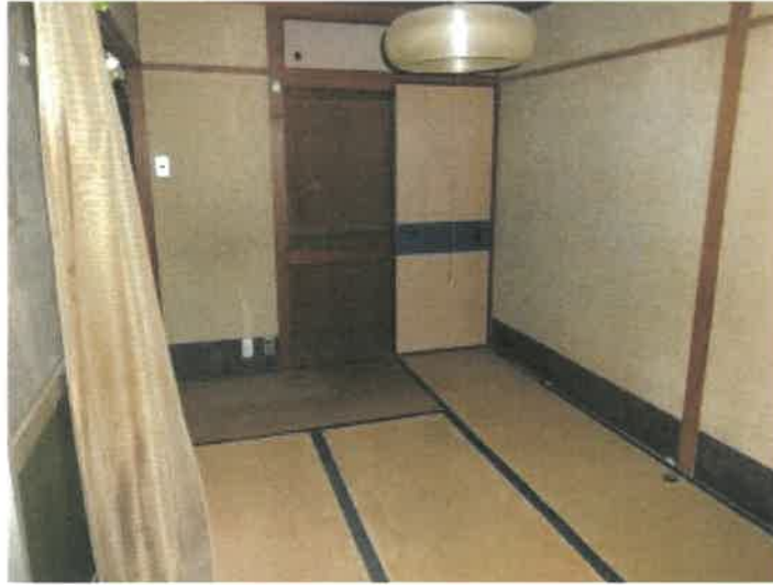
物件4建物の2階202号室のDKの状況
