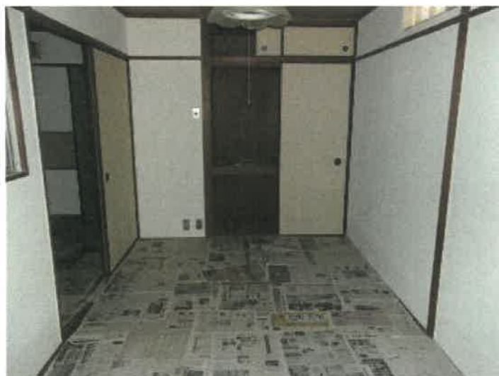
物件4建物の3階302号室の西側和室の状況
