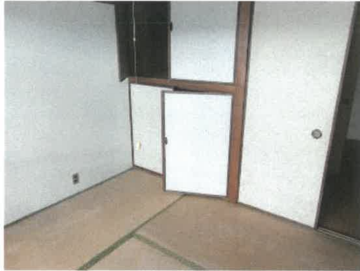
物件4建物の3階301号室の東側和室の状況
