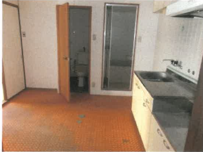
物件 4 建物の 3 階 3 0 1 号室の DK の状況
