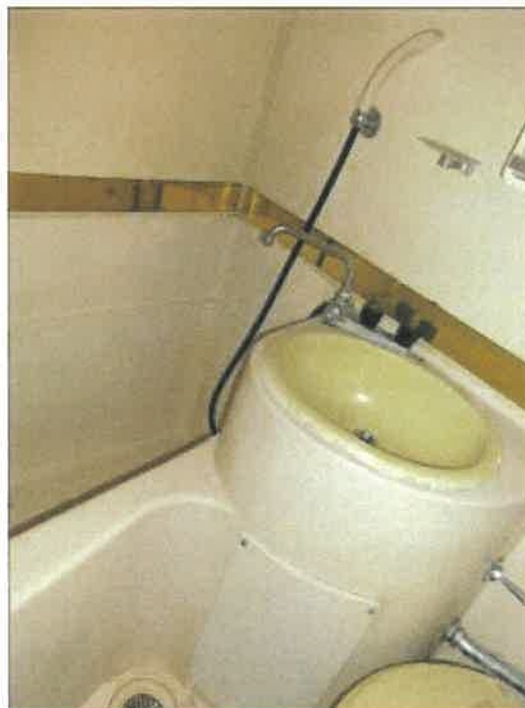
物件4建物の3階302号室のユニットバスの状況
