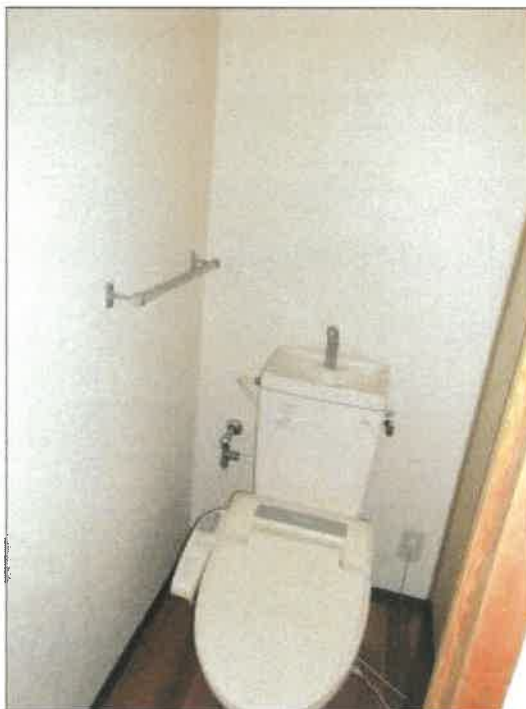
物件4建物の3階301号室のトイレの状況
