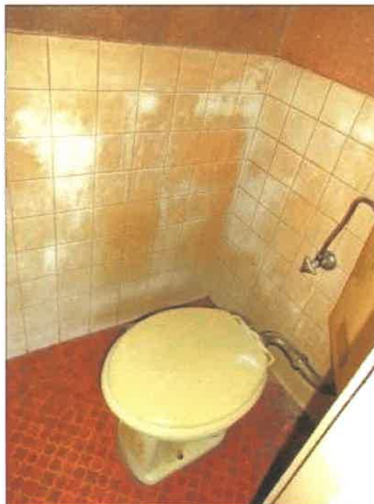
物件4建物の5階502号室のトイレの状況
