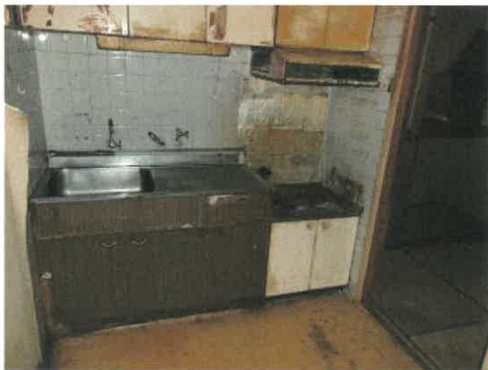
物件4建物の5階502号室のキッチン周りの状況
