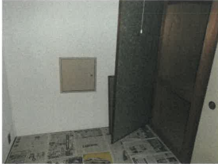
物件4建物の3階302号室の東側和室の状況
