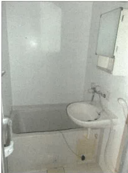
物件4建物の3階301号室の浴室の状況
