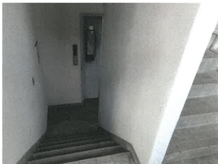
物件4建物の4階の階段付近の状況
