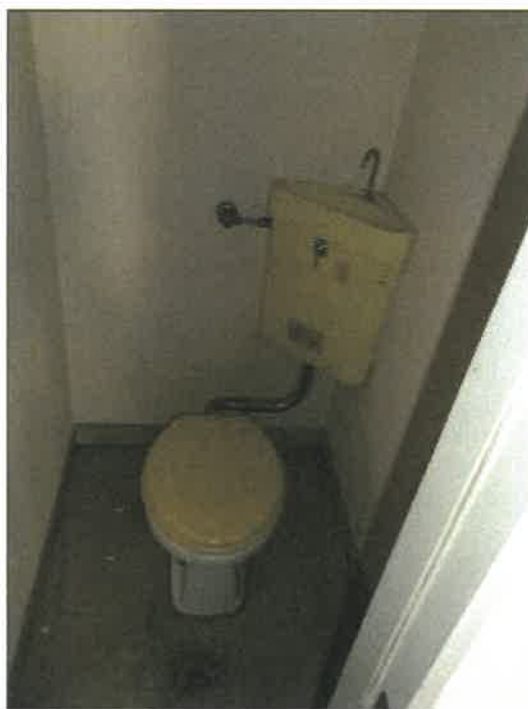
物件4建物の4階401号室のトイレの状況
