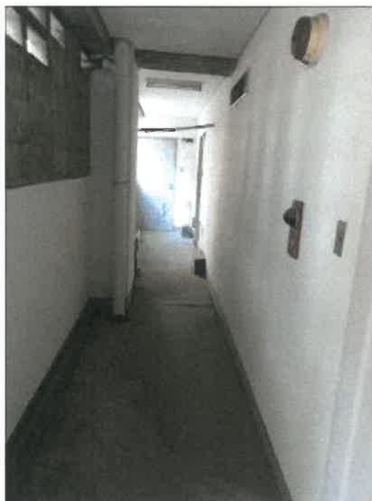
物件4建物の3階廊下の状況
