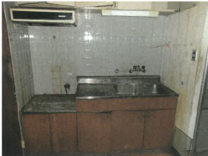
物件4建物の2階202号室のDKの状況
