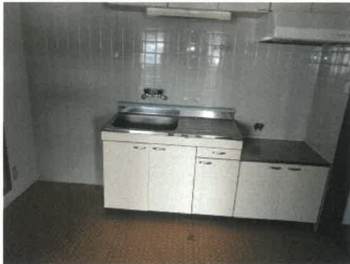
物件 4 建物の 3 階 3 0 1 号室の DK の状況
