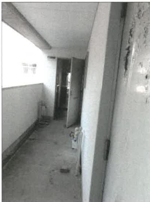
物件 4 建物の 4 階廊下の状況
