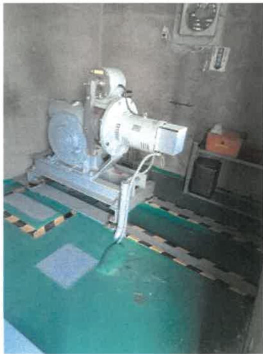
物件4建物の屋上エレベーター機械室内の状況
