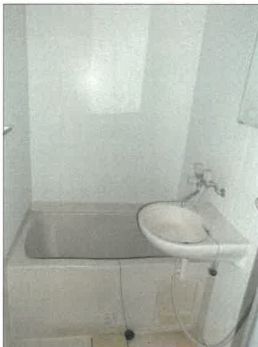
物件4建物の2階201号室の浴室の状況
