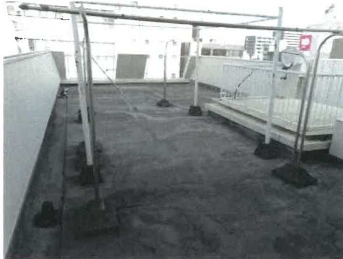
物件4建物の屋上の状況
