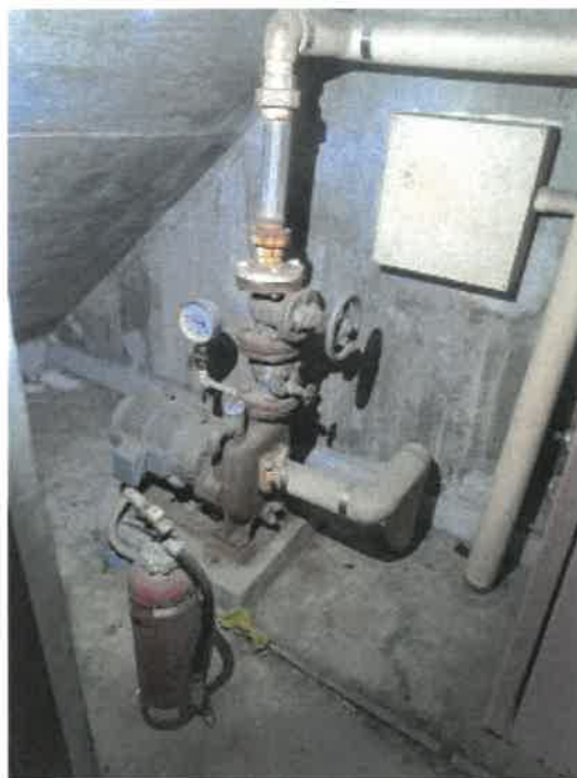
物件4建物の1階南側端の地下貯水槽からのポンプアップ用の機械装置の状況
