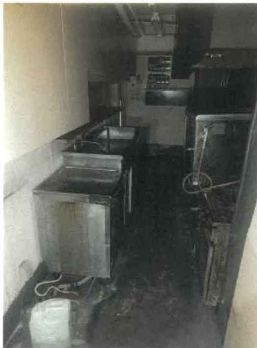
物件 4 建物の 1 階店舗部分の厨房の状況
