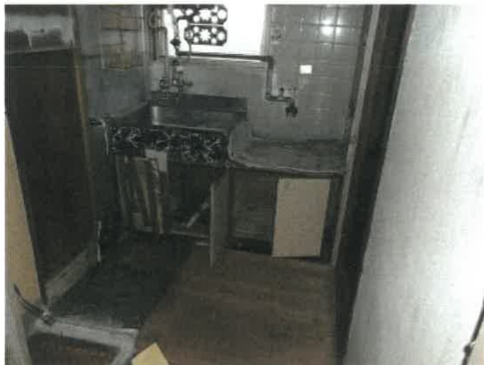
物件4建物の4階402号室のキッチン周りの状況
