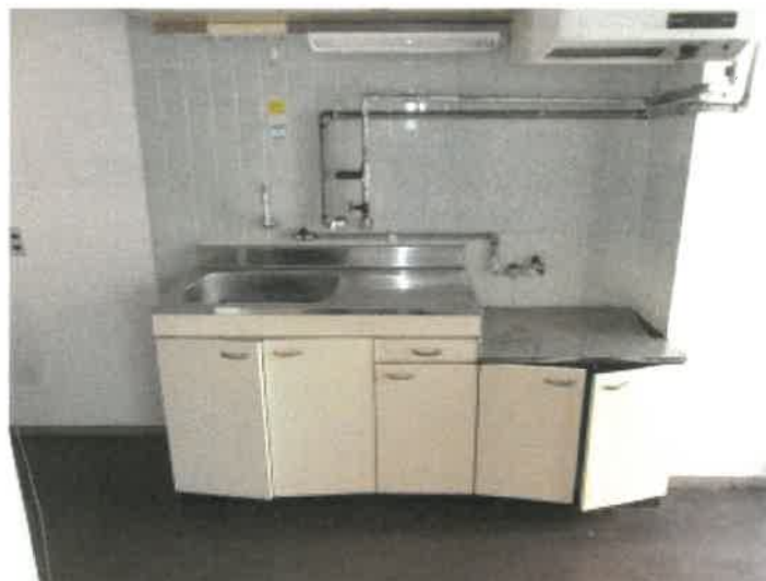
物件4建物の4階401号室のDKの状況
