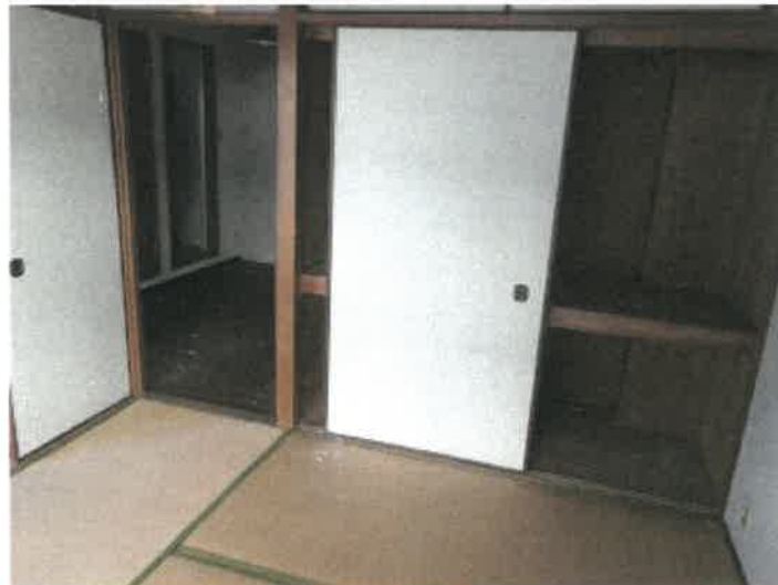
物件4建物の3階201号室の西側和室の状況
