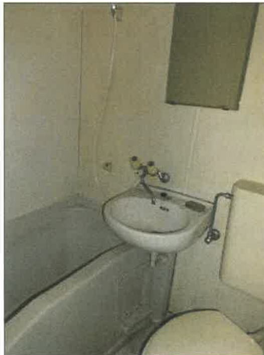
物件4建物の2階202号室のユニットバスの状況
