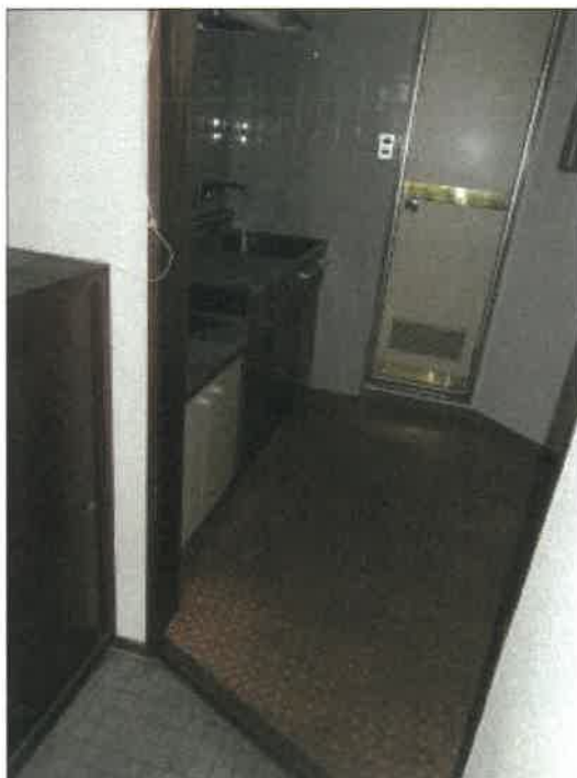
物件4建物の3階302号室の玄関周りの状況
