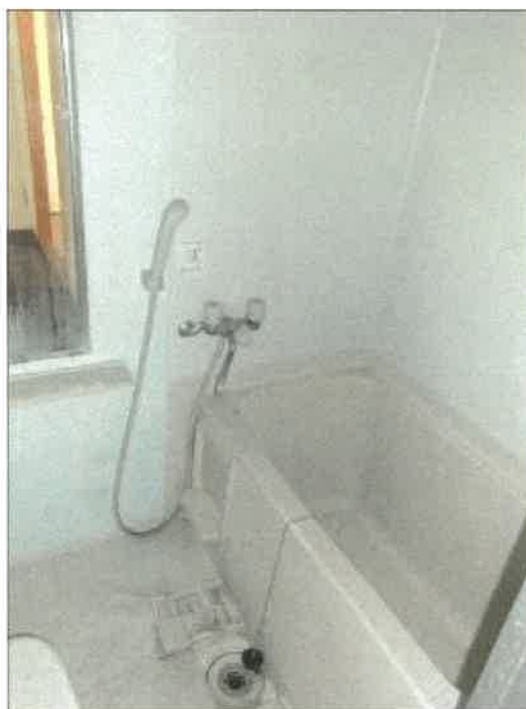
物件4建物の4階401号室の浴室の状況
