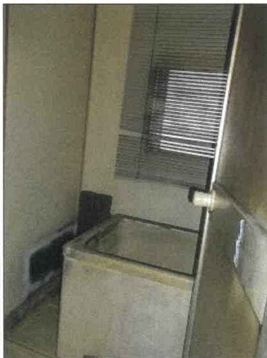
物件4建物の4階402号室の浴室の状況
