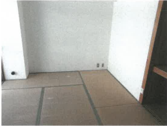
物件4建物の4階401号室の和室の状況
