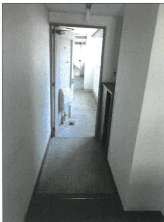
物件 4 建物の 4 階 4 0 1 号室の玄関付近の状況
