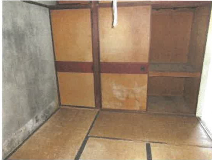
物件4建物の5階502号室の和室の状況
