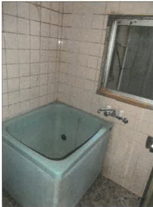
物件4建物の5階502号室の浴室の状況
