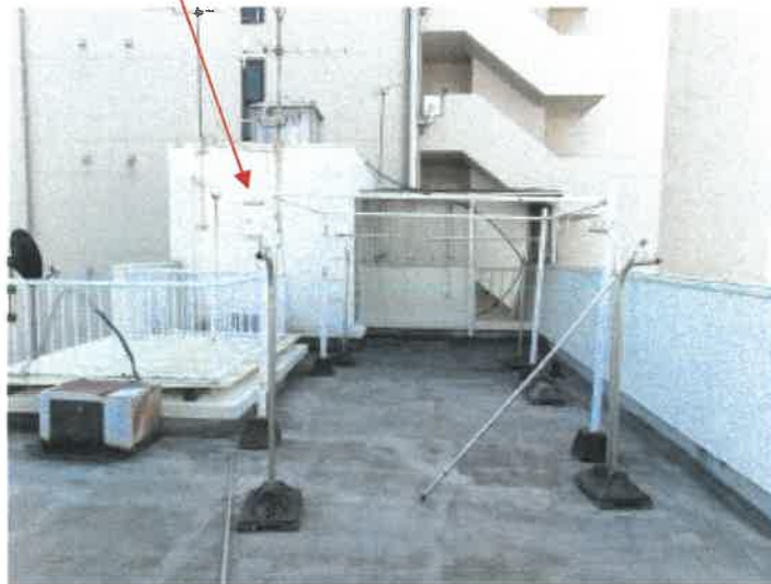
物件4建物の屋上の状況
