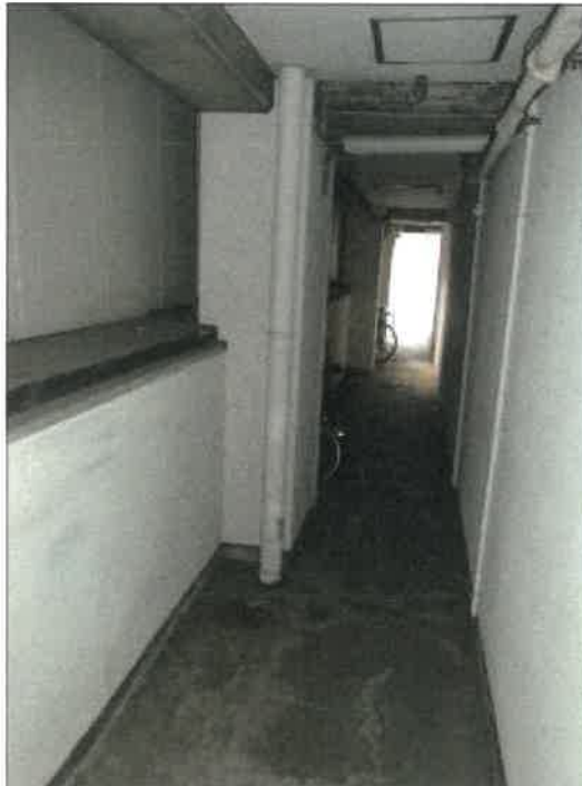
物件4建物の1階西側通路の状況
