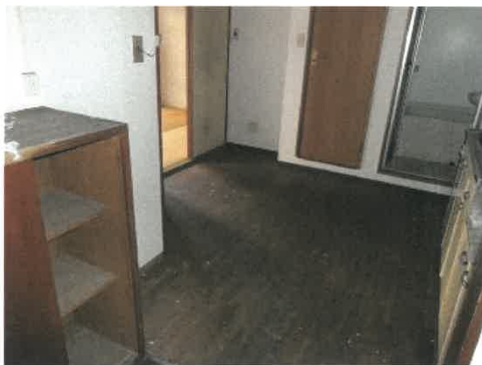
物件4建物の3階201号室のDKの状況
