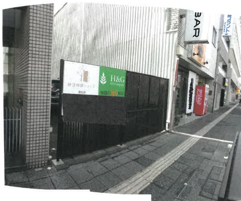
物件5土地北側フェンス（土地定着性有）の状況
