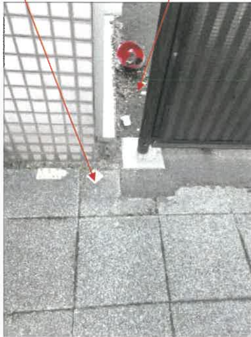
物件5 土地北東角点付近の状況 境界石柱
