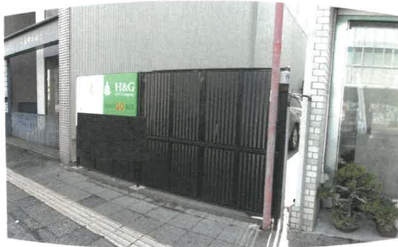
物件5土地北側フェンス（土地定着性有）の状況
