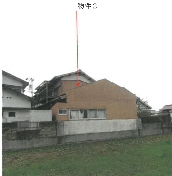
物件 2 建物東面の状況
