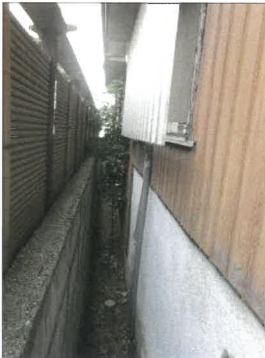
物件 2 建物北側の状況
