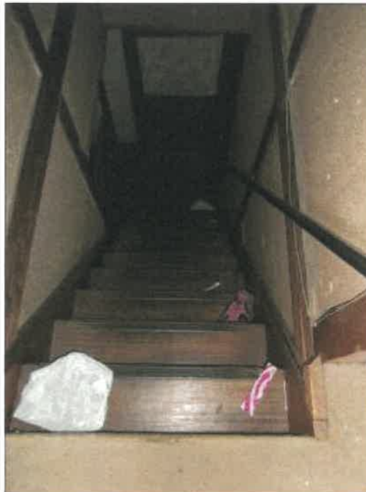
物件2 建物の階段の状況
