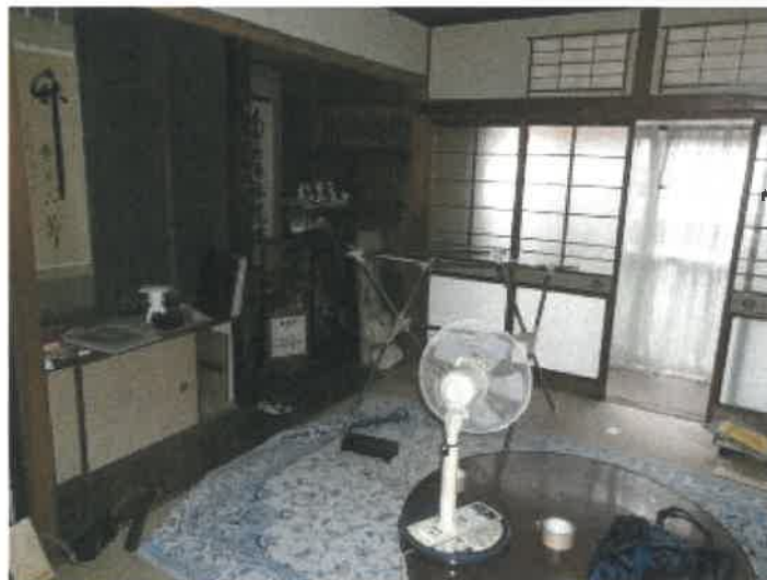
物件 2 建物の 1 階東側南和室の状況
