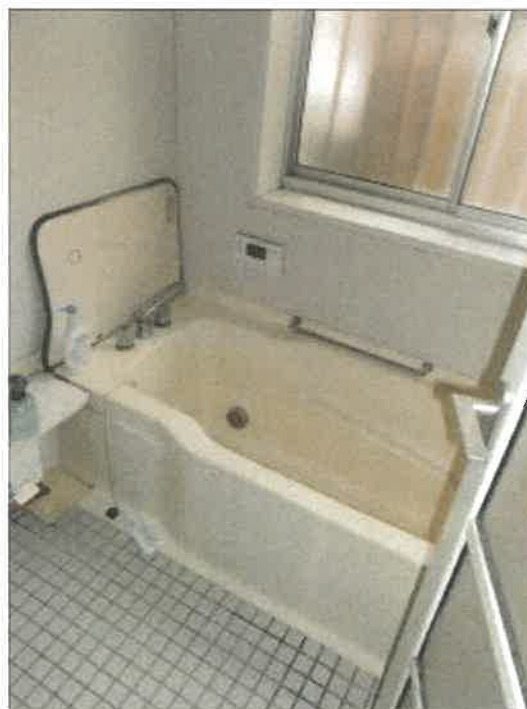
物件2建物の1階浴室の状況
