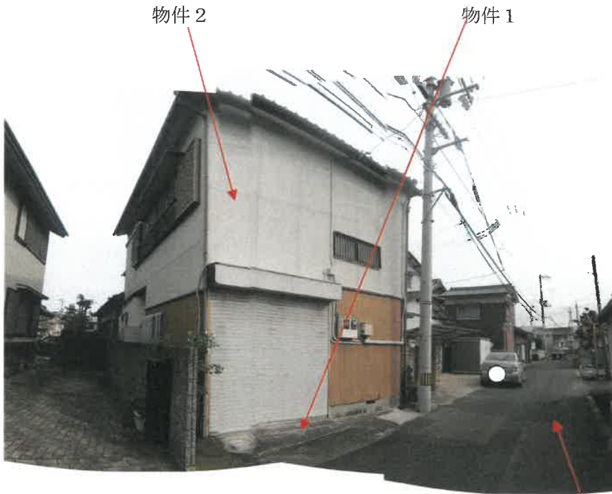
物件 1 土地西側及び北側境界付近の状況
