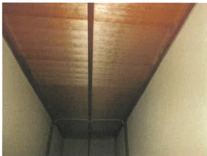
物件2建物の2階東側東西縁側の状況
