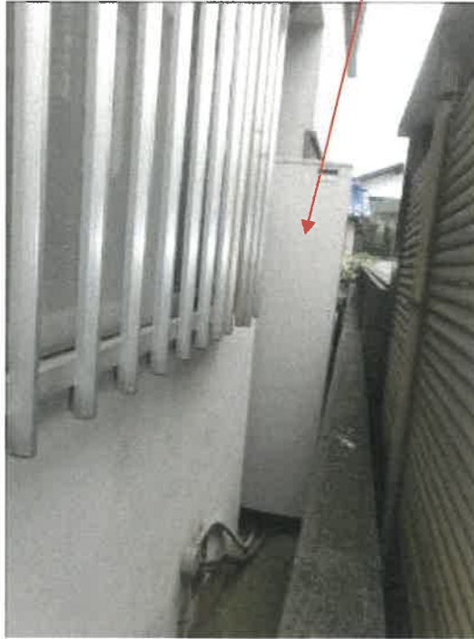
物件 2 建物北側の状況
