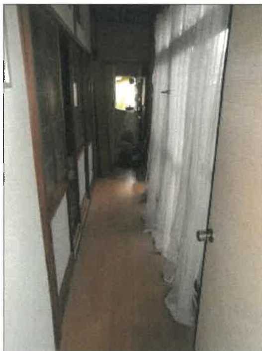
物件 2 建物の 1 階南側東西縁側の状況
