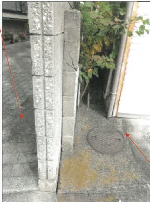
物件 1 土地北側境界付近の状況
