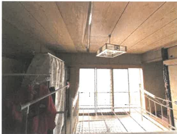
物件2 1階南西側和室の状況
