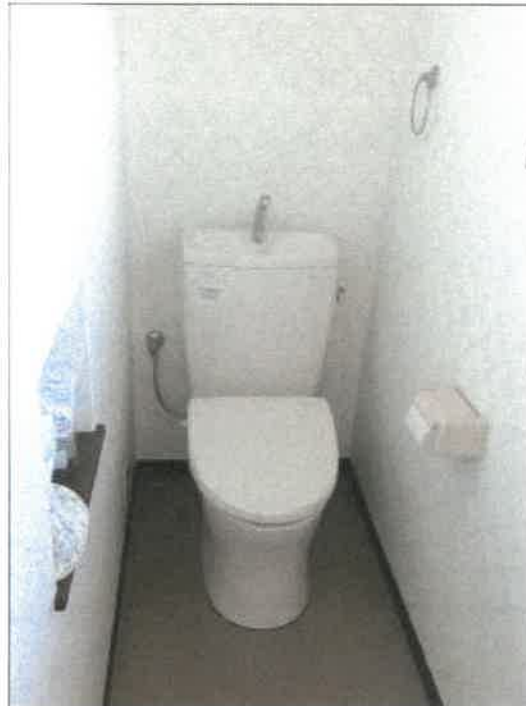
物件 2 建物の 2 階トイレの状況
