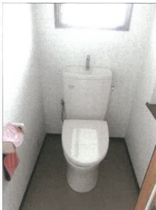
物件2建物の1階トイレの状況
