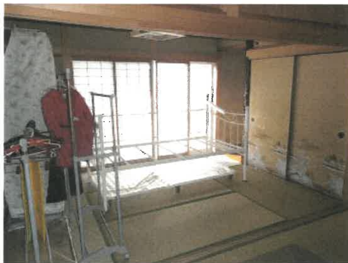
物件 2 建物の南側和室の状況
