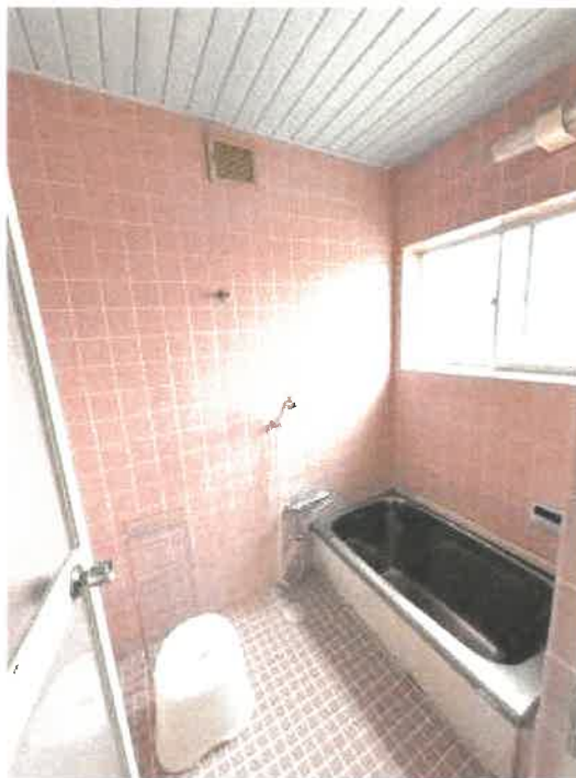
物件2 1階浴室の状況
