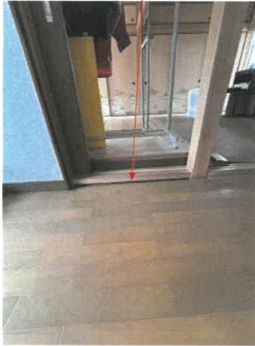
物件2 1階廊下の状況
