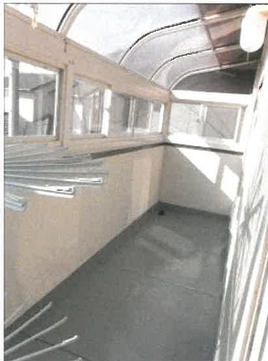
物件 2 建物の 2 階南側サンルーム（元ベランダ）の状況
