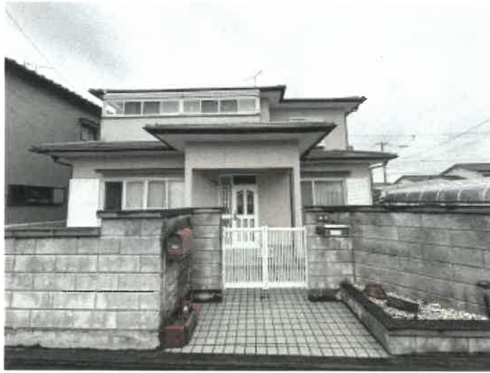
物件2 南側の状況
