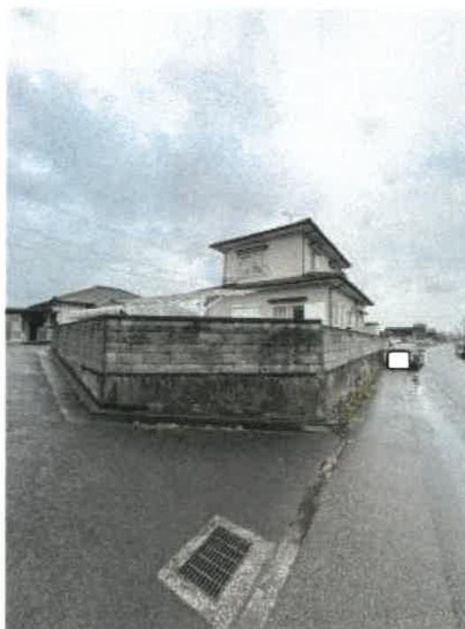
本件物件北東側の状況
