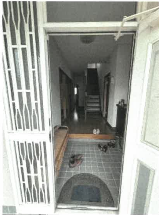
物件2 玄関内の状況
