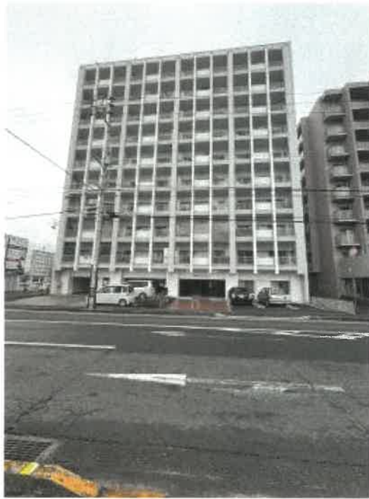
労住協第11ビル京町マンションの外観
