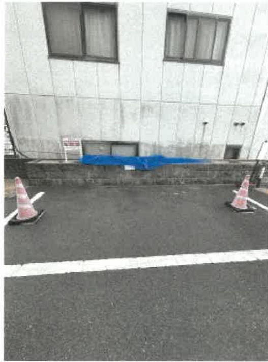
マンションゴミ置場の状況
