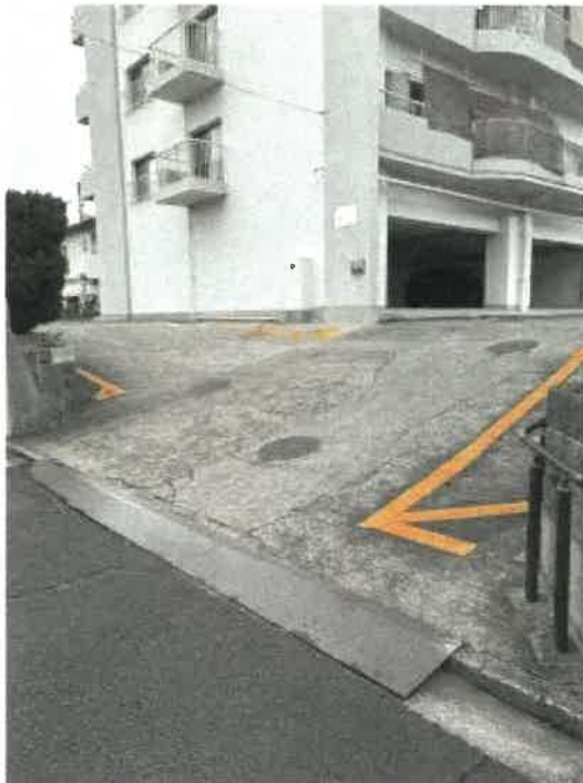
マンション南側の状況
