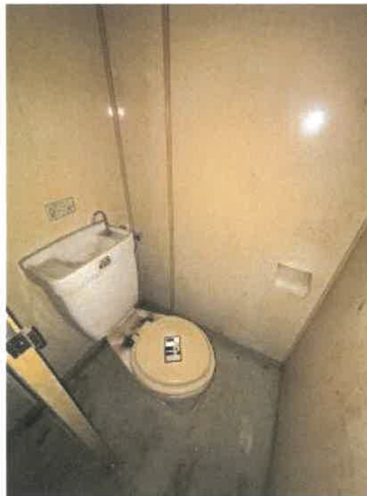
物件 1 トイレの状況
