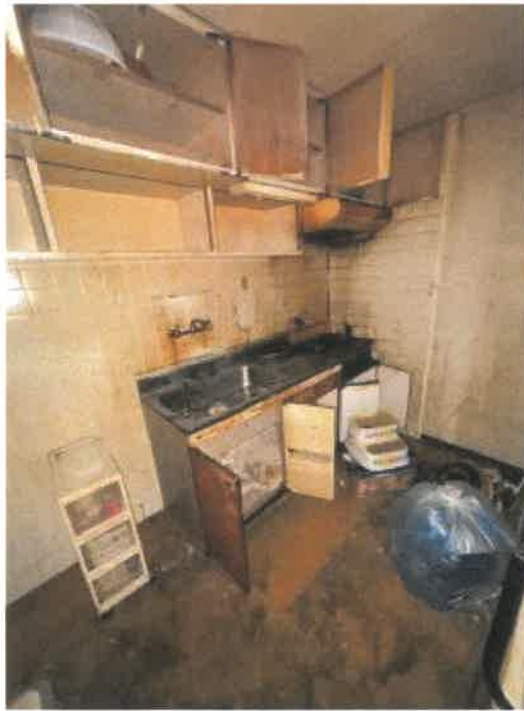
物件 1 台所の状況
