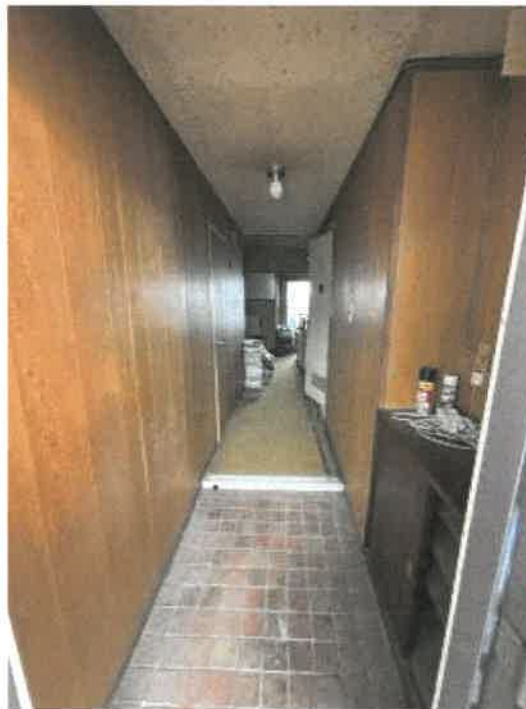
物件1 玄関内の状況
