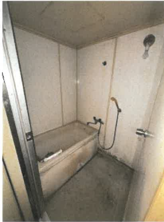
物件 1 浴室の状況
