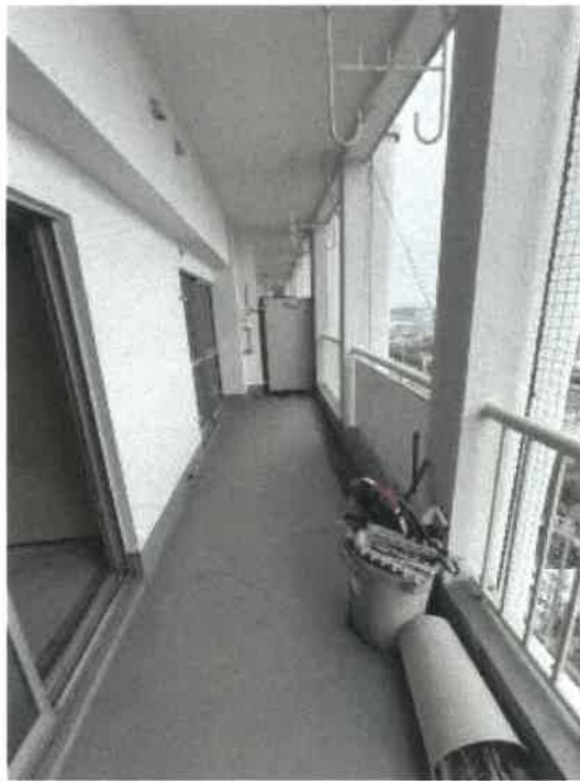
物件1 バルコニーの状況
