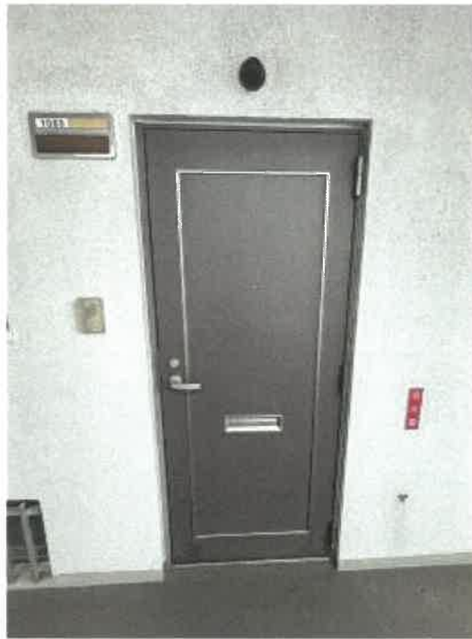
物件1 入口ドアの状況
