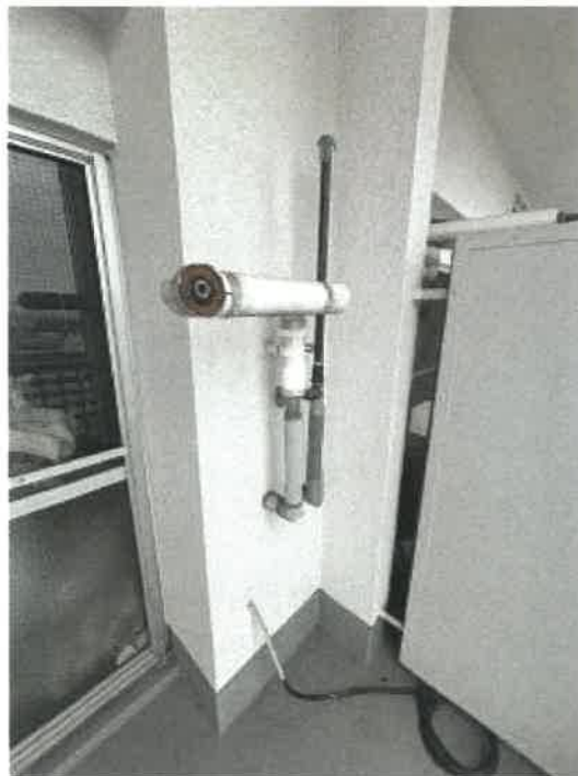
物件1 バルコニーのユノックス取外し状況
