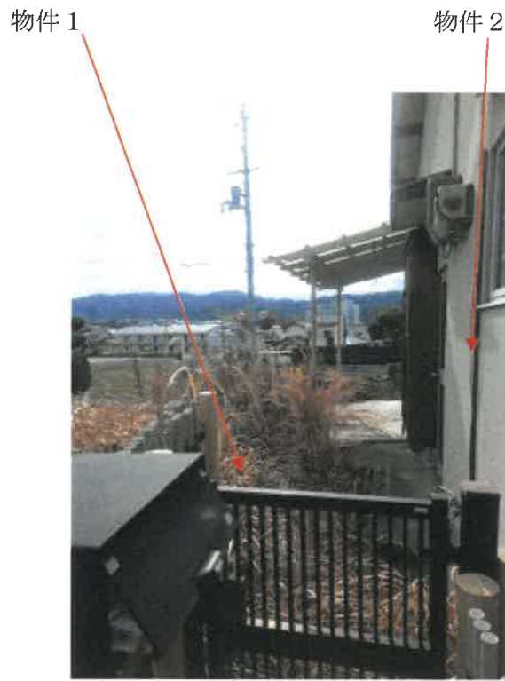
物件2建物南東側の状況
