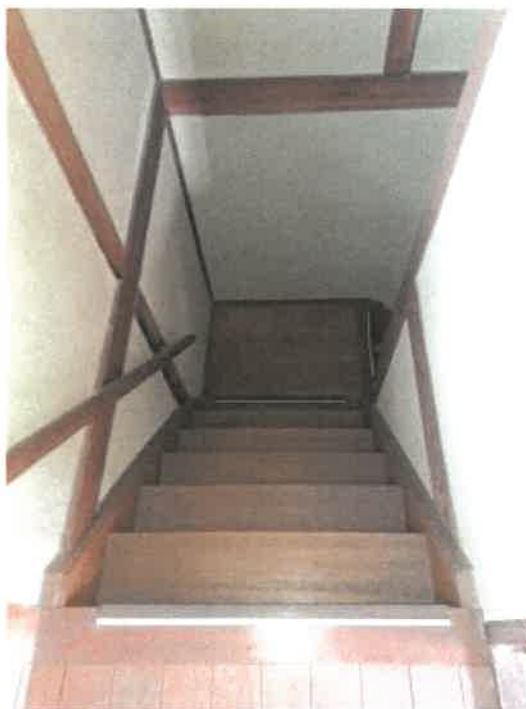
物件 2 建物の階段の状況
