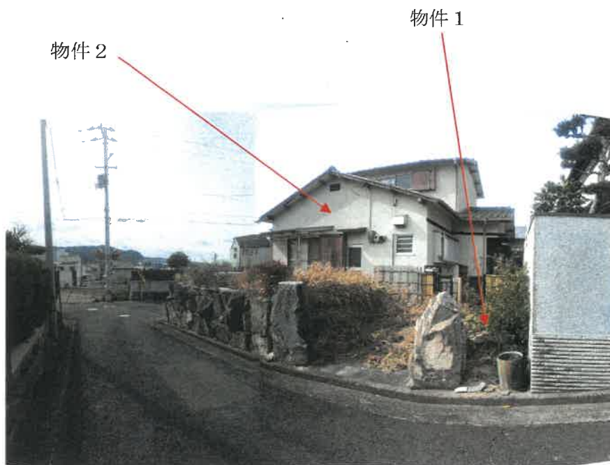
物件 1 土地南東側及び北東側境界付近の状況
