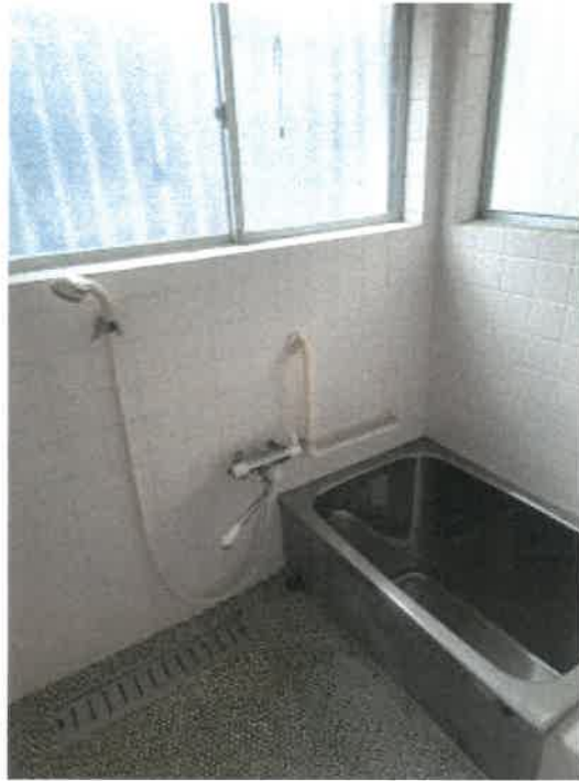
物件 2 建物の 1 階浴室の状況
