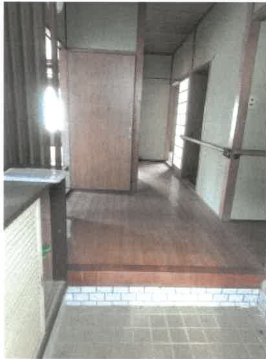
物件2建物の1階玄関周りの状況
