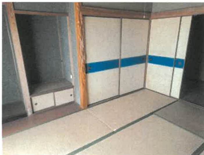
物件2建物の1階南西側西和室の状況
