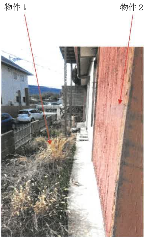
物件2建物南西側の状況
