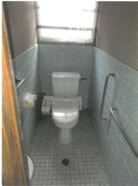
物件 2 建物の 1 階トイレの状況
