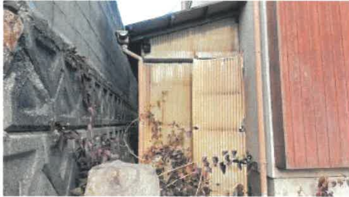
物件2建物北西側の未登記附属建物（物置）の状況
