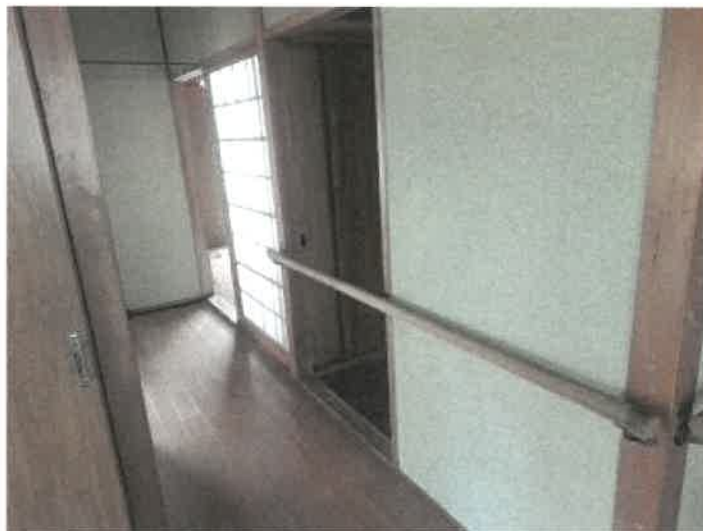
物件2建物の1階玄関前廊下の状況
