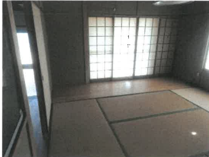
物件2建物の1階南西側東和室の状況
