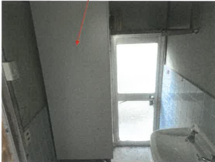
物件2建物の1階洗面脱衣所の状況
