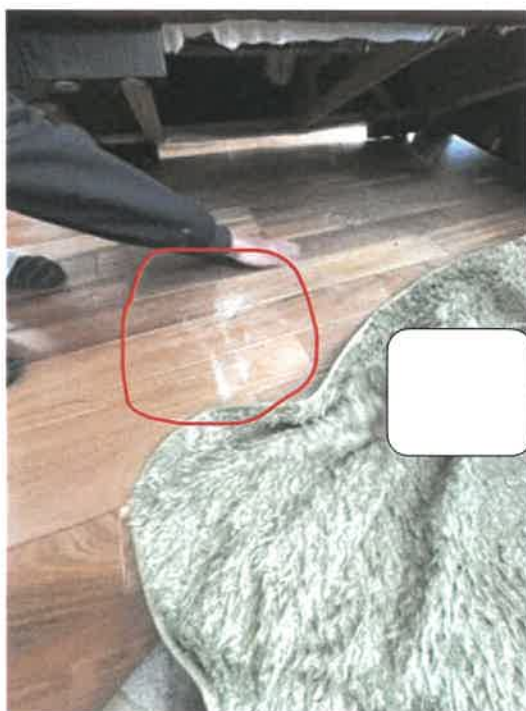
物件2 1階LDK ソファ下床の傷の状況
