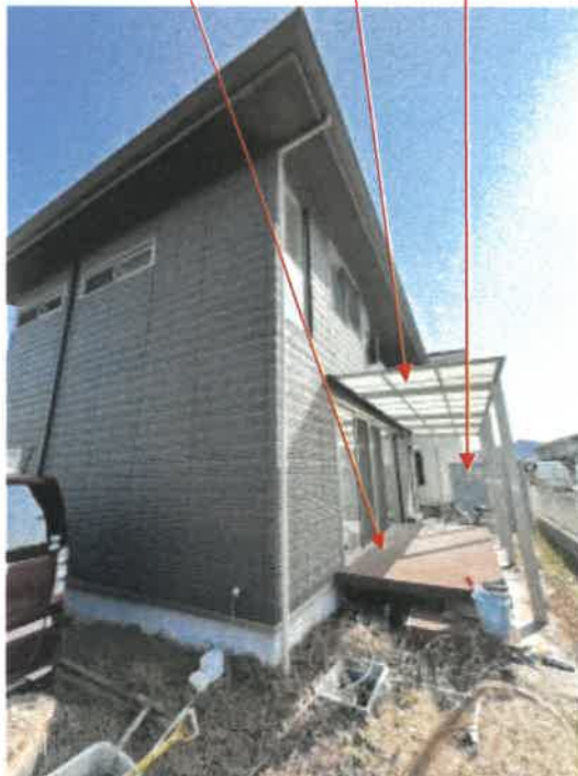
物件1 南側の状況
