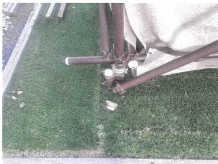
物件1 土地北西側凸部分のパイプ支柱の構造物の基礎部分の状況
