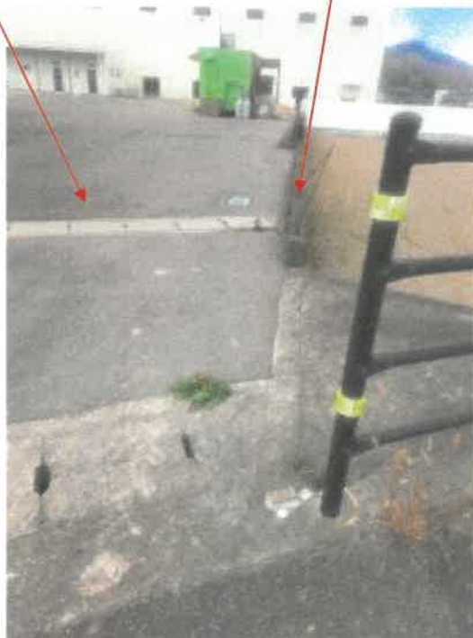
物件 1 土地東側境界付近及び物件 2 土地（用悪水路）の状況
