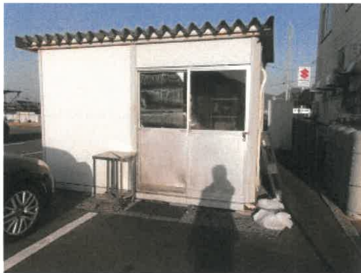
物件 1 土地南側中央付近より東側のコンテナハウスの状況
