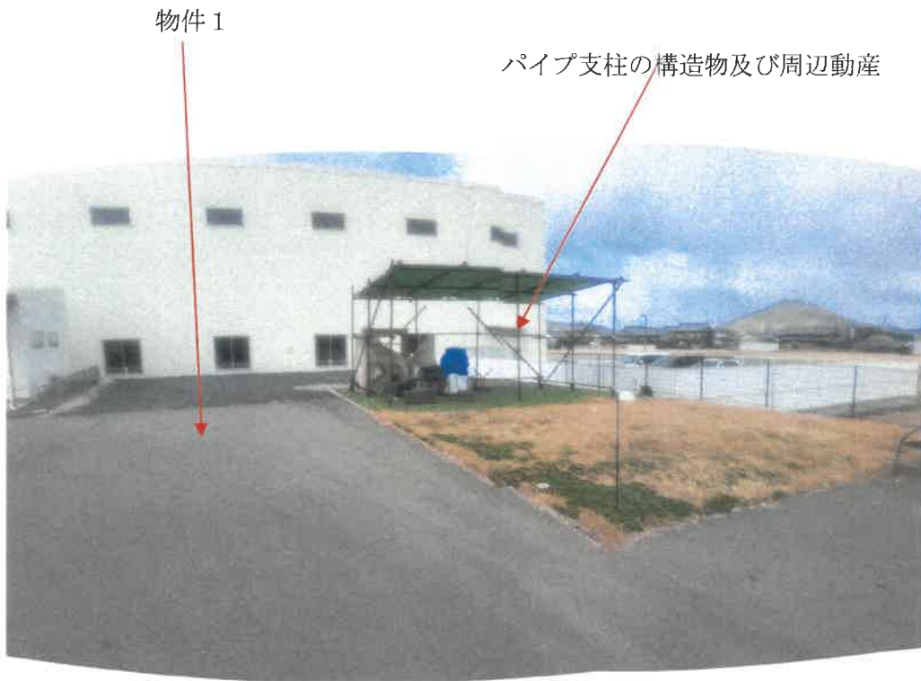
物件1 土地北西側凸部分のパイプ支柱の構造物及び周辺動産の状況
