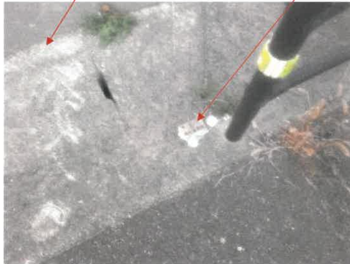
物件 1 土地東側南端点付近の境界プレート及び国土調査の際のピンの状況
