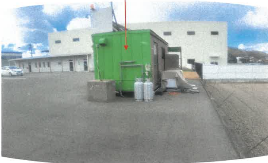
物件1 土地北東側中央より北寄り付近に存在するコンテナハウスの状況
