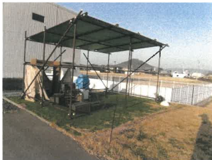
物件1 土地北西側凸部分のパイプ支柱の構造物及び周辺動産の状況
