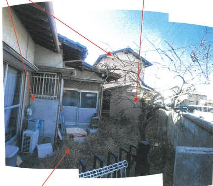
物件2主である建物南ゾーンの北側の状況
