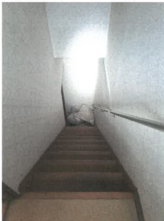
物件 2 主である建物の北ゾーンの階段の状況
