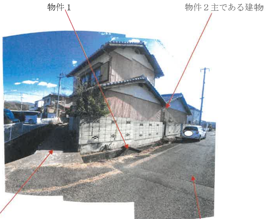
物件1 土地西側及び北東側境界付近の状況
