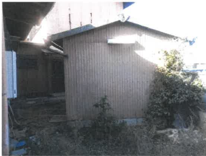
物件2未登記附属建物の状況
