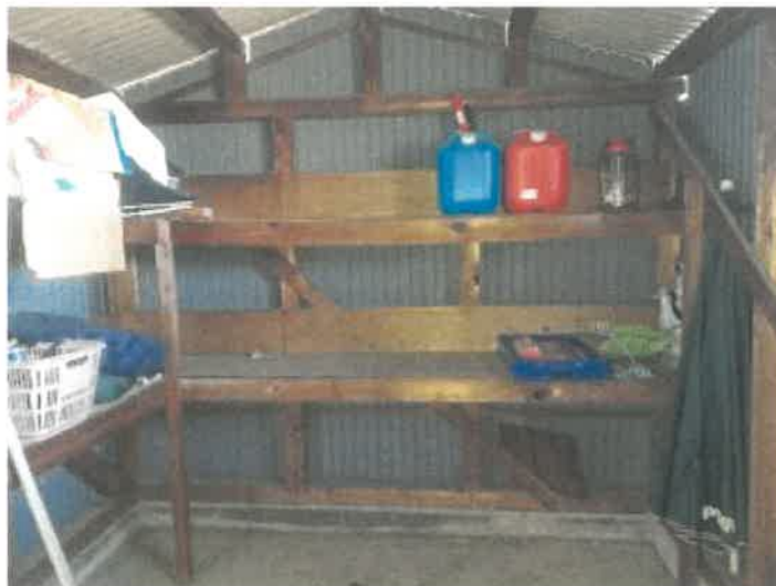
物件2 未登記附属建物の内部の状況
