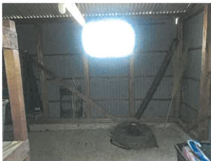
物件2 未登記附属建物の内部の状況
