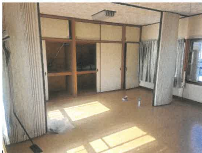
物件 2 主である建物の北ゾーンの 2 階洋室の状況
