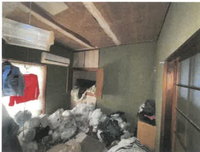
物件2 南東側和室の状況
