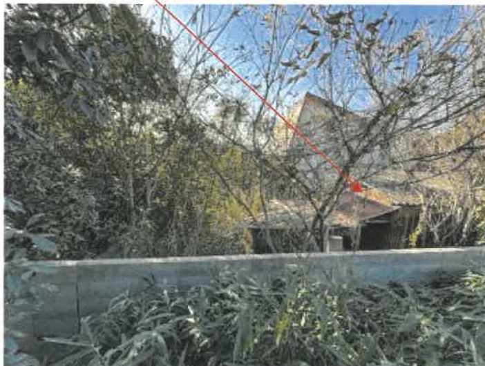
本件物件南東側の状況
