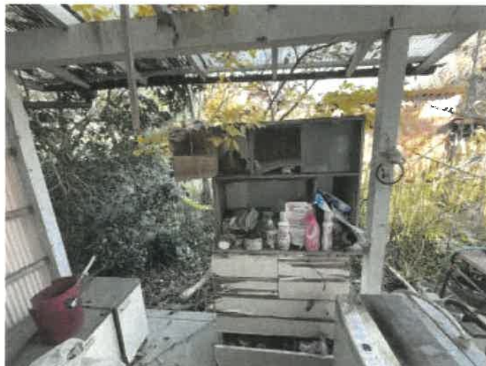
物件2 東側（キッチン外）の状況
