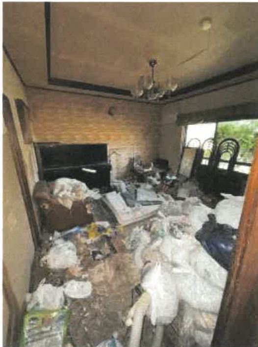
物件2 洋室の状況
