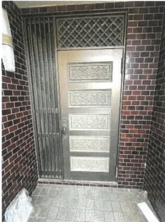
物件2 玄関入口付近の状況
