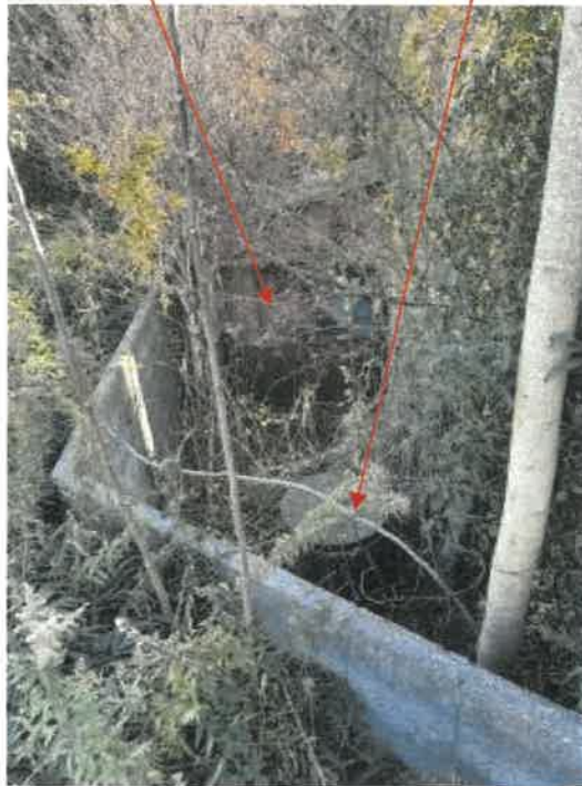
物件1 北東側の状況
