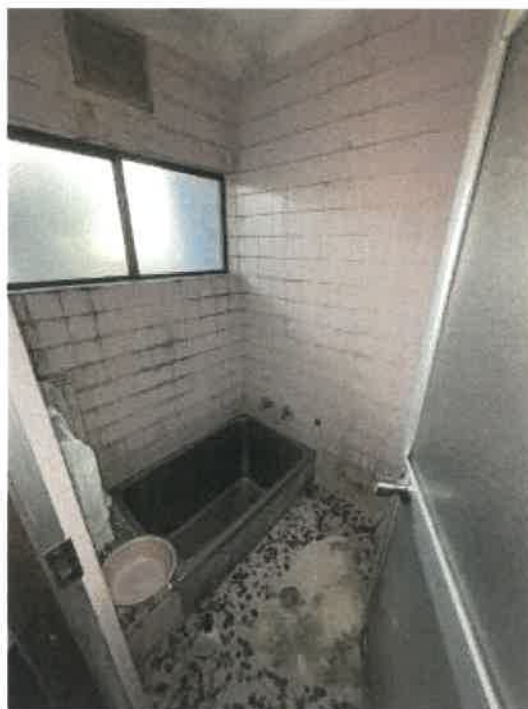
物件2 浴室の状況
