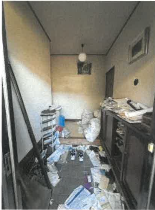
物件2 玄関内の状況
