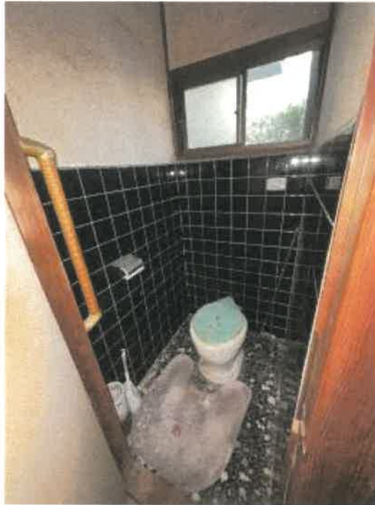
物件2 トイレの状況
