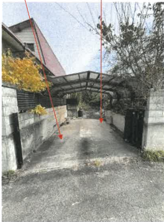
物件1 南西側カーポートの状況
