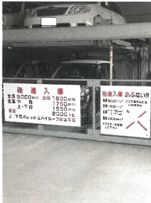
本件マンションの機械式駐車場の状況
