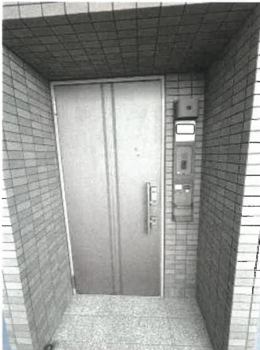
本件物件（902号室）の玄関ドアの状況
