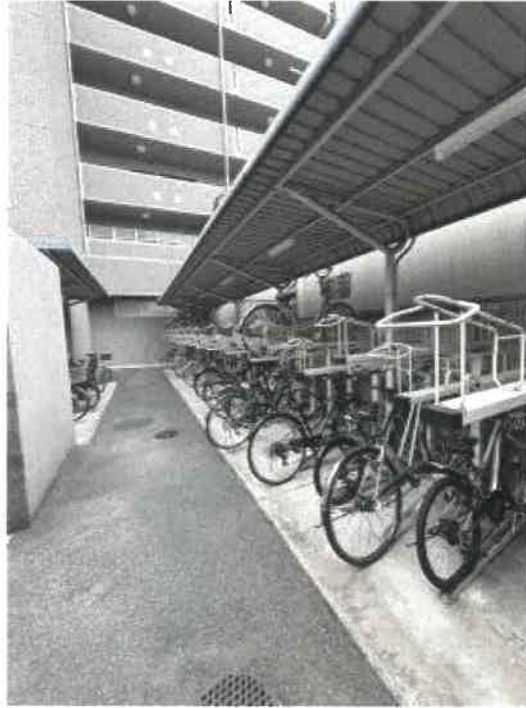
本件マンションの駐輪場の状況
