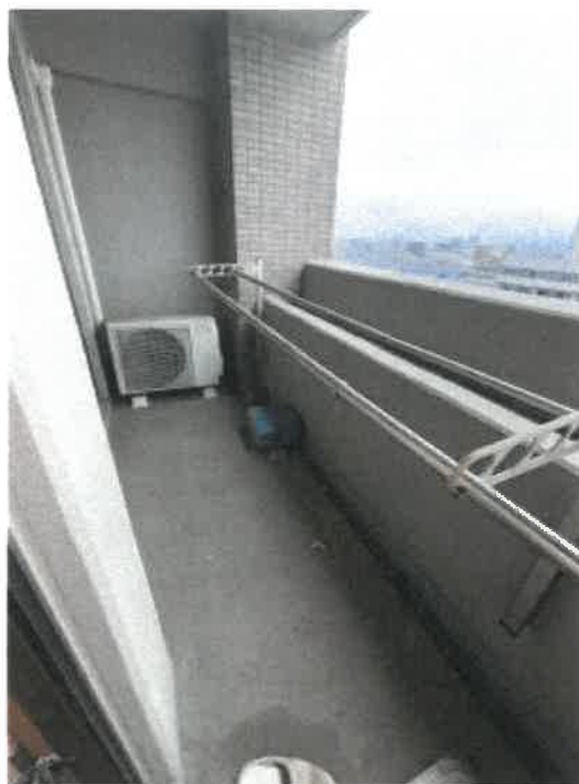
本件物件バルコニーの状況
