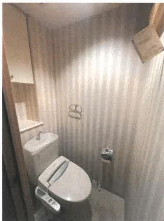
本件物件トイレの状況
