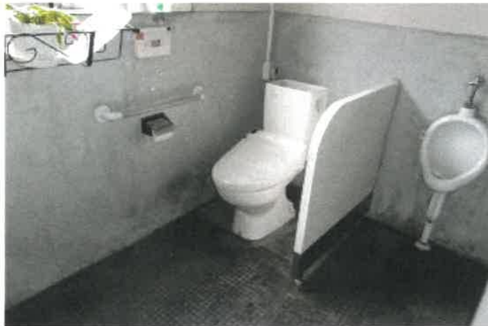
物件2 附属建物符号2の南側事務所ゾーンのトイレの状況
