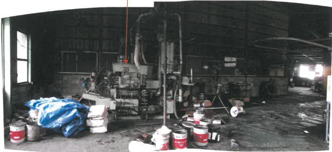
物件 2 主である建物工場部分の状況
