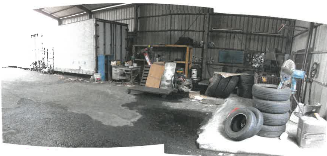
物件 2 主である工場部分南側の西側下屋内の状況
