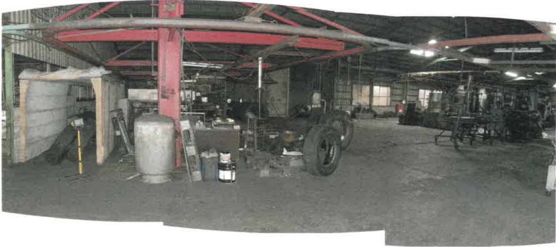
物件2主である建物工場部分の状況
