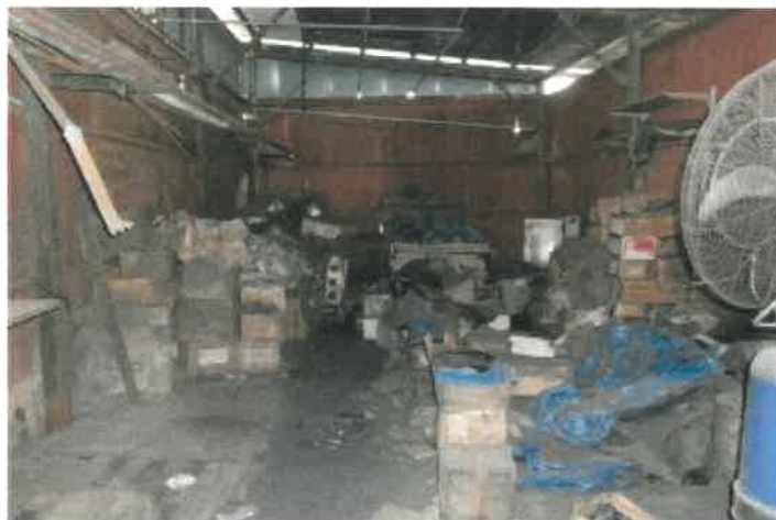
物件 2 主である工場部分北側の東側下屋内に存在する廃タイヤボイラ兼焼却炉の南方奥の状況
