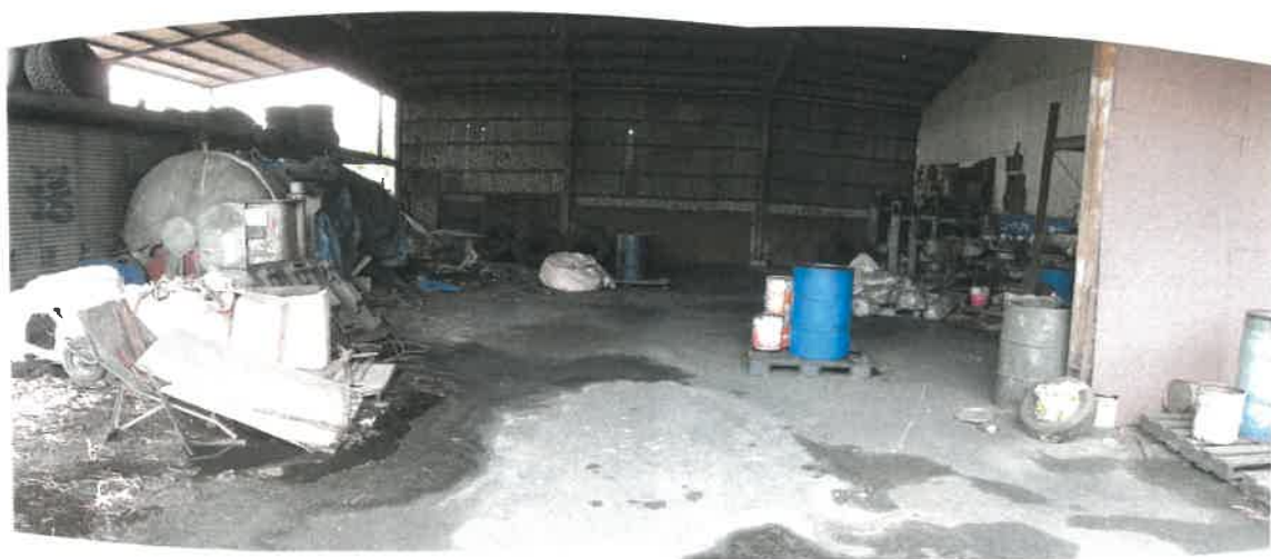
物件2建物附属建物符号2の倉庫部分の北側下屋内の状況
