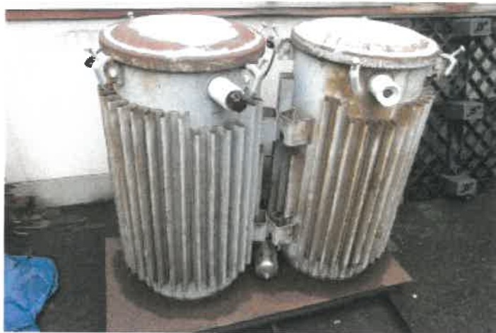
物件 2 主である建物の西側の南側下屋の北側付近の放置されたトランスの状況
