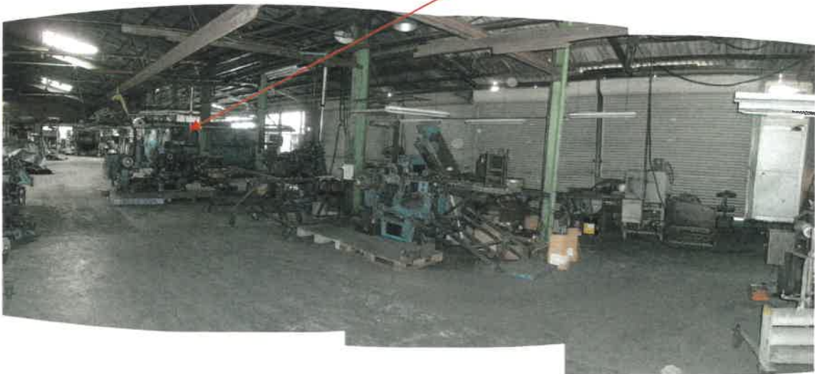
物件2主である建物工場部分の状況
