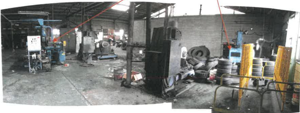
物件2主である建物工場部分の状況
