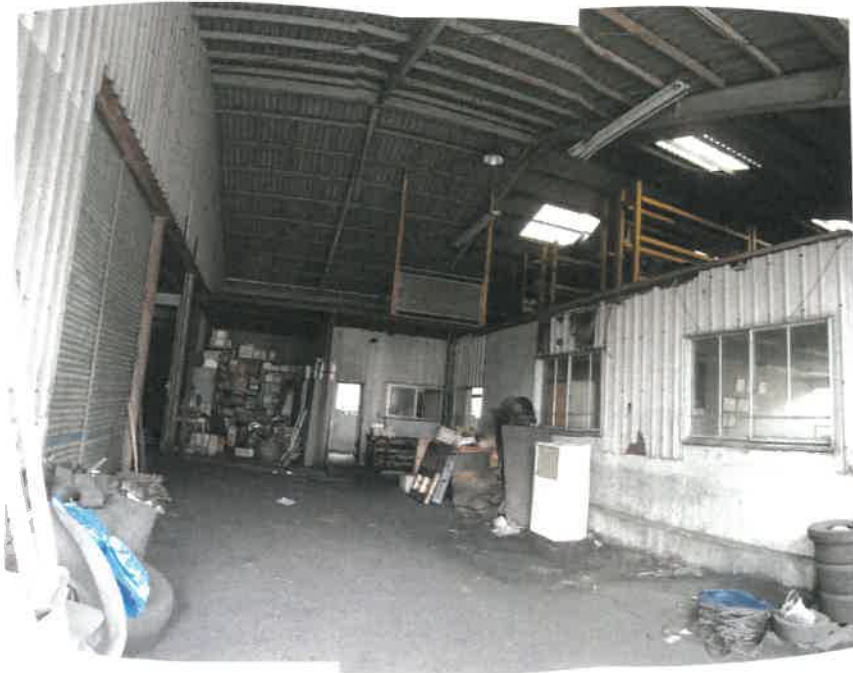
物件2附属建物符号2の中央部分荷捌場の状況
