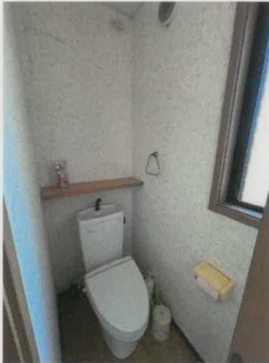
物件3 3階トイレの状況
