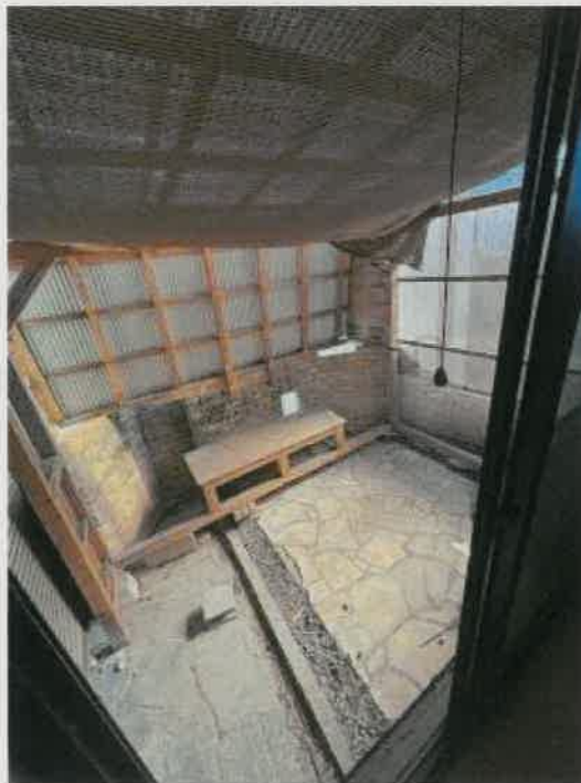
物件3 下屋内の状況
