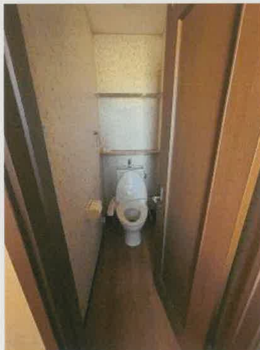
物件3 2階トイレの状況
