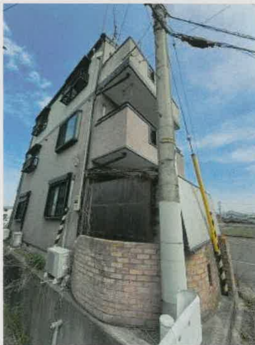
物件 1、3 南西側の状況
