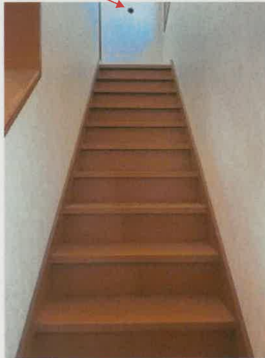
物件3 2階階段の状況
