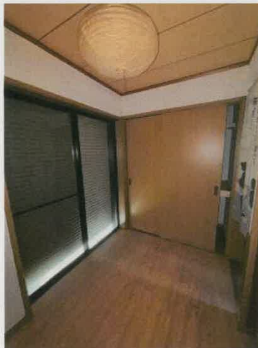
物件3 1階縁側の状況
