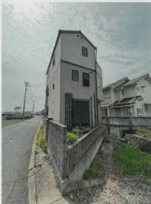
物件 1、3 北東側の状況
