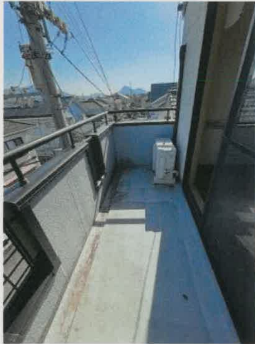
物件3 3階南側バルコニーの状況
