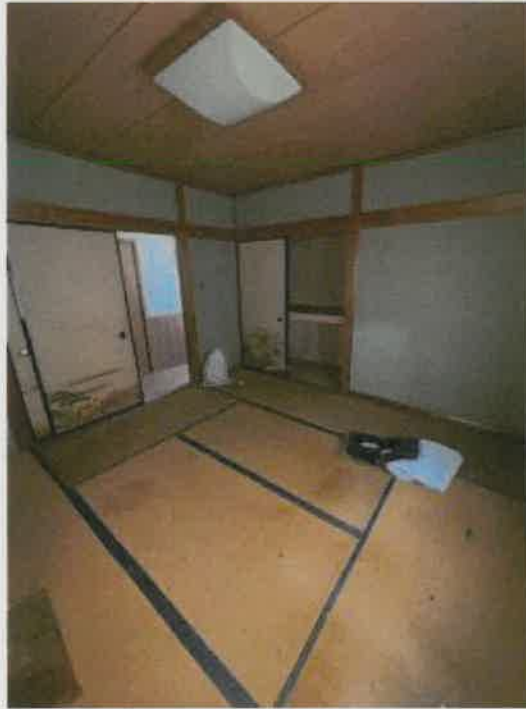
物件3 1階和室の状況
