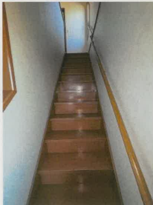
物件3 1階階段の状況
