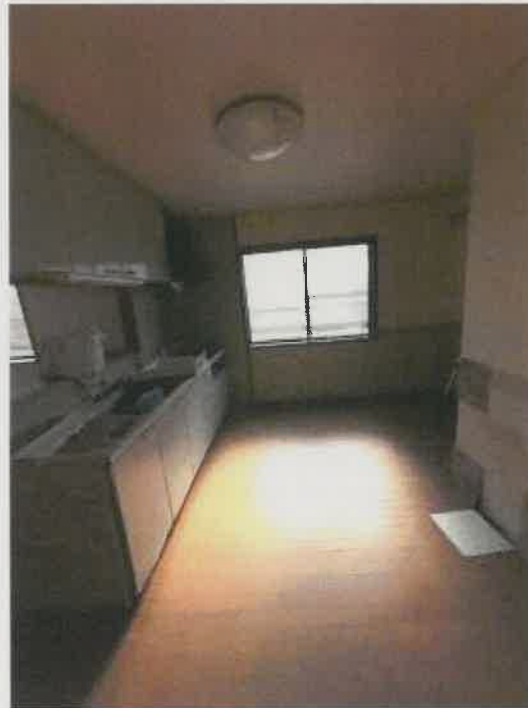
物件3 2階台所の状況
