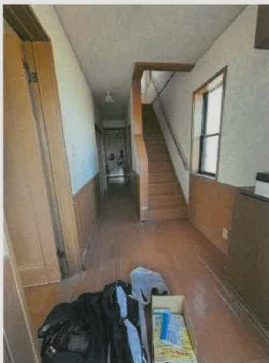
物件 3 玄関内の状況
