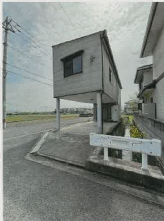
物件 2、4 北西側の状況
