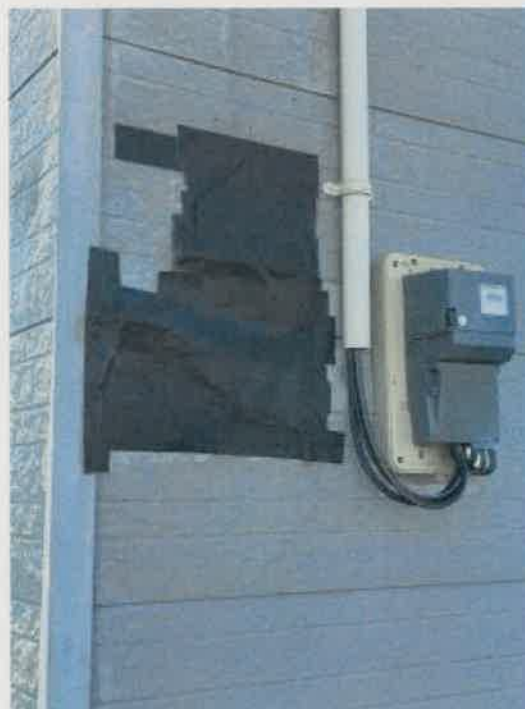
物件 4 外壁南東側の状況
