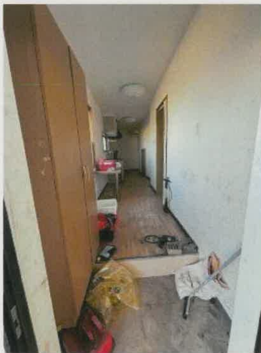
物件4 玄関内の状況
