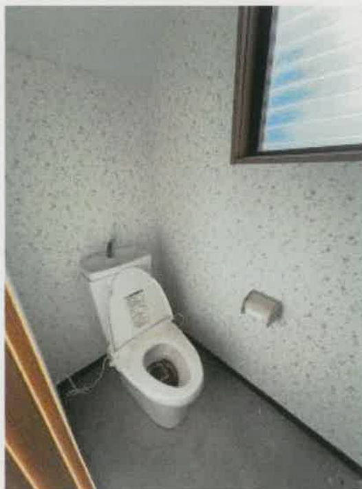
物件4 1階トイレの状況
