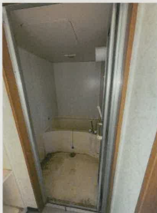
物件4 1階浴室の状況
