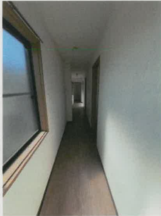
物件4 2階廊下の状況
