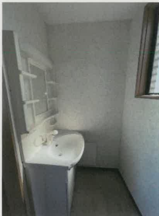
物件4 1階洗面所の状況
