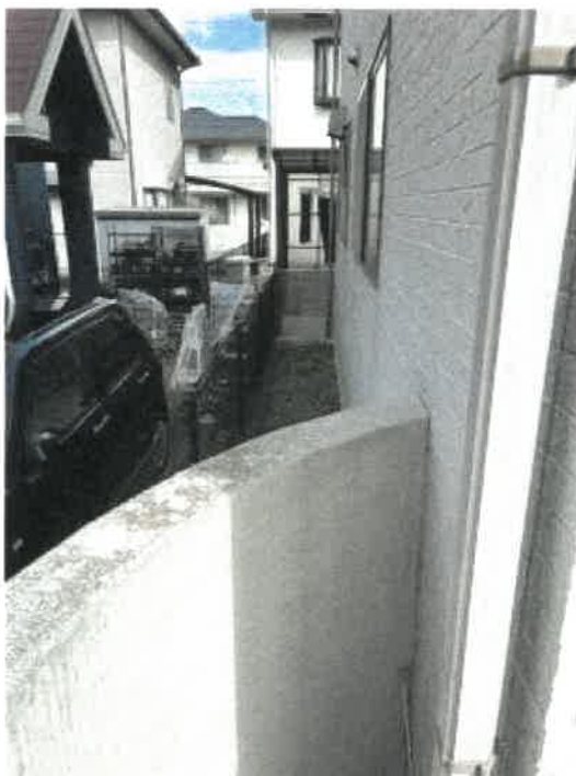
物件1 南西側の状況
