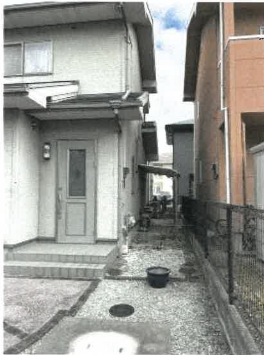
物件1 南東側の状況
