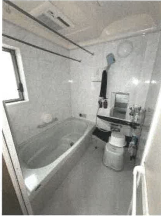
物件2 1階浴室の状況
