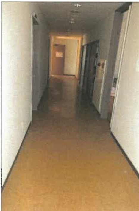
物件3 2部分2階廊下の状況
