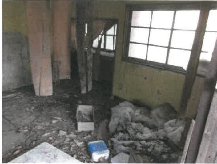
物件30主である建物の内部の状況
