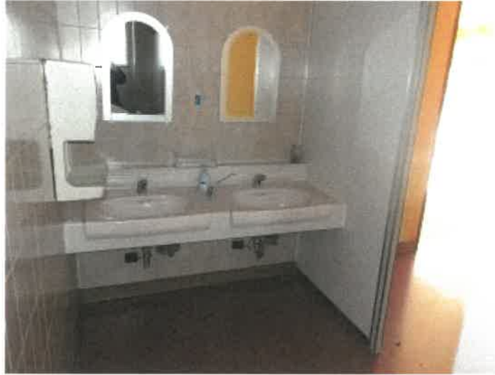
女性トイレの手洗場の状況
