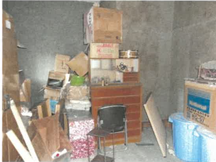
物件35建物増築部分Bの2階倉庫内の状況
