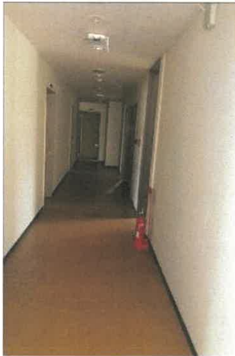
物件3 2部分3階の廊下の状況
