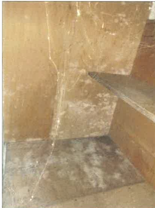
物件35未登記附属建物Cの2階南端倉庫の状況
