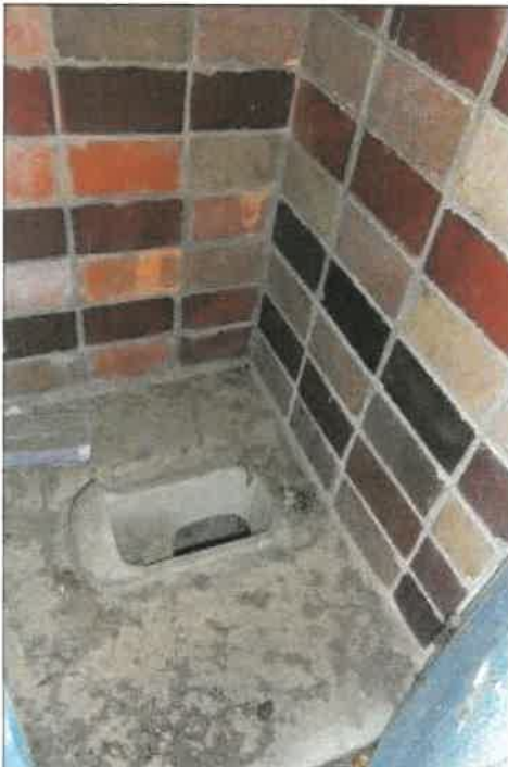
物件35未登記附属建物Eの状況
