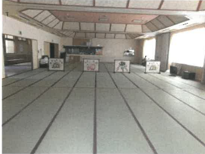
物件 3 5 建物の 2 階大広間南西側の状況
