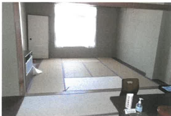
物件3 2部分3階客室⑦の状況
