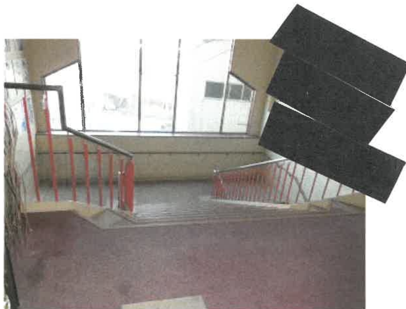
物件35建物の3階から2階への階段の状況
