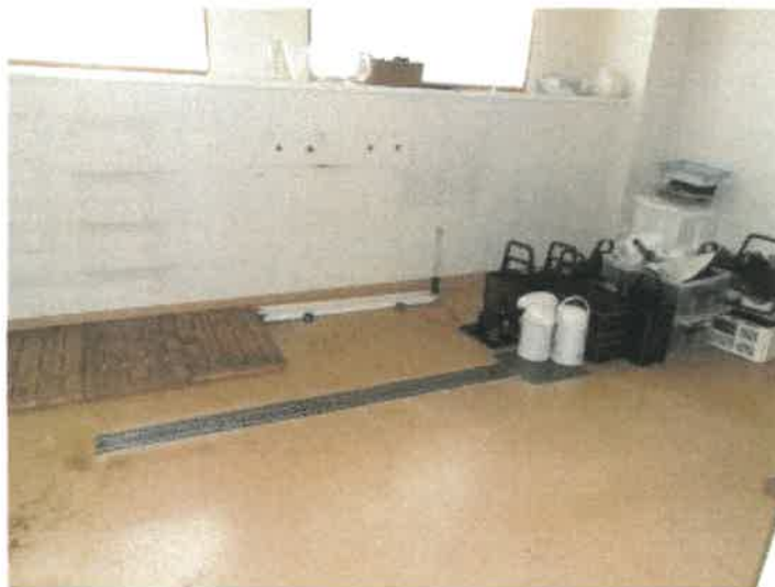
物件35建物の2階エレベーター昇降口奥の倉庫の状況
