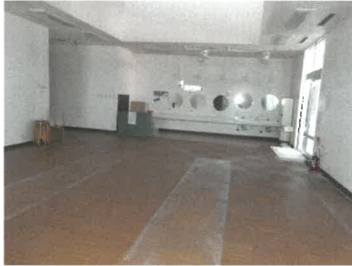
物件35建物3階の女性用脱衣場の状況
