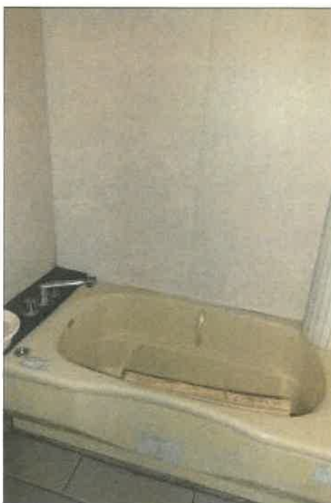
物件3 1部分の1階浴室の状況
