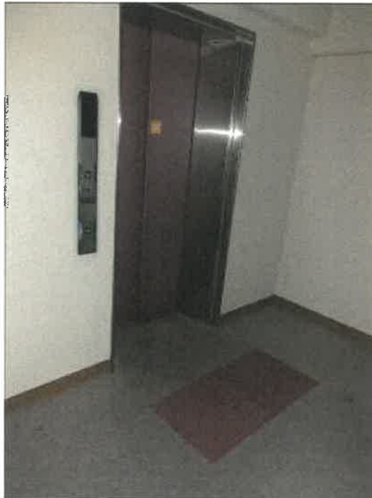
物件 3 5 建物の 1 階のエレベーター昇降口の状況
