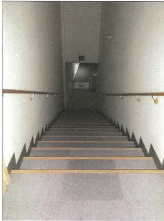
物件 3 5 建物の 2 階から 1 階への階段の状況
