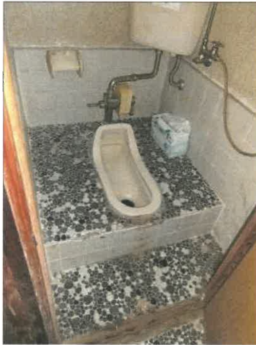
物件34建物の1階トイレの状況
