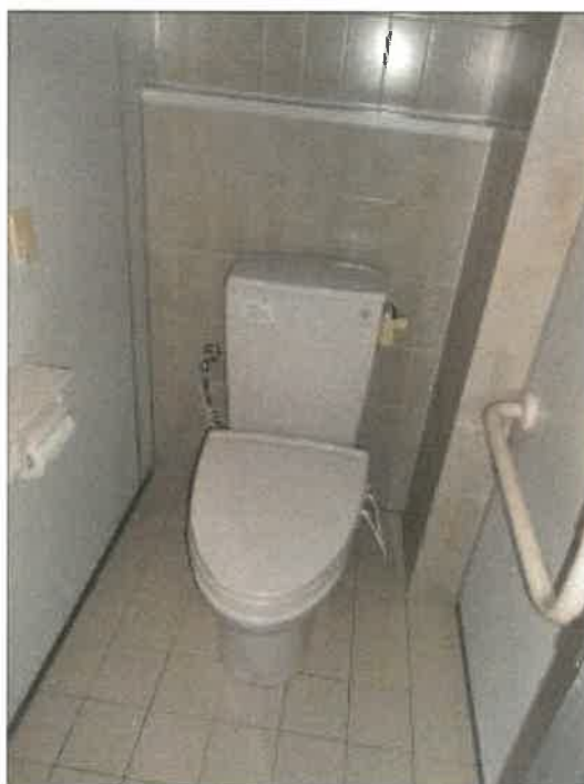
物件35建物の2階女子トイレの状況
