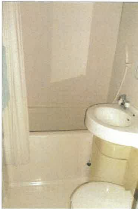
物件3 2部分3階客室⑦の状況
