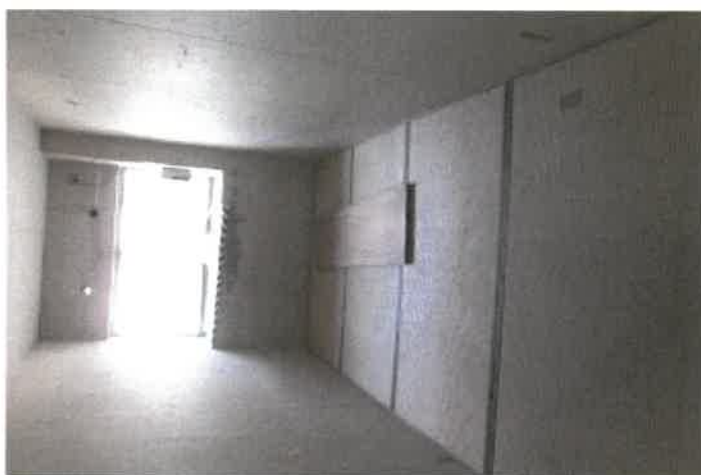
物件35建物増築部分A 1階（役者用宿泊ゾーンの共用スペース）の状況
