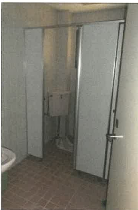
物件3 2部分2階女子トイレの状況
