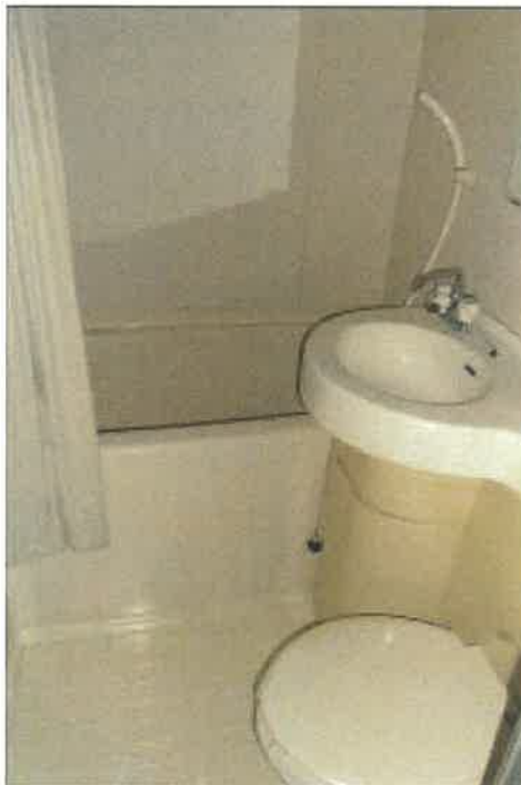
物件3 2部分 2階客室②の状況
