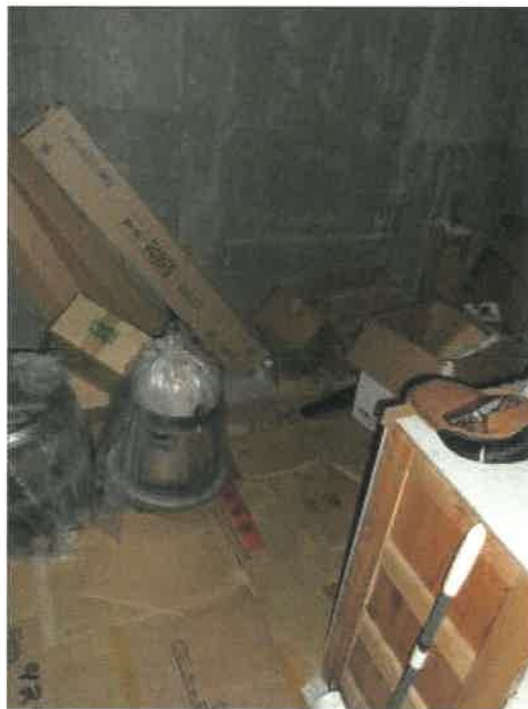
物件35建物の1階のエレベーター前の物入内の状況
