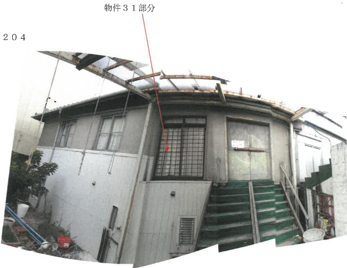
物件31部分の2階広間（宴会場）への出入口付近の状況
