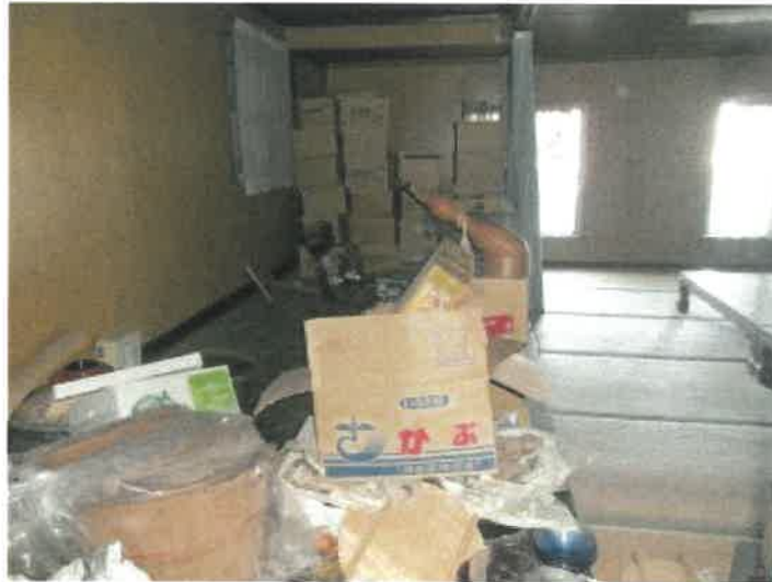
物件31部分の2階広間（宴会場）の状況
