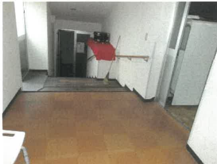
物件35建物増築部分Bの1階南東側廊下の状況
