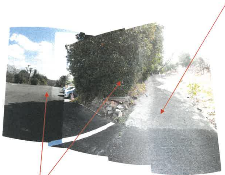
物件9, 10土地西側境界付近の状況
