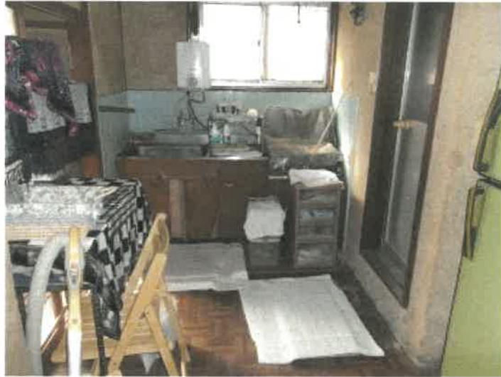
物件34建物の1階台所の状況
