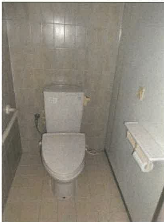
女性トイレ内の状況
