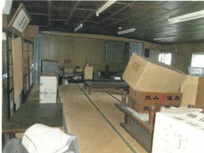
物件3 1部分の2階広間（宴会場）の状況
