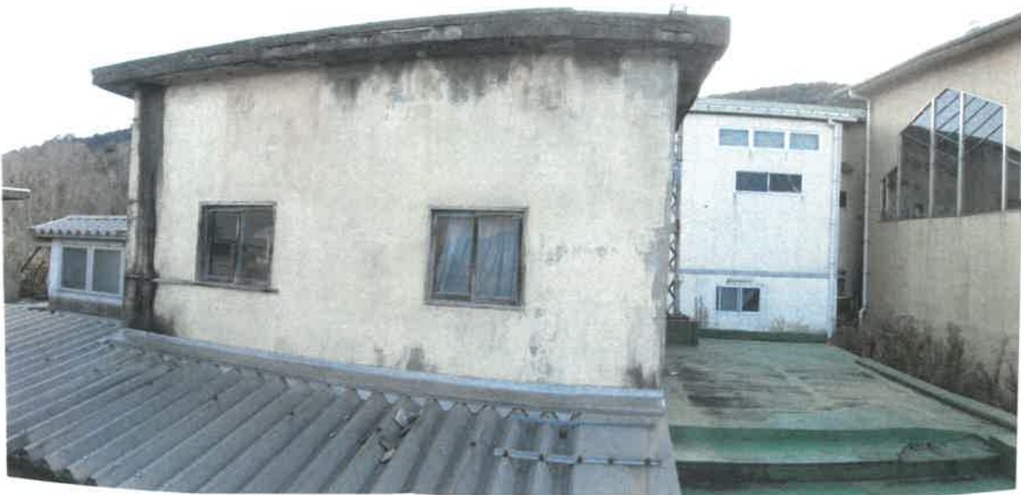
物件35建物増築部分Bの2階倉庫の状況
