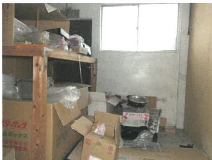
物件35建物南東側の倉庫（増築部分；元厨房）の西端倉庫の状況
