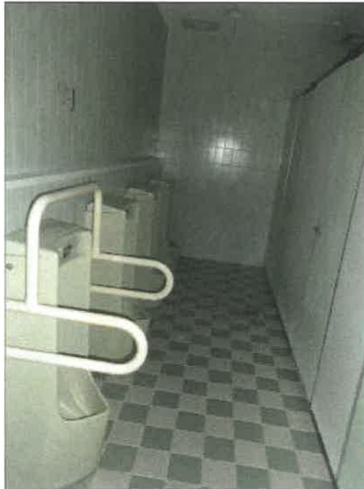
物件35建物の2階男子トイレの状況
