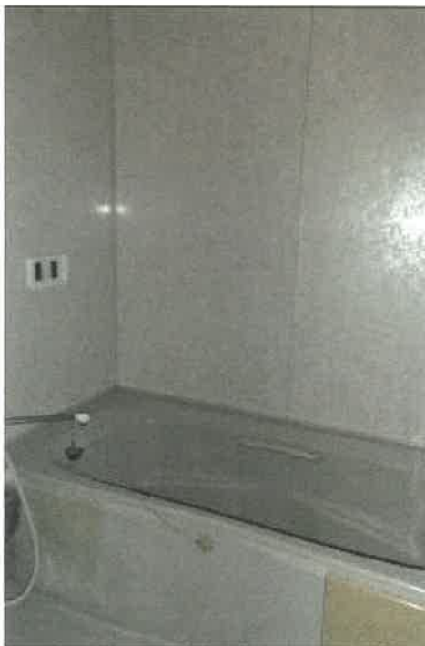
物件35建物増築部分A1階（役者用宿泊ゾーンの宿泊部屋①横の浴室）の状況
