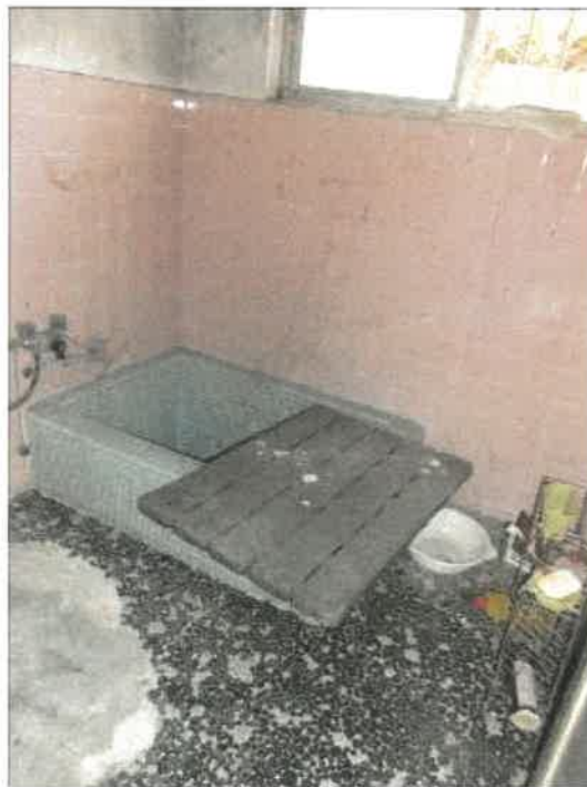
物件34建物の1階浴室の状況
