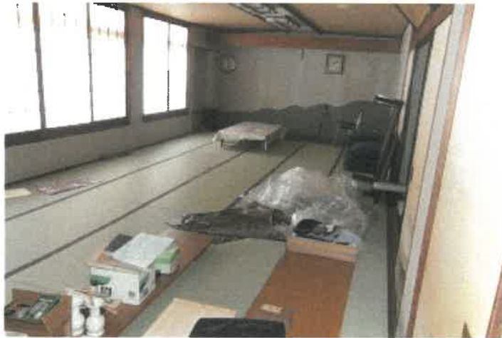
物件 3 2 部分 1 階広間の状況
