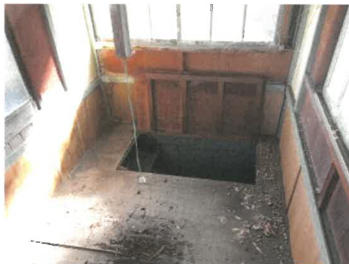
物件 3 5 未登記附属建物 C の 3 階出入口の状況
