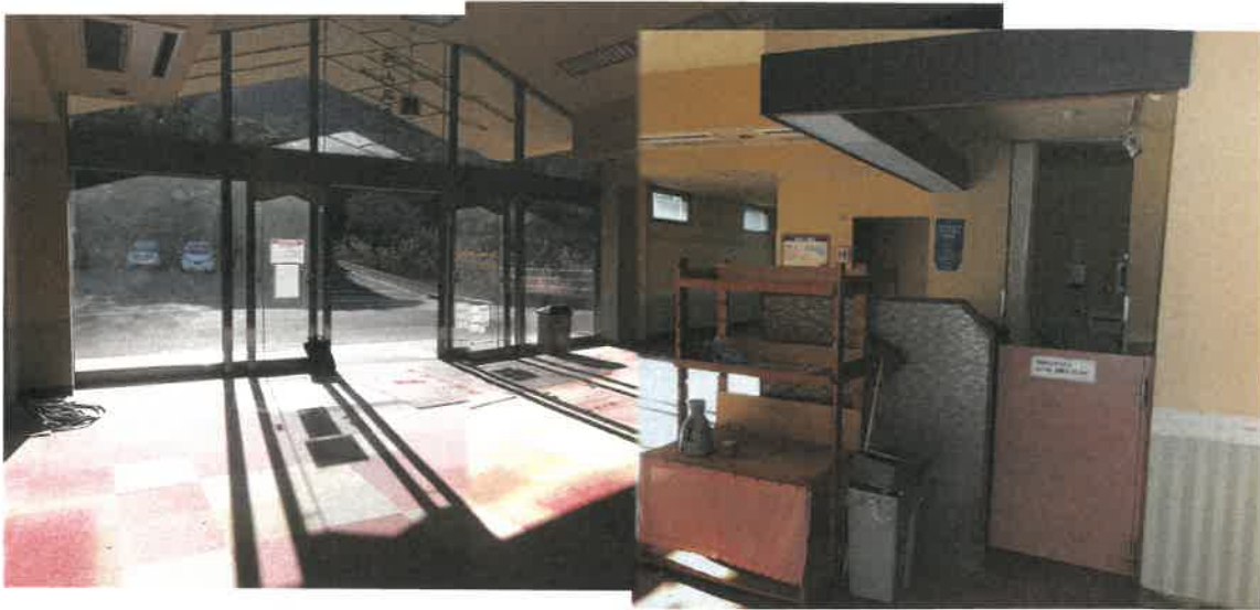
物件35建物の3階温泉出入口付近の状況
