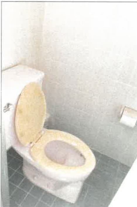
物件3 2部分1階女子トイレの状況
