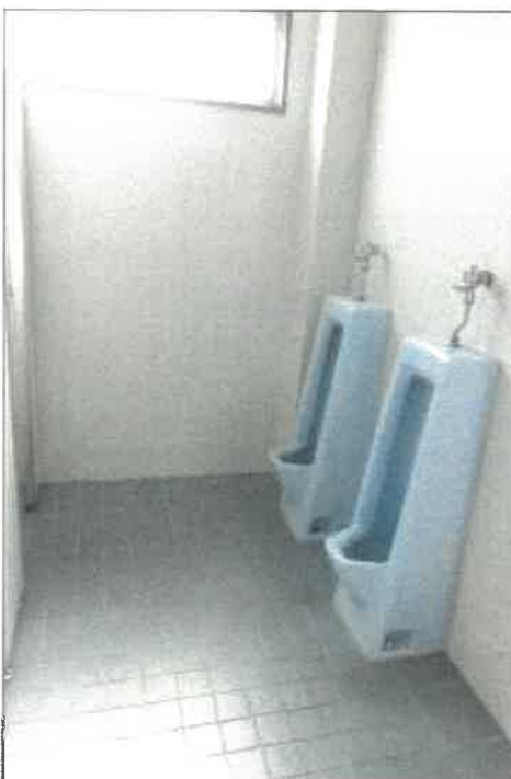
物件3 2部分2階男子トイレの状況
