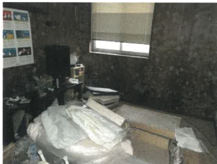
物件 3 4 建物の 1 階南西角和室の状況
