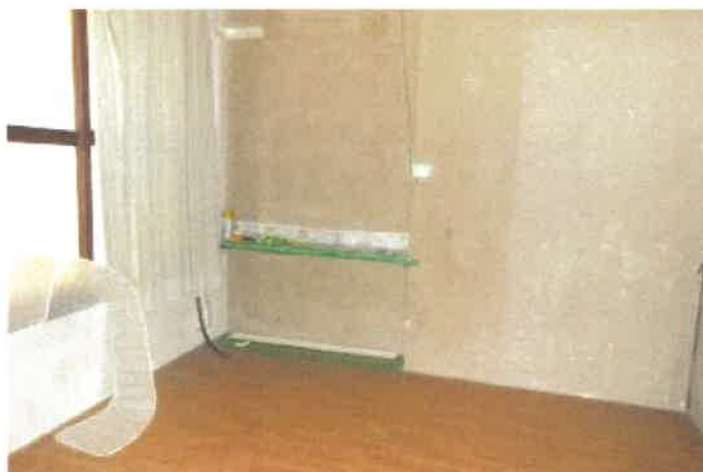
物件35建物増築部分Bの2階客室④の状況
