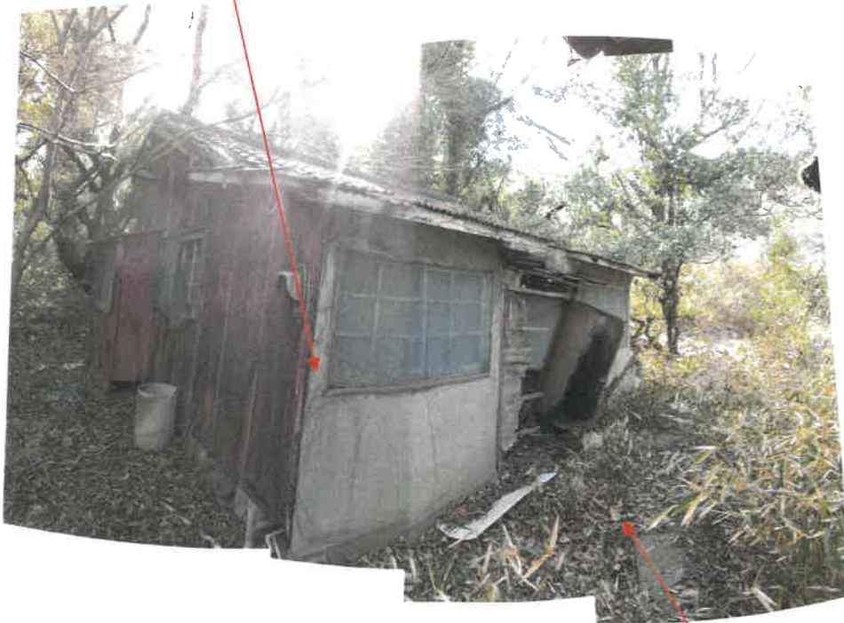
物件 3 0 主である建物の状況
