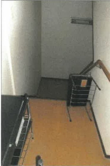
物件3 2部分2階から1階への階段の状況
