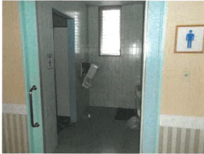
物件35建物の2階男子トイレの状況
