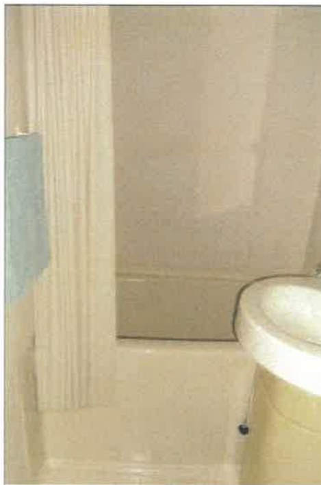
物件3 2部分3階客室⑥の状況
