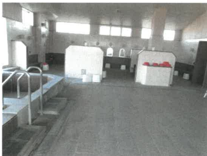
物件35建物3階の女性用洗室の状況
