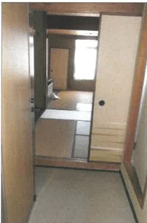
物件3 2部分3階客室⑦の状況
