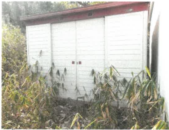
物件34建物南側のスチール製物置（動産）の状況
