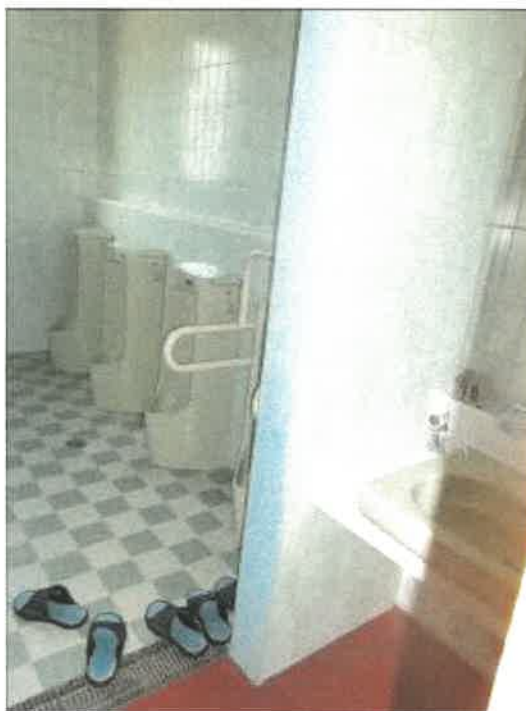
男子トイレ内の状況
