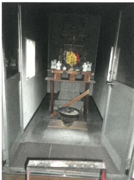
物件35未登記附属建物D(社)内の状況
