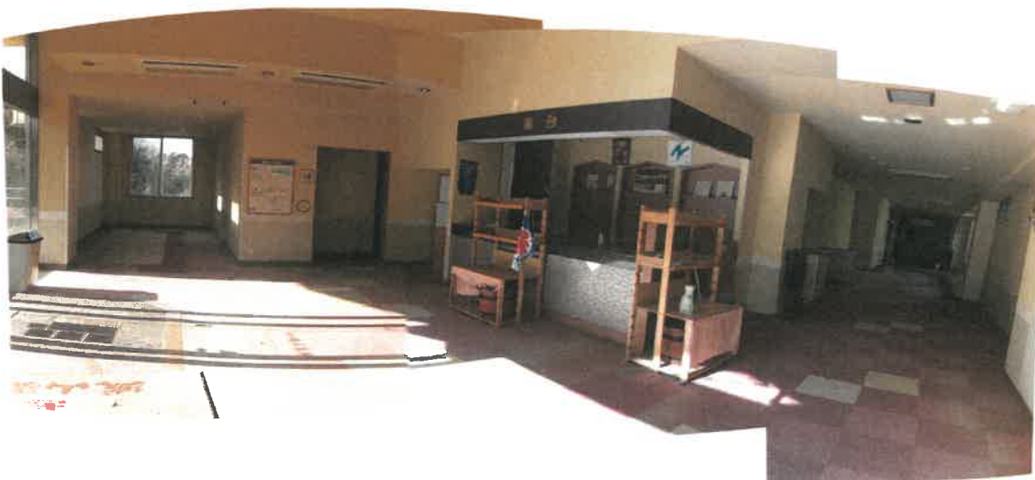
物件35建物の3階温泉出入口受付カウンター付近の状況
