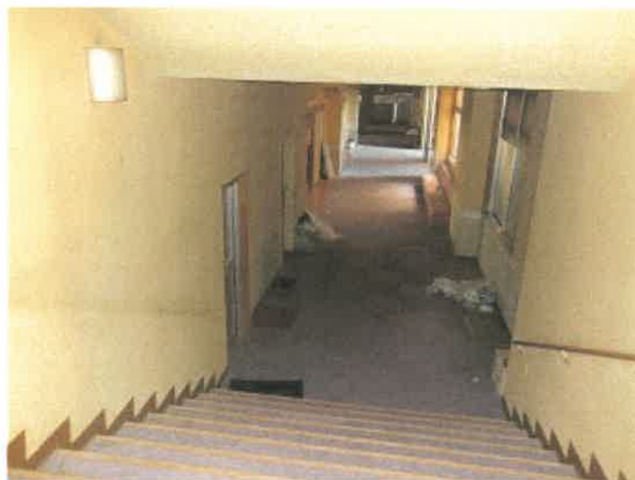
物件35建物の2階廊下（演劇場の2階出入口からの下り）状況
