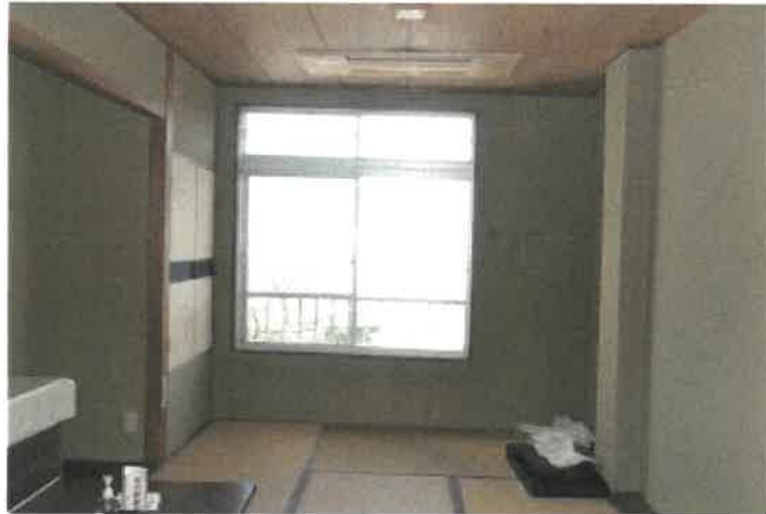
物件3 2部分 2階客室④の状況
