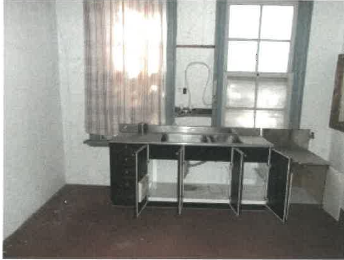
物件35未登記附属建物Cの2階台所の状況
