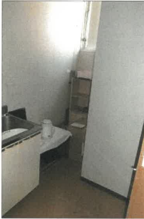
物件3 2部分 2階配膳室の状況
