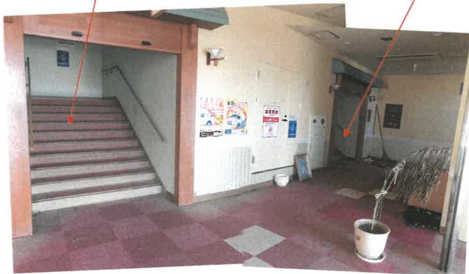
物件35建物の3階浴場出入口の状況
