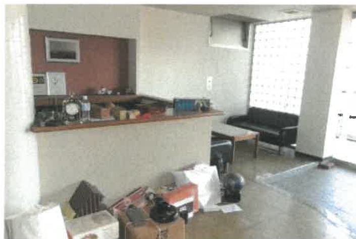
物件3 2部分1階ロビーの状況
