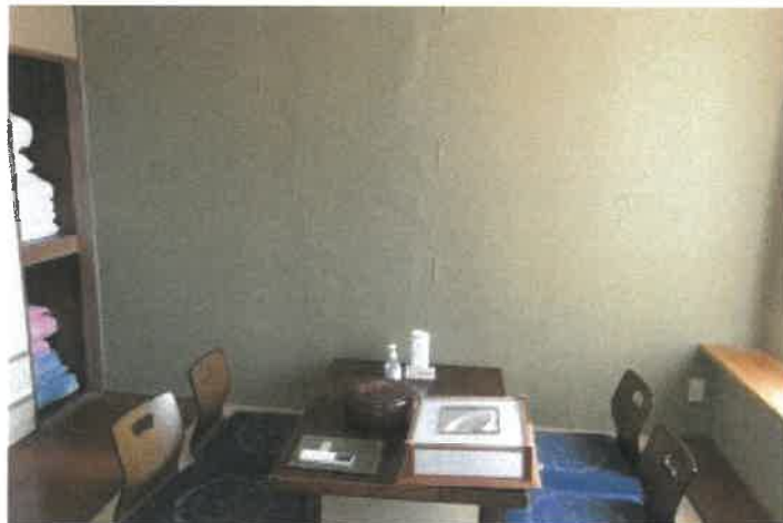
物件3 2部分3階客室⑤の状況
