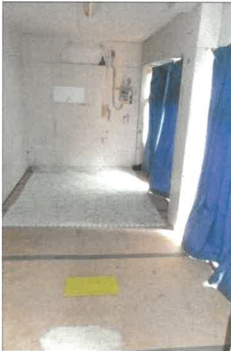
物件35建物増築部分A 1階（役者用宿泊ゾーンの宿泊部屋⑤）の状況
