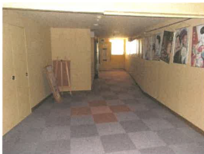
物件35建物の2階廊下から演劇場2階出入口（物件35増築部分A）への廊下の状況
