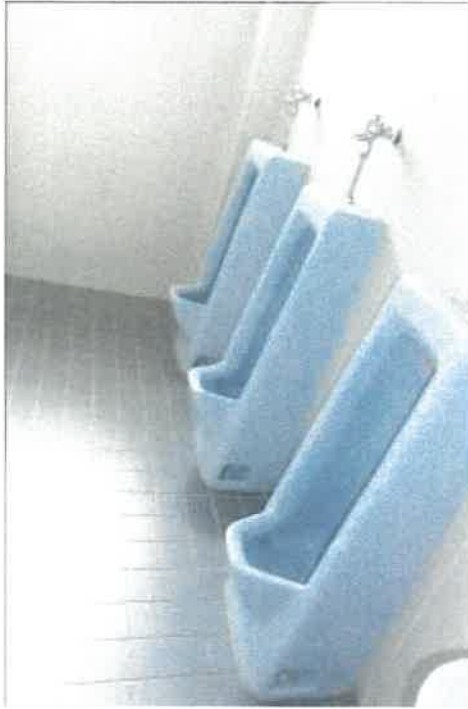
物件3 2部分1階男子トイレの状況
