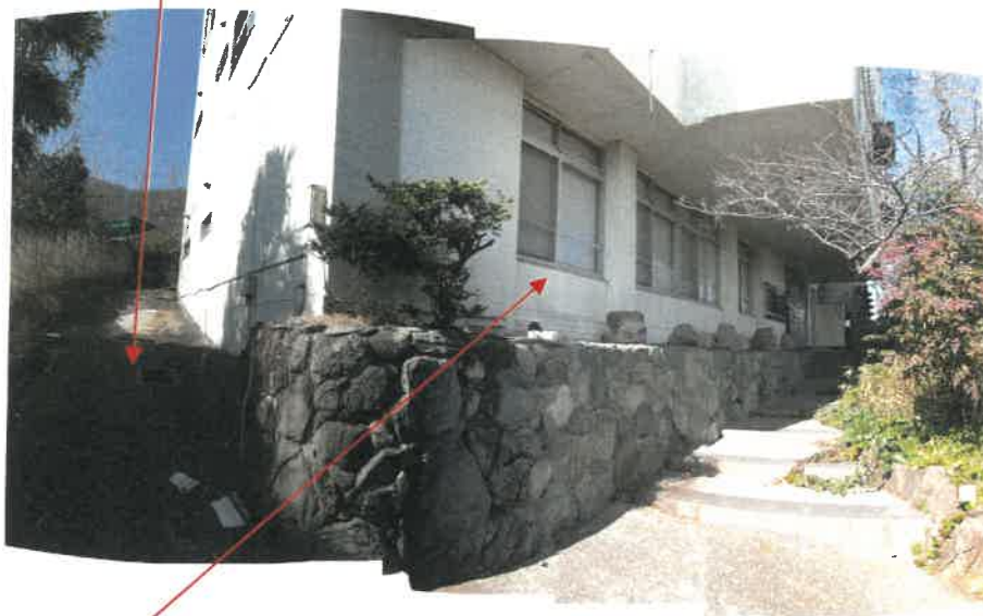
物件3 2部分北東側の状況
