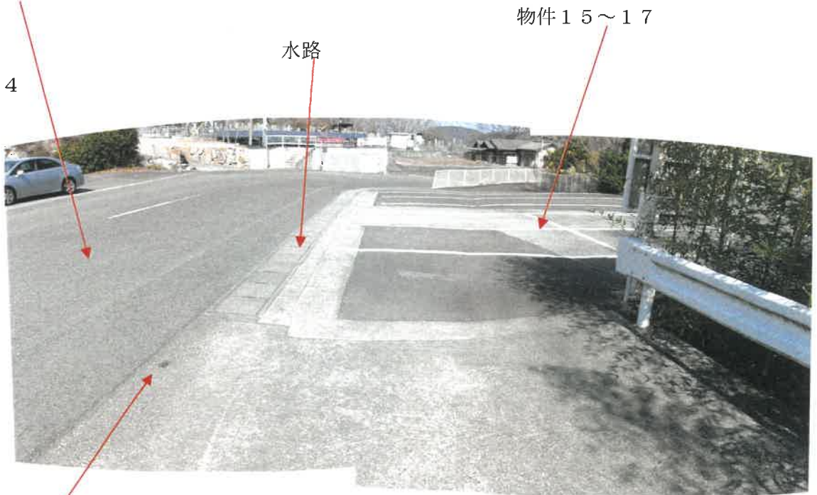
物件15~17西側及び南側境界付近の状況
