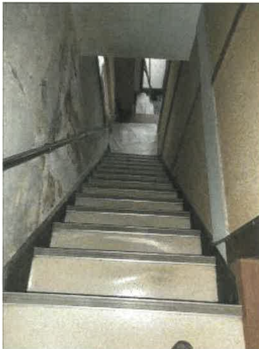
物件34建物の階段の状況
