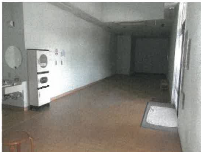
物件35建物3階の男性用浴室の脱衣所の状況
