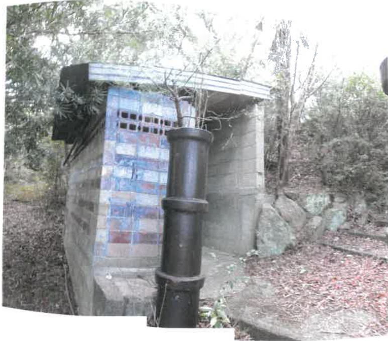
物件 3 5 未登記附属建物E の状況
