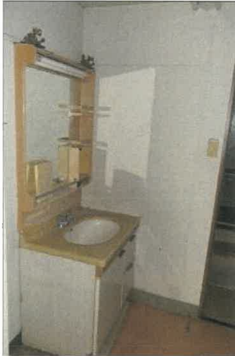
物件35建物増築部分A1階（役者用宿泊ゾーンの宿泊部屋①横の洗面所）の状況
