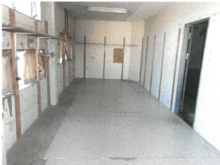
物件35建物増築部分A 2階（演劇場ステージの裏）の状況
