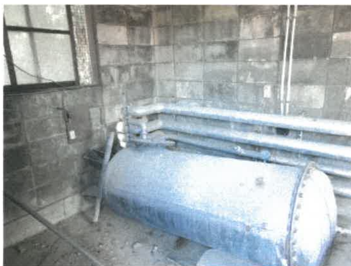
未登記附属建物F（旧ボイラー室）の状況
