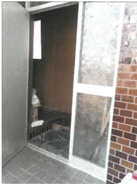
物件34建物の玄関付近の状況
