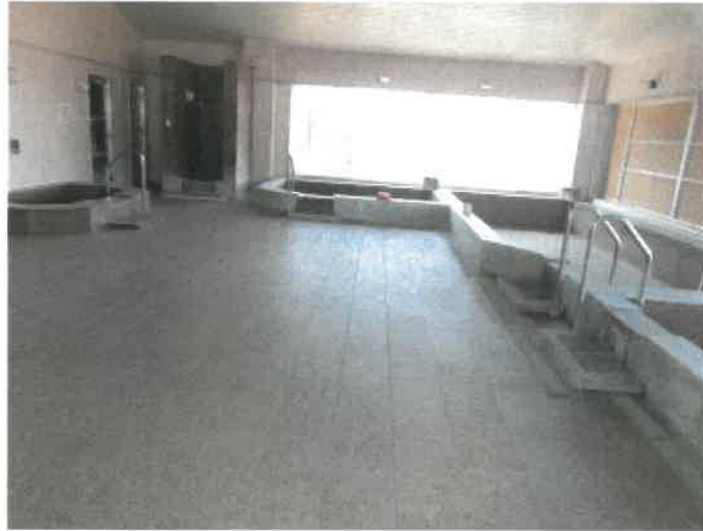
物件35建物3階の女性用洗室の状況
