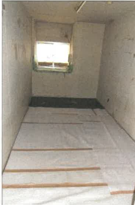
物件35建物増築部分A 1階（役者用宿泊ゾーンの宿泊部屋②）の状況
