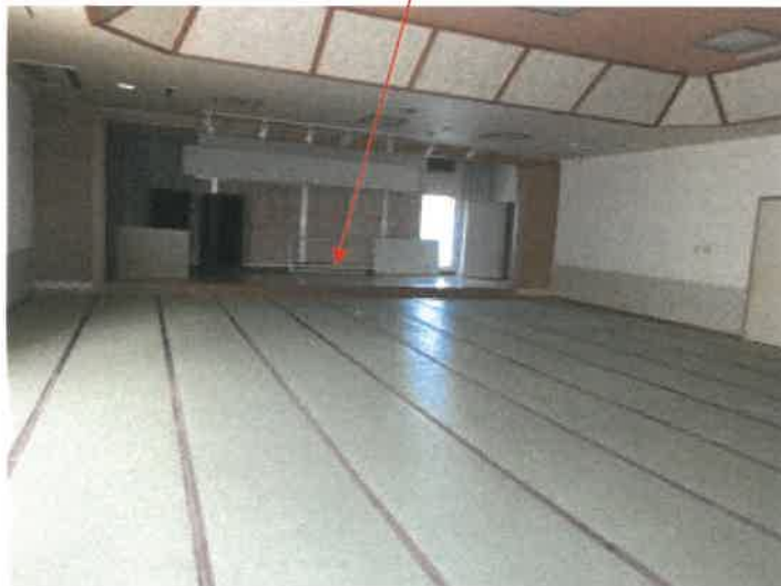
物件35建物の2階大広間北東側の状況
