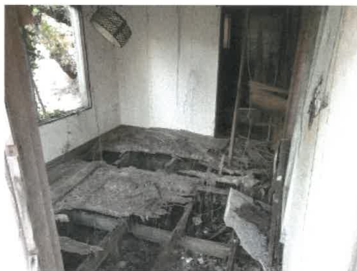
物件30附属建物符号2内部の状況
