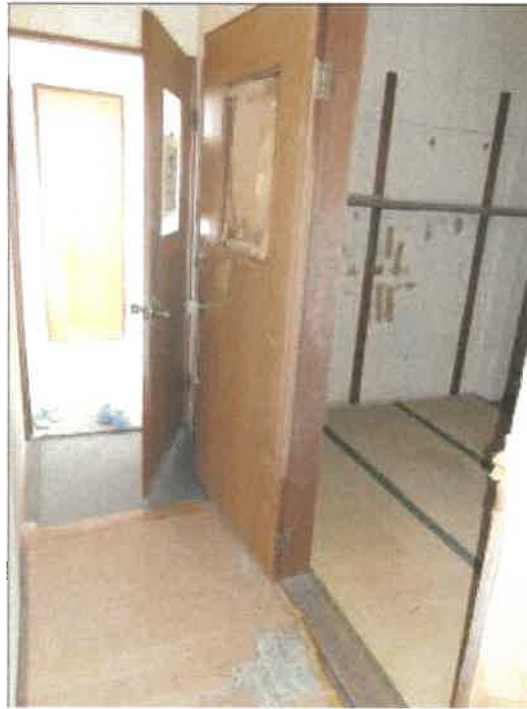
物件 3 5 建物増築部分 A 2 階（演劇場ステージ裏の役者控室）の状況
