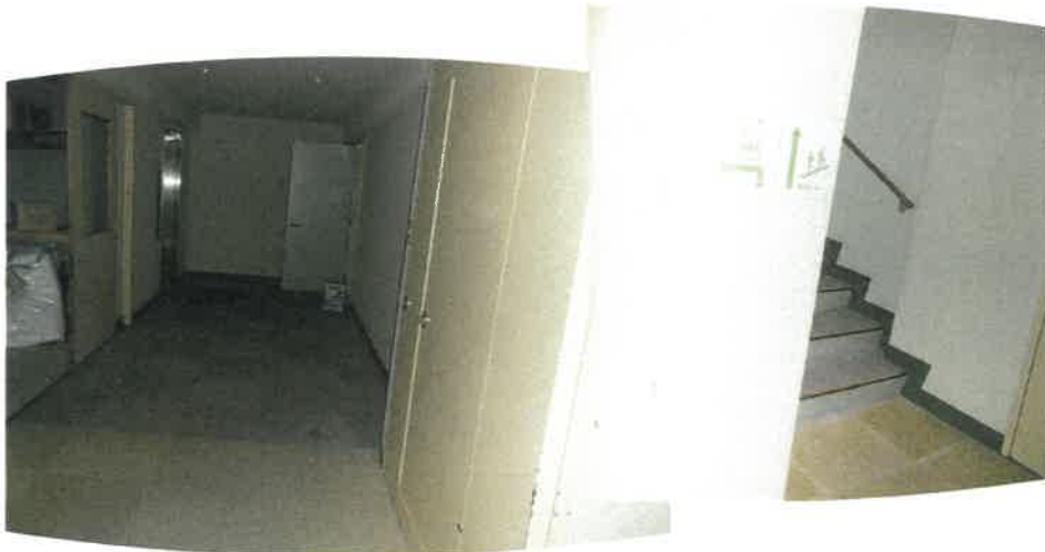
物件 3 5 建物の 1 階の階段付近及びエレベーター前廊下の状況
