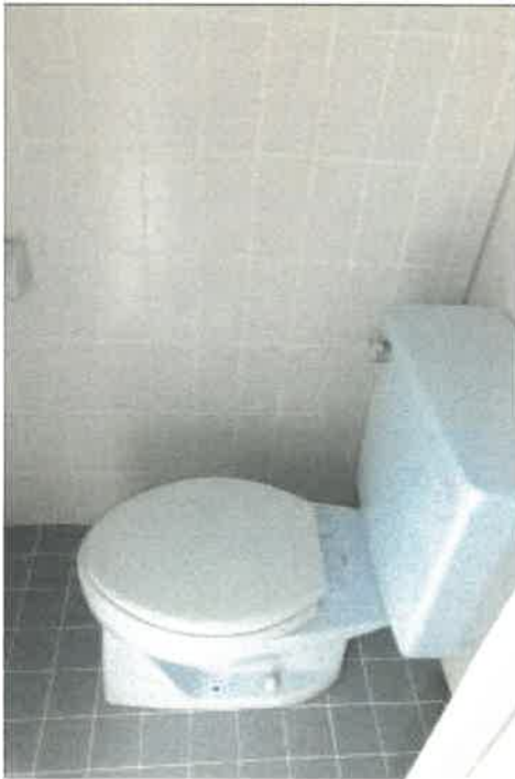
物件3 2部分1階男子トイレの状況
