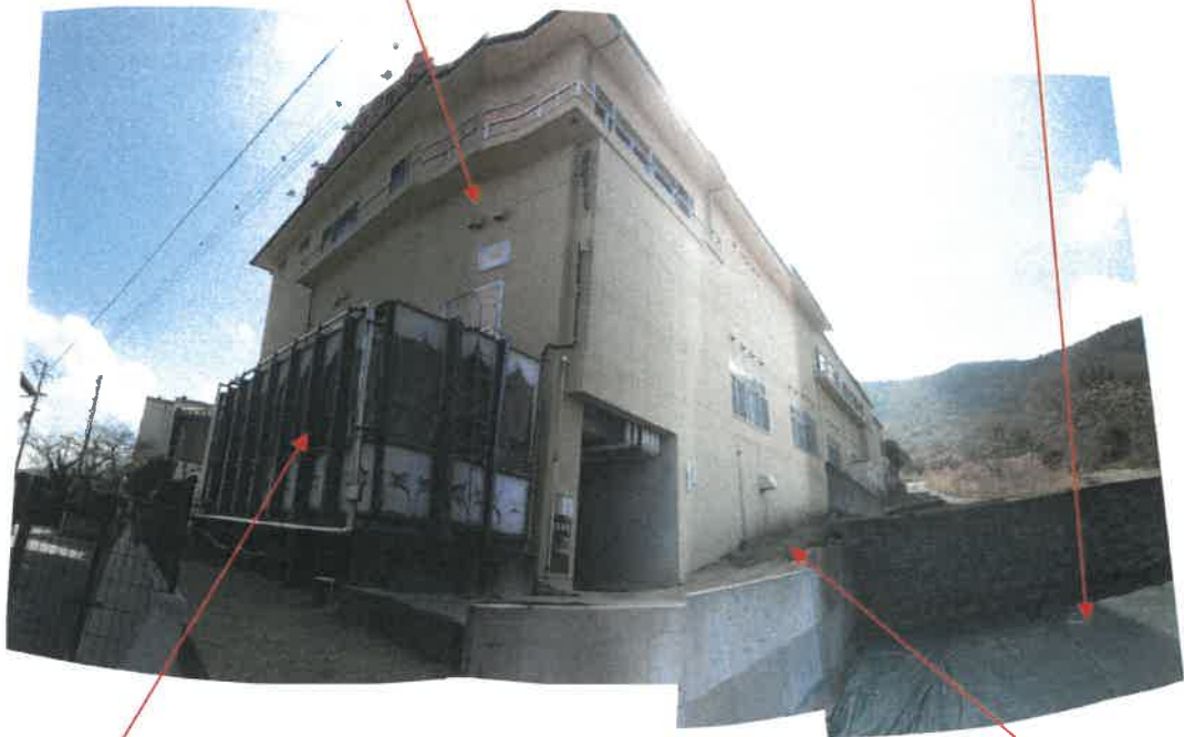
物件35建物北西側及び北東側の状況
