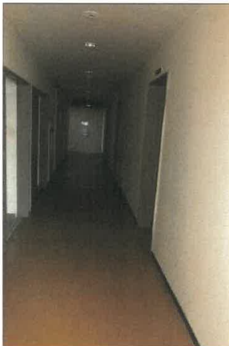
物件3 2部分3階の廊下の状況
