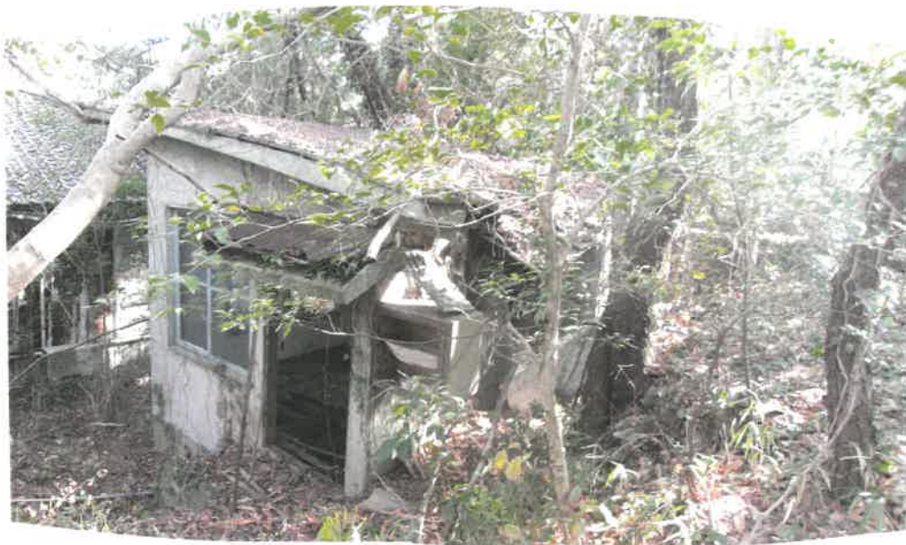
物件30附属建物符号2の状況
