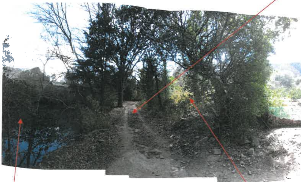
物件 18 土地南西側境界及び物件 19 土地西側境界付近の状況
