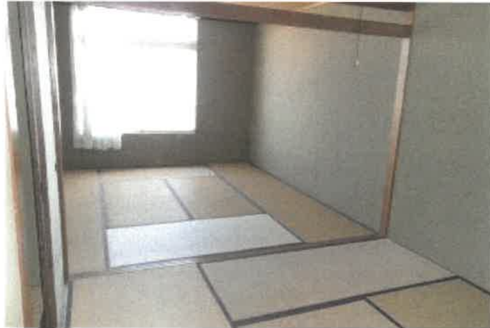
物件3 2部分3階客室⑤の状況
