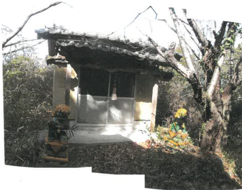
物件35未登記附属建物Dの正面の状況
