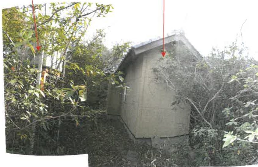
物件35未登記附属建物Dの裏側の状況
