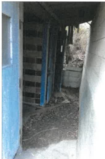
物件 3 5 未登記附属建物E の状況
