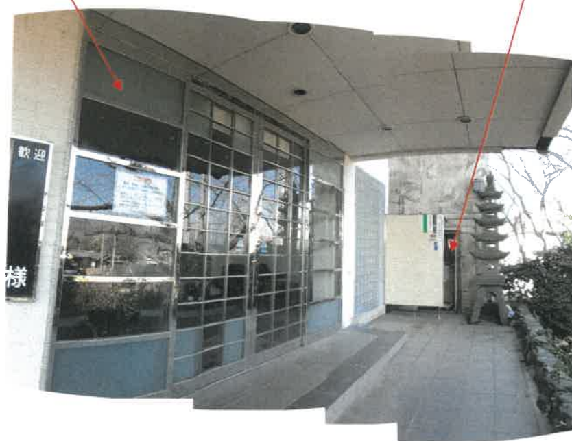
物件3 2部分1階出入口付近の状況
