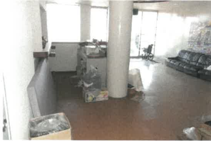
物件3 2部分1階ロビーの状況
