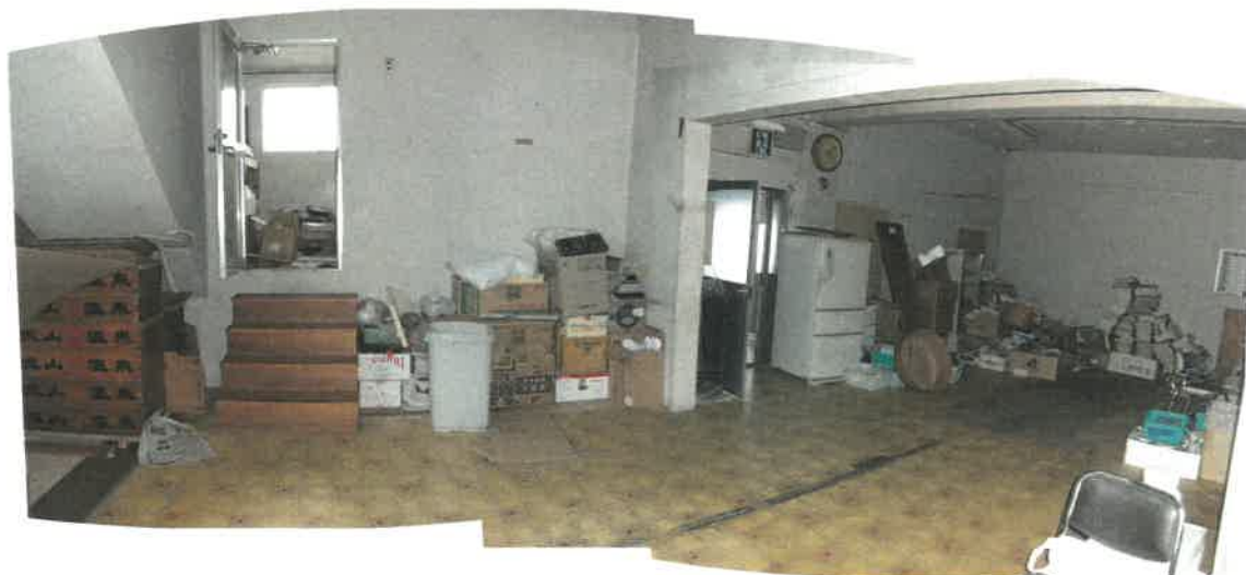
物件35建物南東側の倉庫（増築部分；元厨房）の状況
