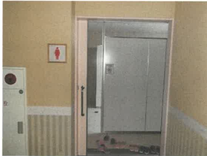
物件35建物の2階女子トイレの状況
