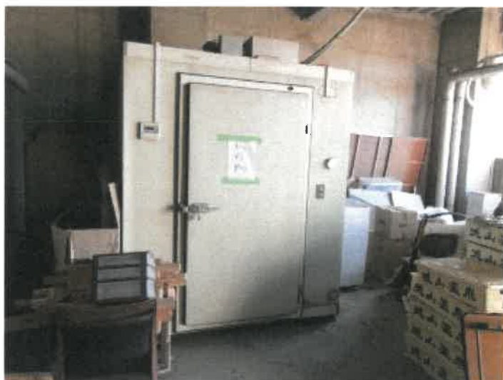
2階大広間の南西側厨房の更に南西側のピロティー内の私有物と表示されている物の状況
