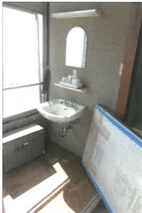
物件3 2部分 3階客室⑨状況
