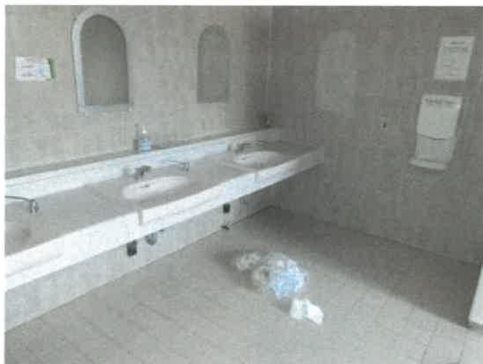
物件35建物の2階女子トイレの状況
