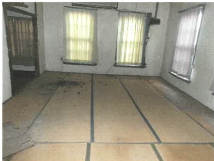
物件35未登記附属建物Cの2階東側和室2間の状況
