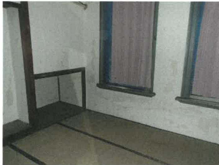
物件35未登記附属建物C 2階和室の状況
