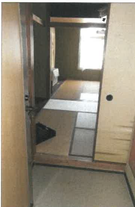
物件3 2部分3階客室⑥の状況
