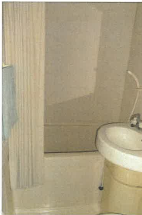
物件3 2部分3階客室⑤の状況
