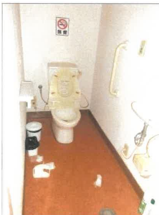
物件35建物3階の女性用脱衣場のトイレの状況
