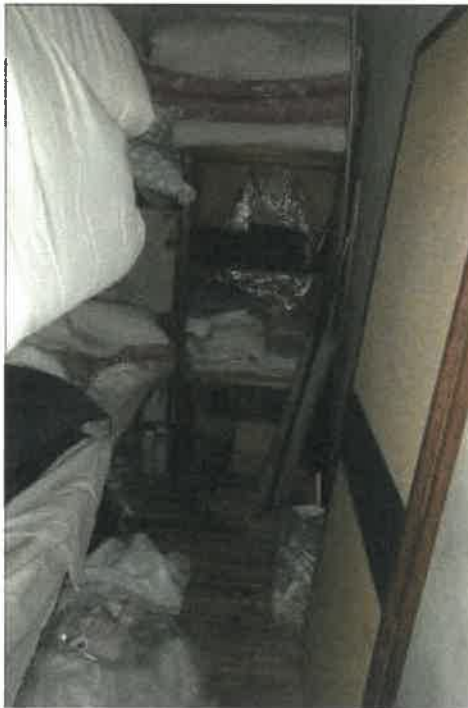
物件3 2部分 2階リネン室（北西側）の状況
