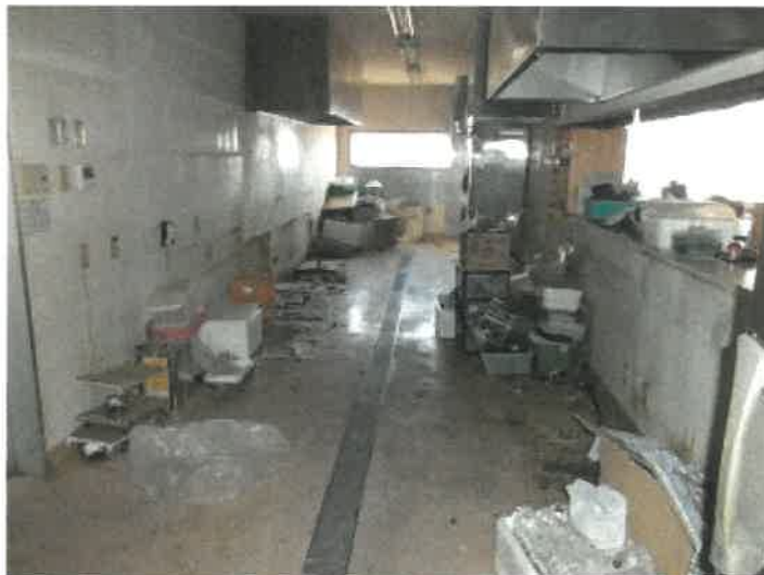
物件 3 5 建物の 2 階大広間南西側の厨房の状況
