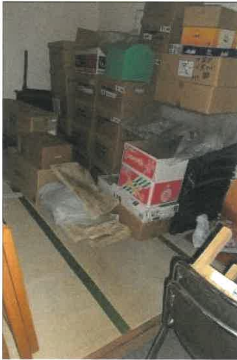
物件 3 2 部分 1 階配膳室（南東側）の状況
