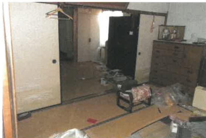
物件3 1部分の1階南東側事務室北西側の和室及び北西角和室2間の状況
