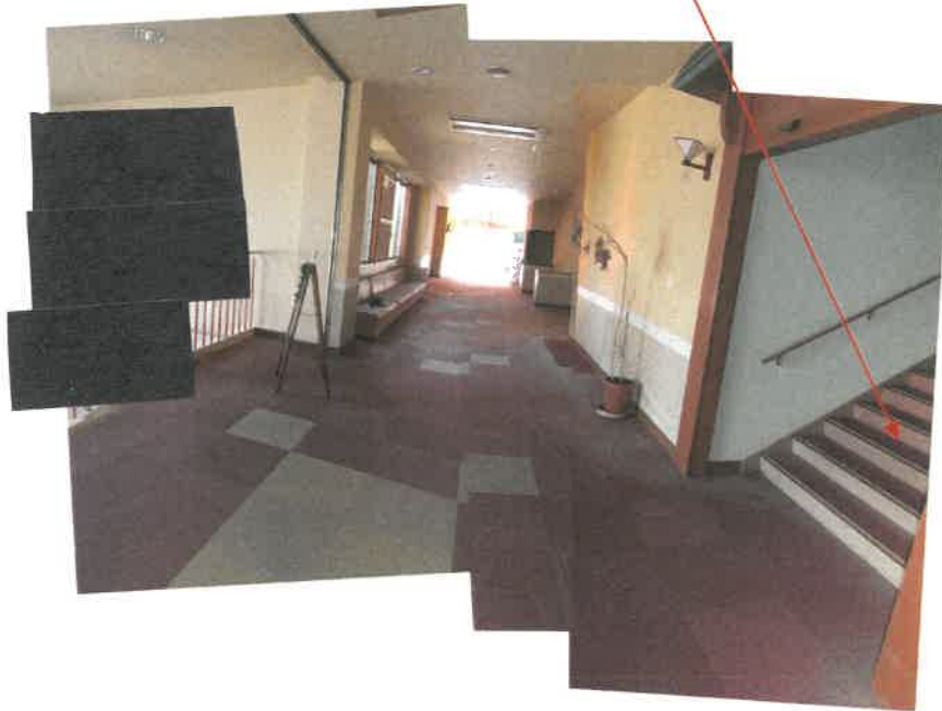
物件35建物の3階廊下の状況
