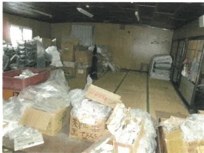
物件3 1部分の2階広間（宴会場）の状況
