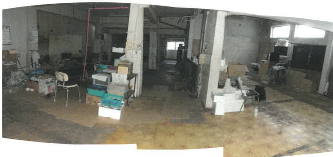
物件35建物増築部分B南東側の倉庫（元厨房）の状況
