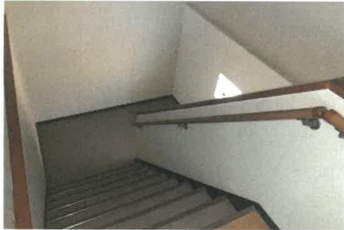
物件3 2部分3階から2階への階段の状況
