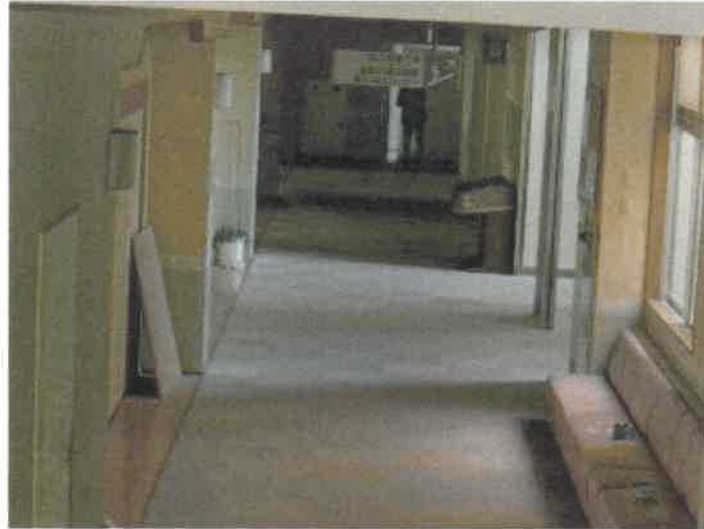
物件35建物の2階廊下の状況
