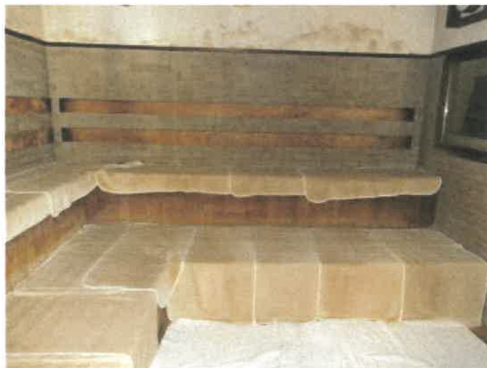
物件 3 5 建物 3 階の男性用浴室のサウナの状況
