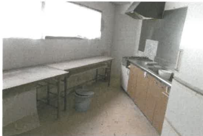
物件35建物増築部分A1階（役者用宿泊ゾーンのキッチン）の状況
