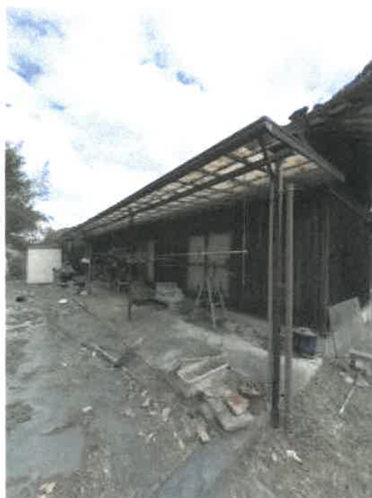
物件 2 南西側の状況
