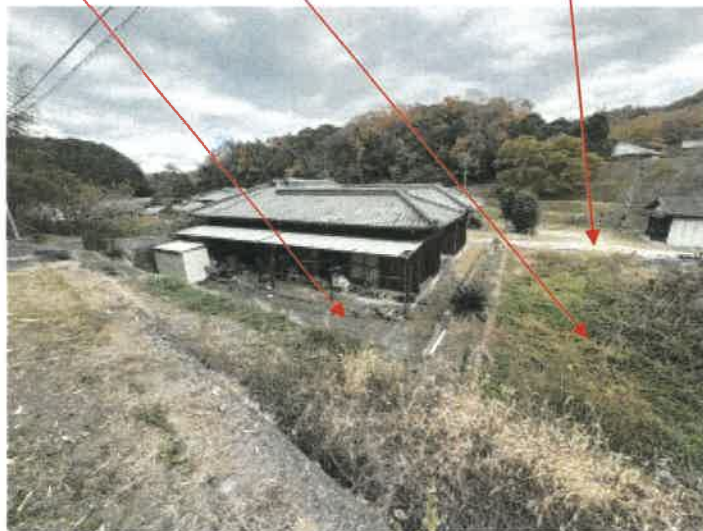
物件1 南西側の状況
