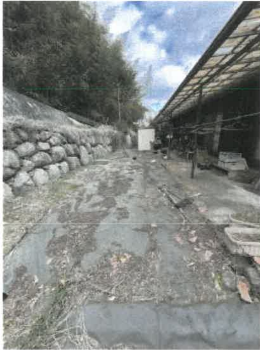
物件1 南西側の状況
