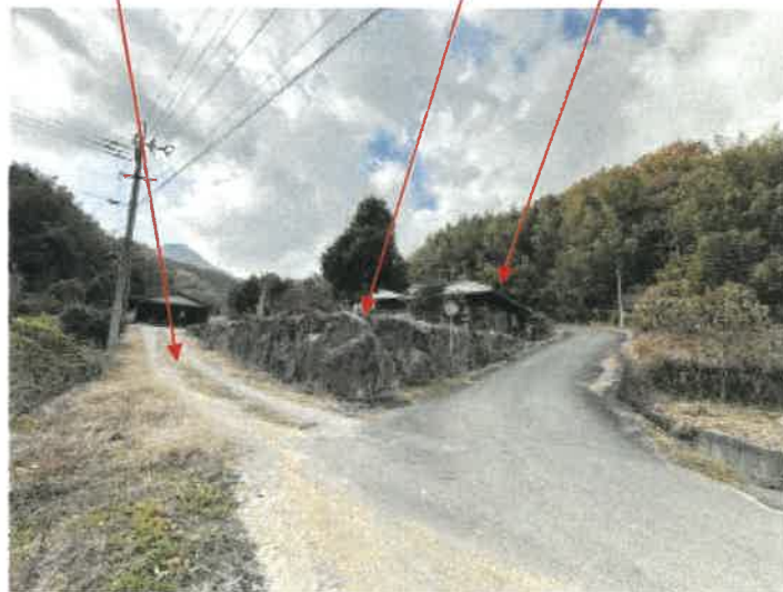
物件 1 北東側の状況
