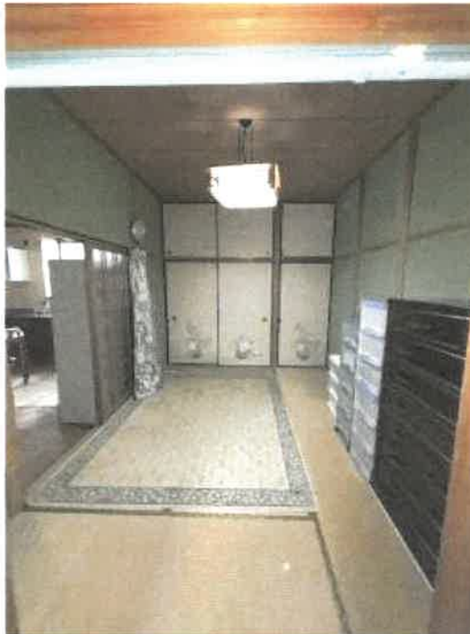
物件 2 北側和室の状況
