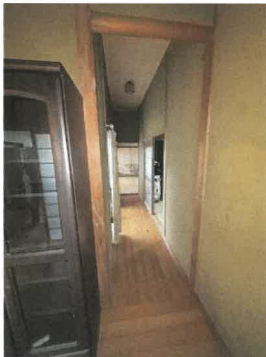
物件2 北西側廊下の状況
