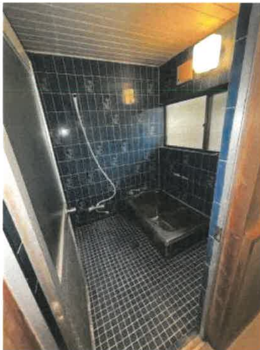
物件 2 浴室の状況
