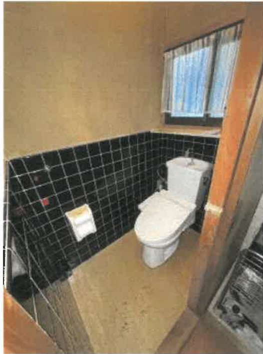
物件2 トイレの状況
