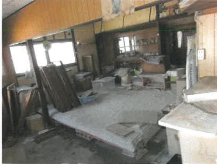
物件 1 5 建物の 1 階東側倉庫の状況
