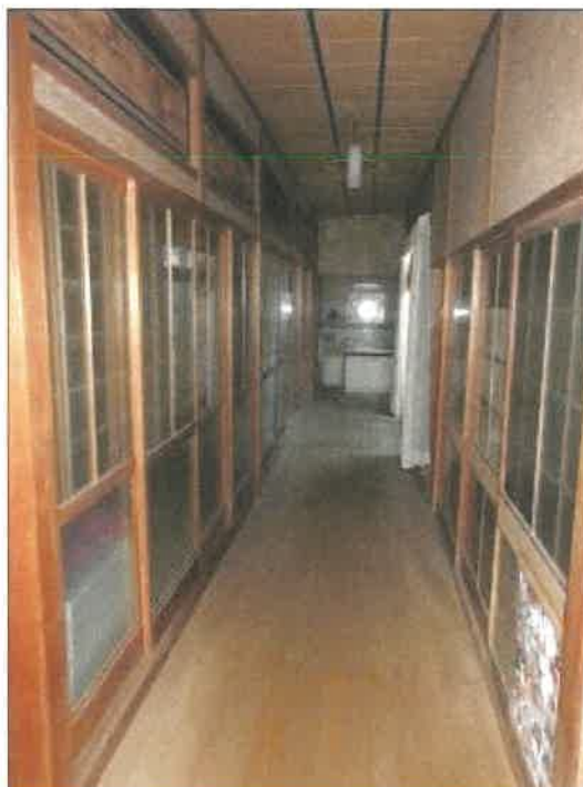
物件 1 5 建物の 1 階北ゾーンと南ゾーンの間廊下の状況
