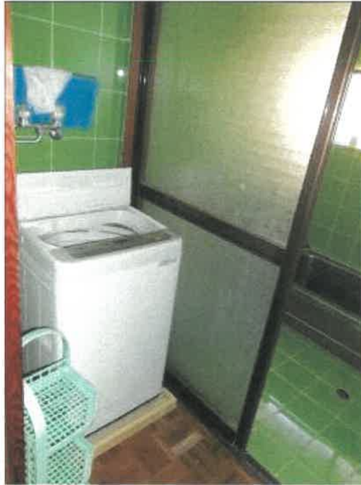
物件15建物の1階北側ゾーンの洗面脱衣所の状況
