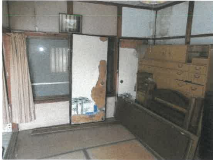
物件15建物の2階東側和室の状況
