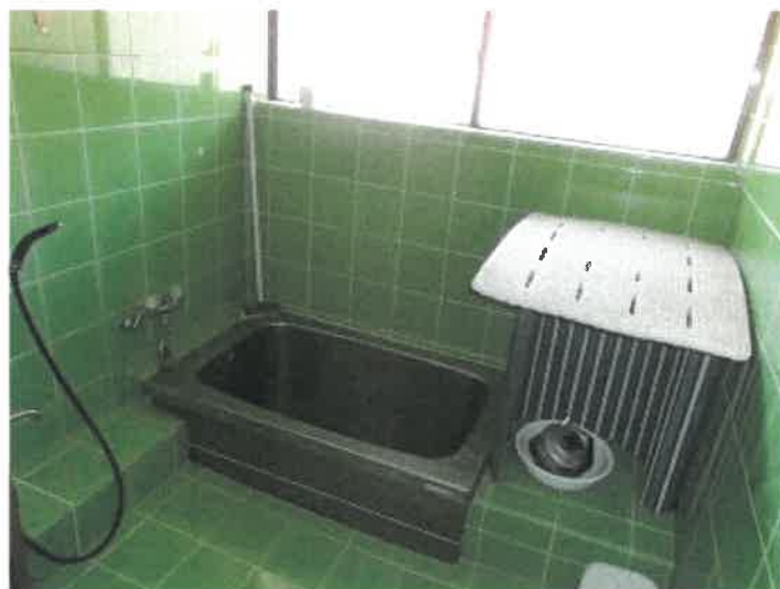
物件15建物の1階北側ゾーン浴室の状況
