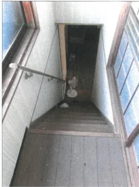
物件15建物の階段の状況
