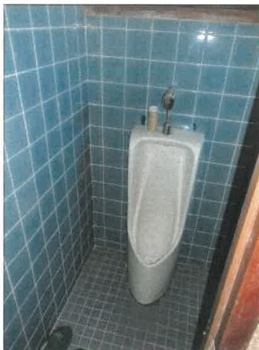
物件15建物の1階北ゾーン西端のトイレ（小）の状況
