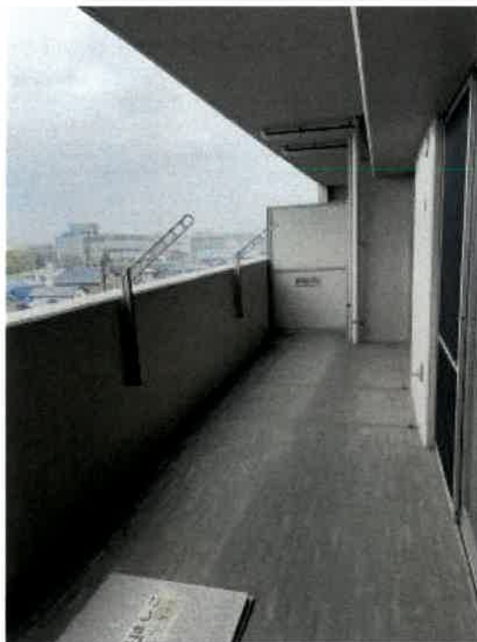
南側バルコニーの状況
