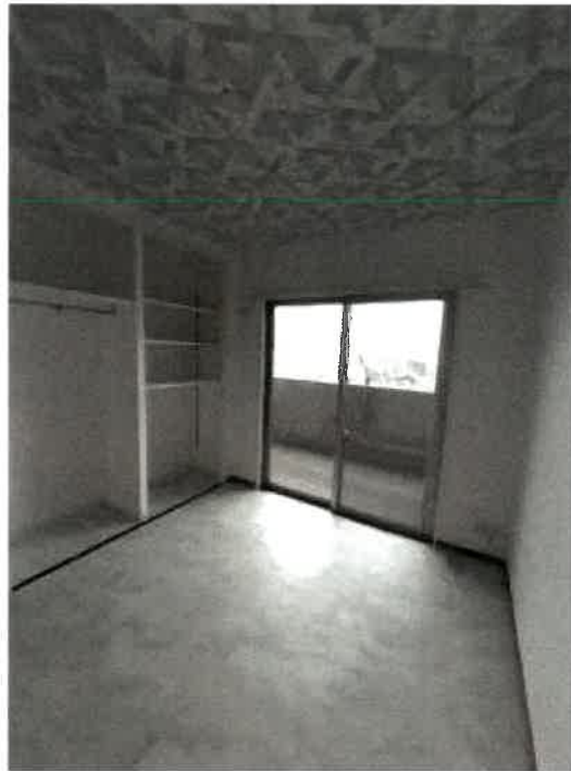
南側洋室の状況
