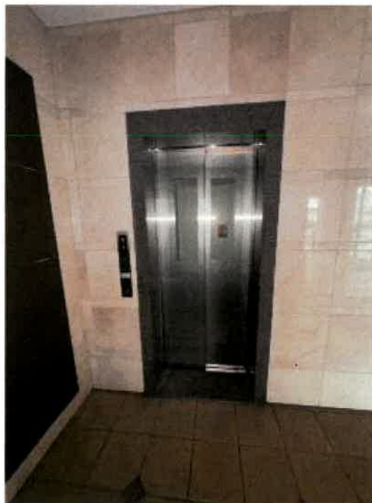
エレベーターの状況
