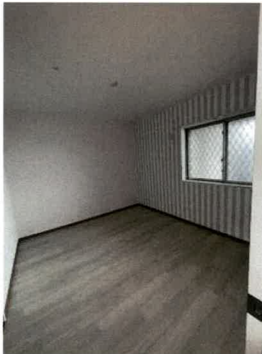
北西側洋室の状況
