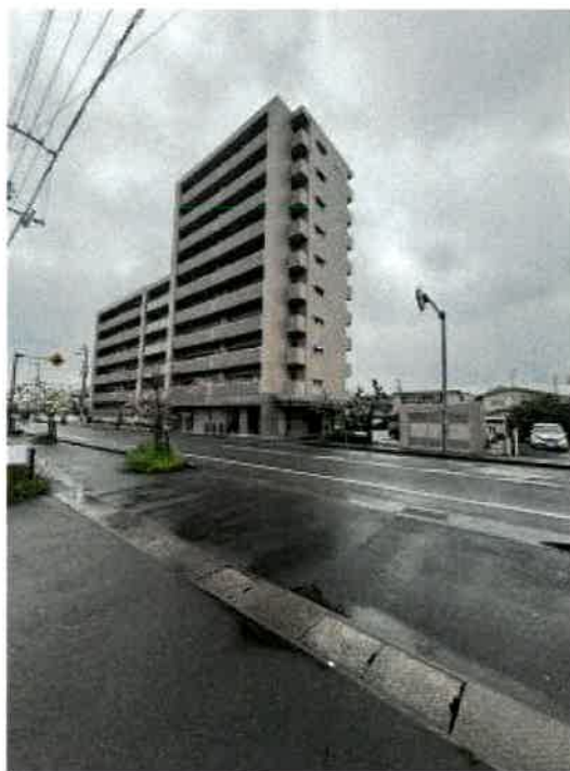
本件マンションの外観
