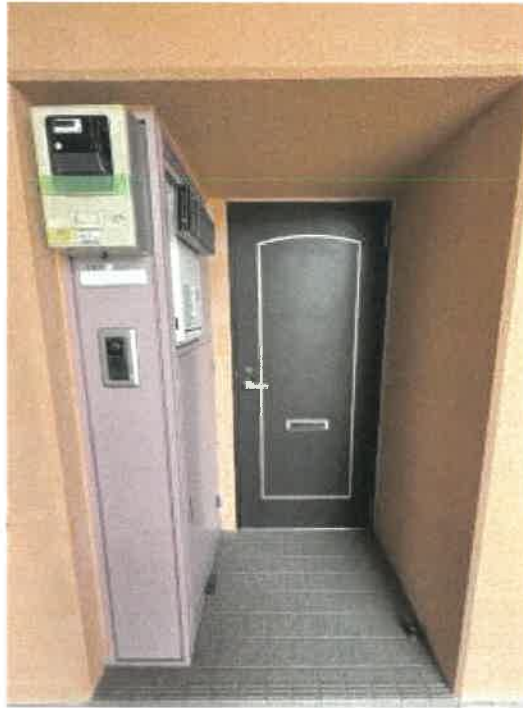
本件物件玄関付近の状況
