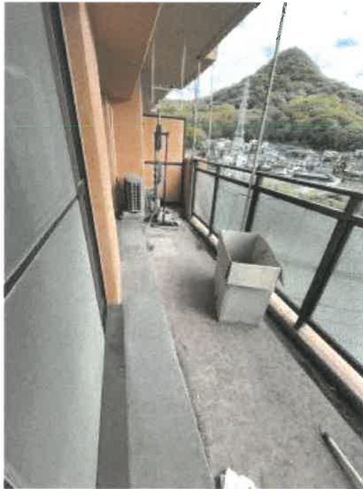
バルコニーの状況
