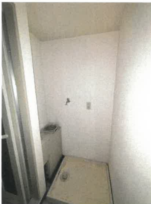
洗濯パンの状況
