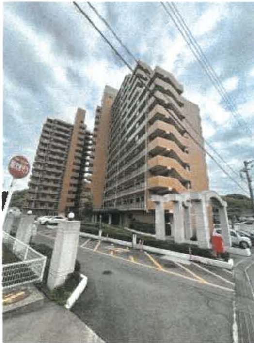
本件マンションの外観
