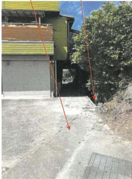
物件1 南側の状況
