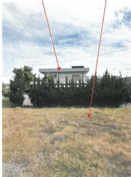
物件1 北側の状況
