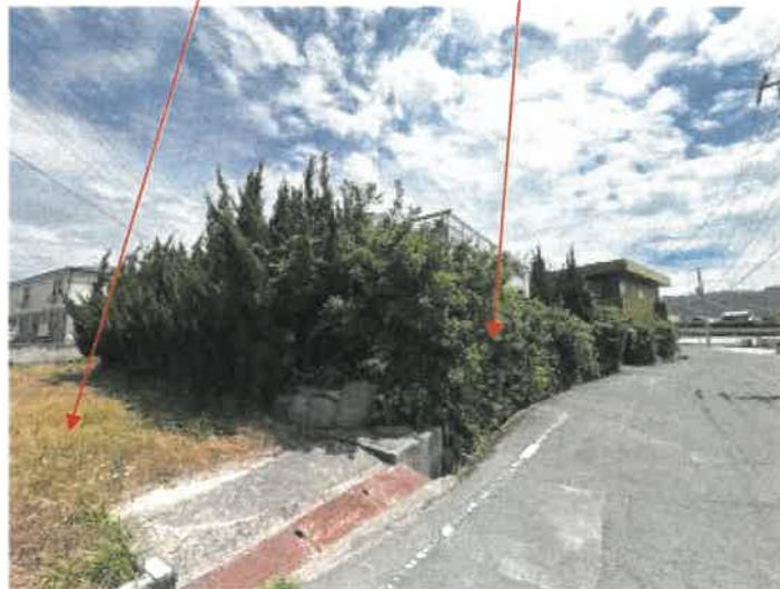
物件1 北西側の状況
