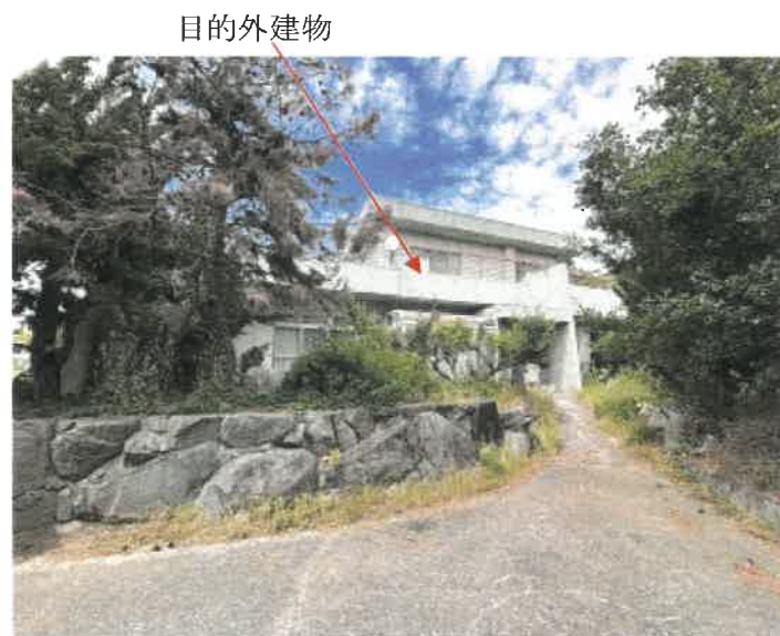
物件 1 中央から北側の状況
