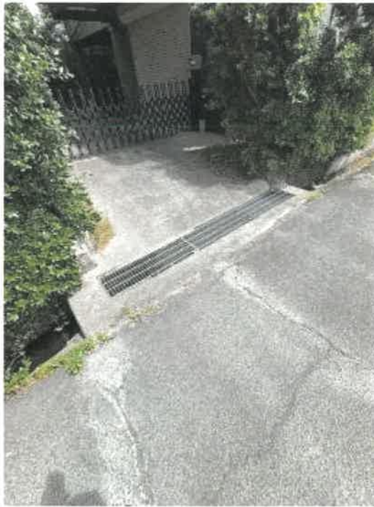
物件 1 西側の状況
