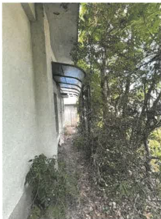
物件1 北東側の状況
