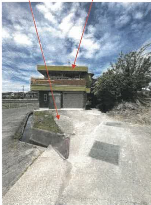
物件 1 南西側の状況
