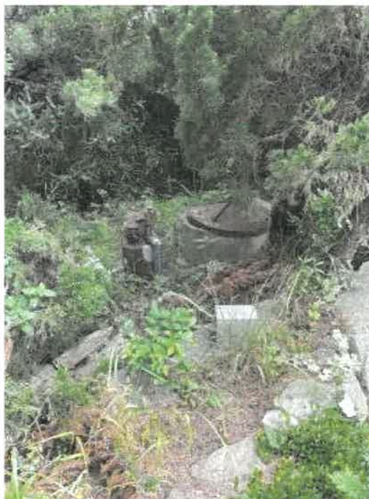
物件1 東側井戸の状況
