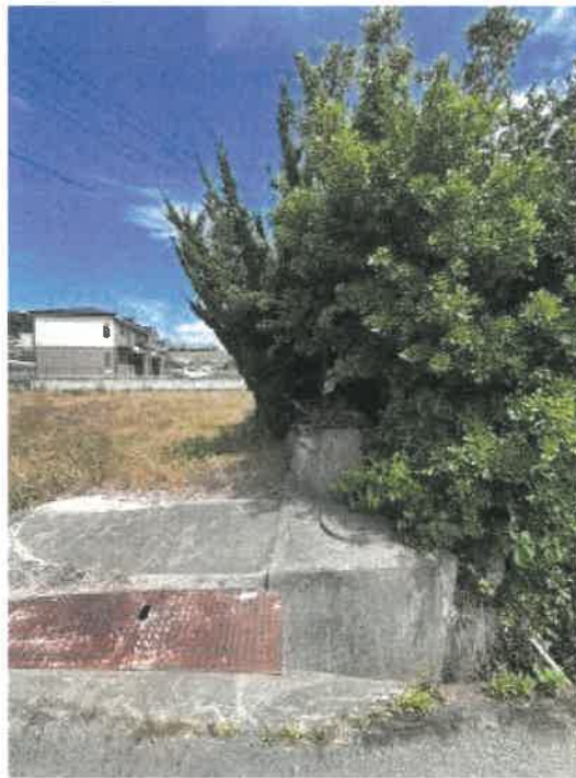
物件1 北西角の状況
