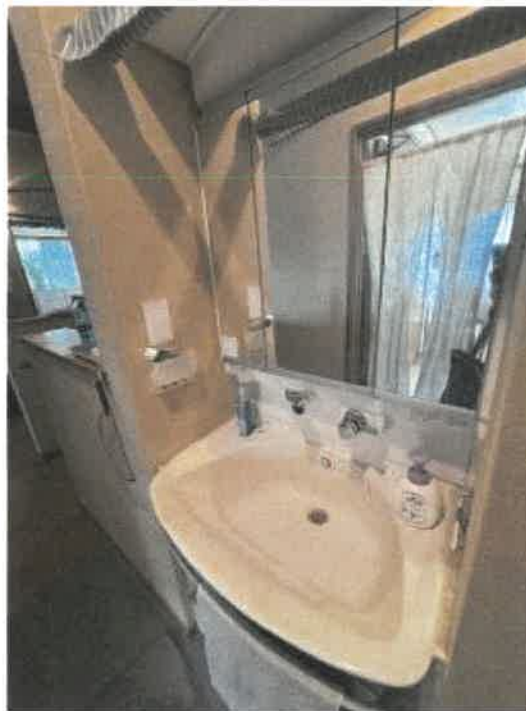
物件 2 2階手洗の状況
