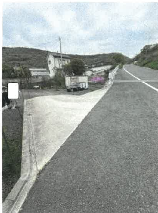
物件1 南西側の状況
