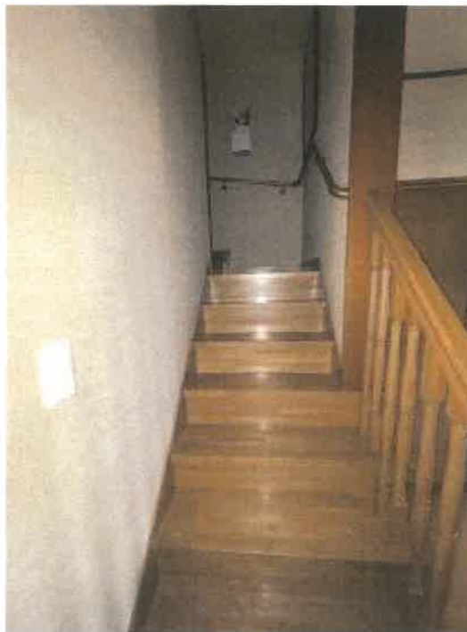
物件2 階段の状況
