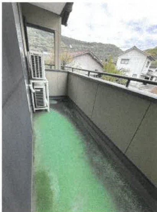
物件 2 2階南東側バルコニーの状況
