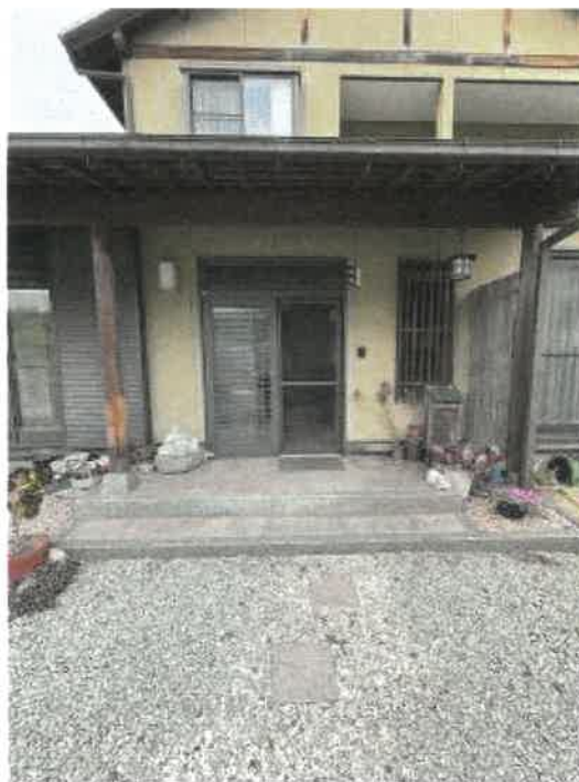
物件 2 玄関付近の状況
