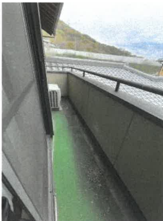
物件2 2階西側バルコニーの状況
