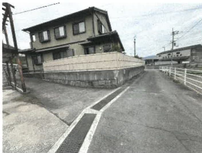
物件1 北東側の状況
