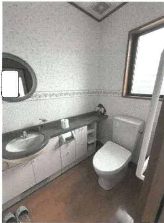
物件2 1階トイレの状況
