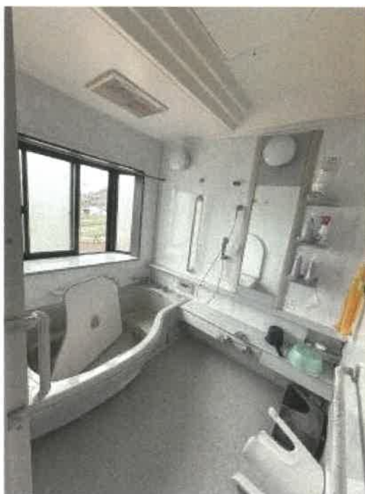
物件2 1階浴室の状況
